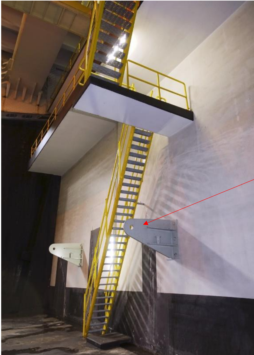
In de zuidwand van de basculepijler zijn stalen bevestigingen met open ogen gemaakt waarin het ballastblok kan worden vastgekoppeld bij open toestand.
