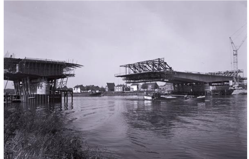
Zicht op de bouwwerkzaamheden bij de Maasbrug bij Wessem in 1964. RWS beeldbank, Afdeling Multimedia Rijkswaterstaat, nr. 24516-004.
