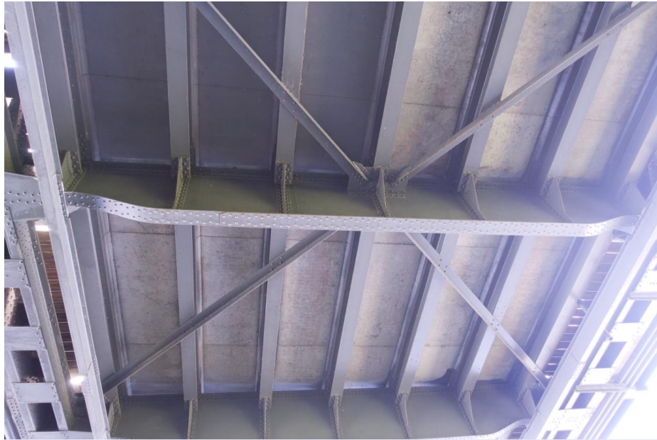
Zicht op het onderwindverband in kruisverband met L-profiel bij het zuidoostelijke brugdeel.
