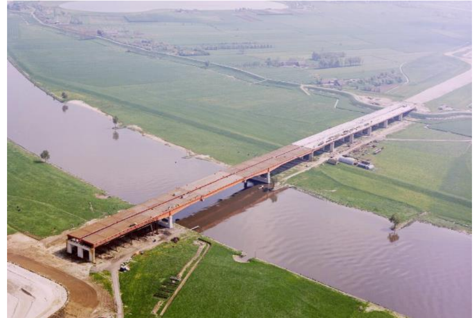
Luchtfoto van de in aanbouw zijnde Hagesteinsebrug in 1978 over de Lek in de Rijksweg 27 te Vianen, uit het noordwesten. UA beeldbank, coll. Delta-Phot Luchtfotografie, nr. 50561.
