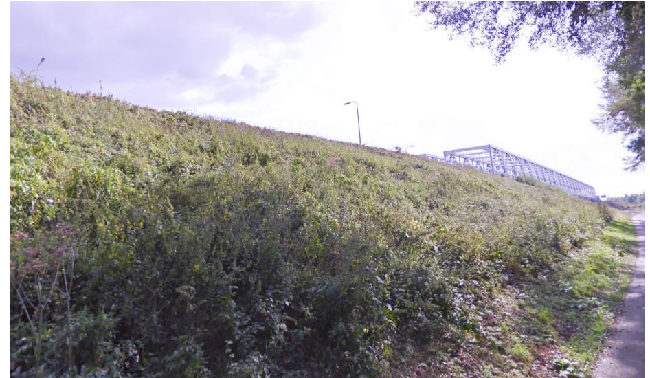
Zicht op de natuurlijke wal bij de noordelijke oprit. afb: Google Maps 2018.
