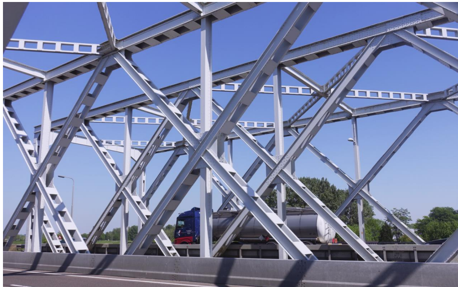
Zicht op de vakwerk constructie in ruitvorm bij de noordelijke brugdelen.
