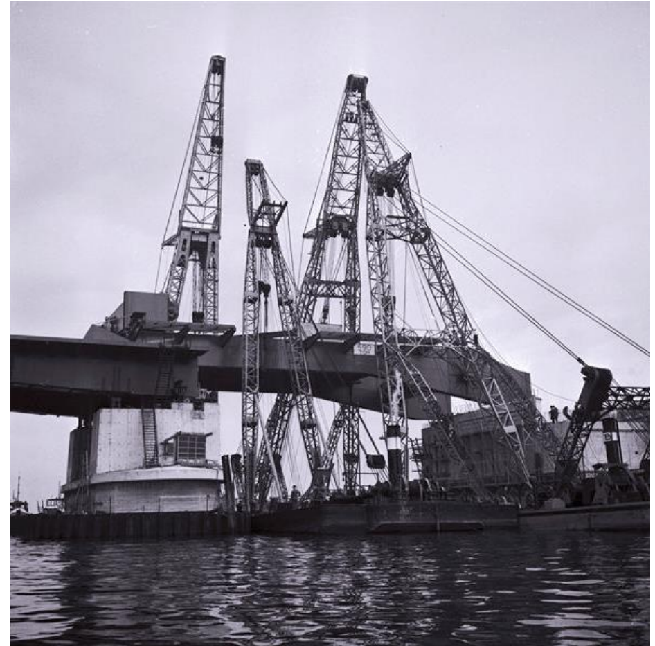
Zicht op het invaren van het val bij het basculedeel van de Merwedebrug. RWS beeldbank, Afdeling Multimedia, nr. 24037-011.
