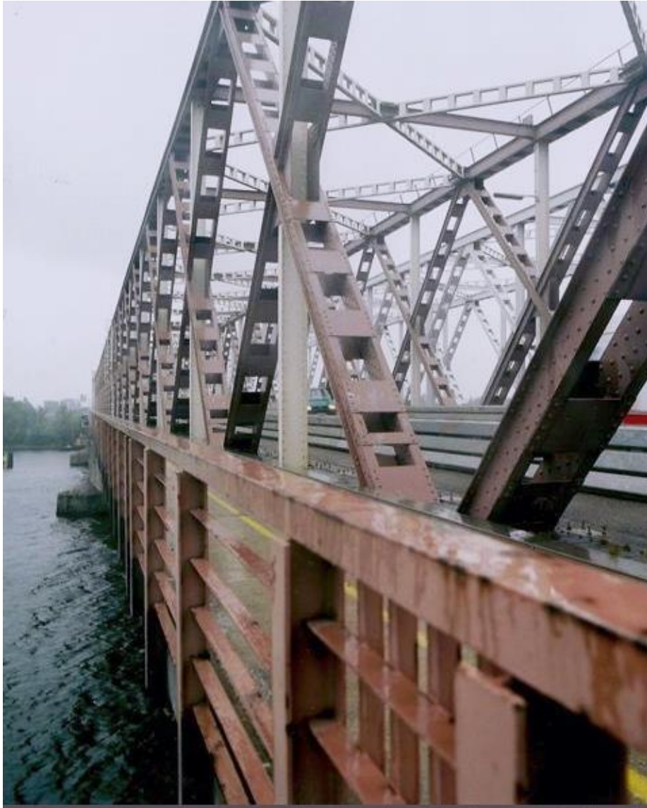
De kleurafwerking van de vakwerkbovenbouw en leuning langs het fietspad heeft in 2003 een rode kleur, in combinatie met grijs/wit. Na groot onderhoud in 2004 zou de huidige kleur worden aangebracht. RWS beeldbank nr. A27-2004-003.
