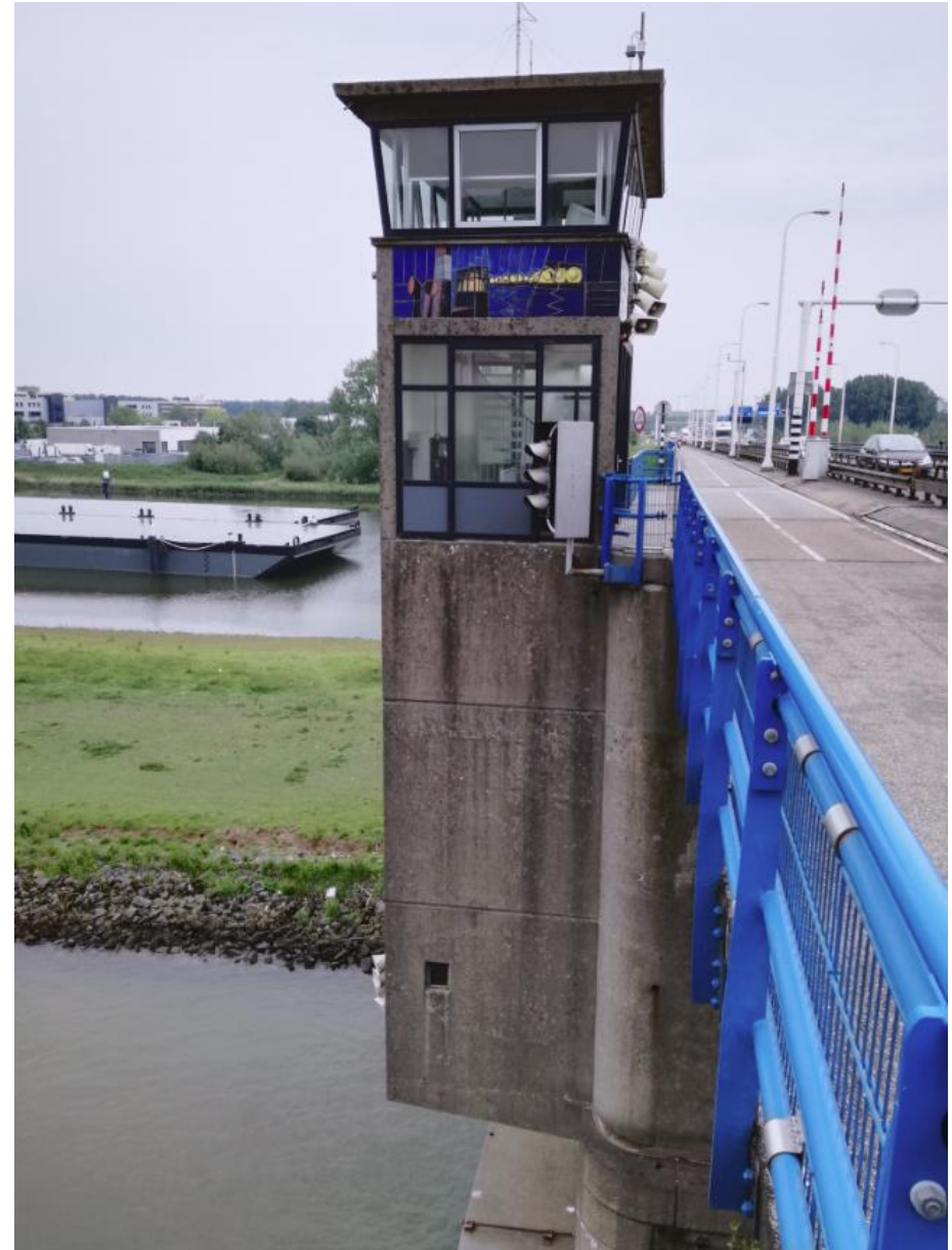
Zicht op het brugwachtershuis gezien vanaf het val van de basculebrug.
