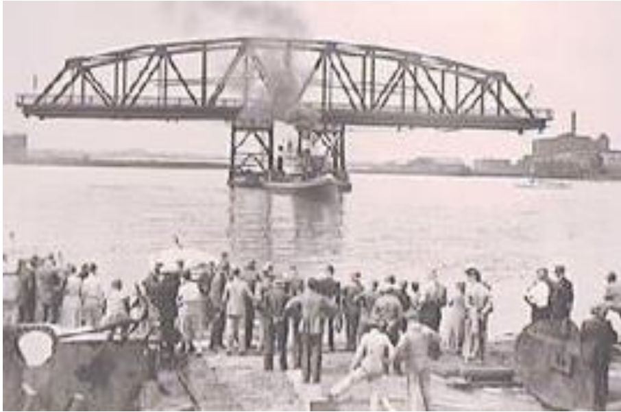
Het invaren van een brugdeel bij de bouw in 1933 van de brug bij Muiden over het Amsterdam-Rijnkanaal. RWS beeldbank nr. 22645-021.
