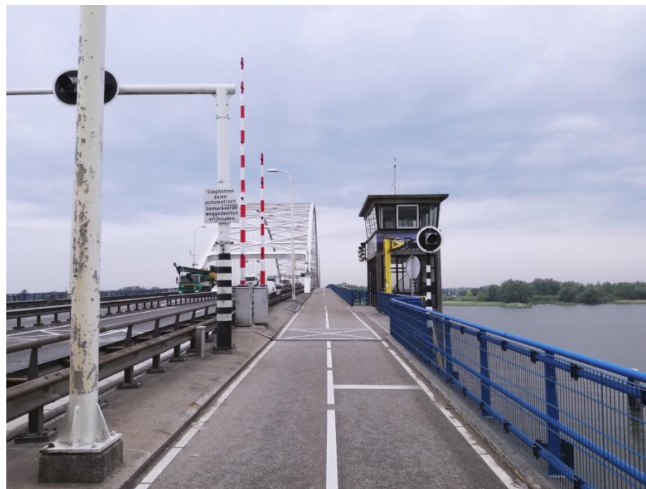
Aan de westzijde van de basculebrug is een brugwachtershuis gesitueerd vanwaar de brug bediend wordt.
