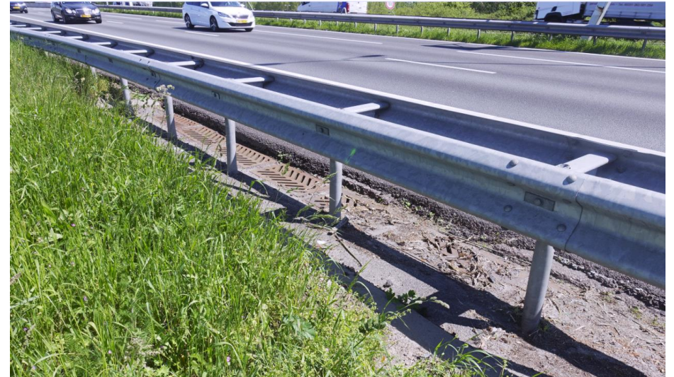
Detail van de vangrail uit 1980 ter hoogte van de noordzijde van de brug.
