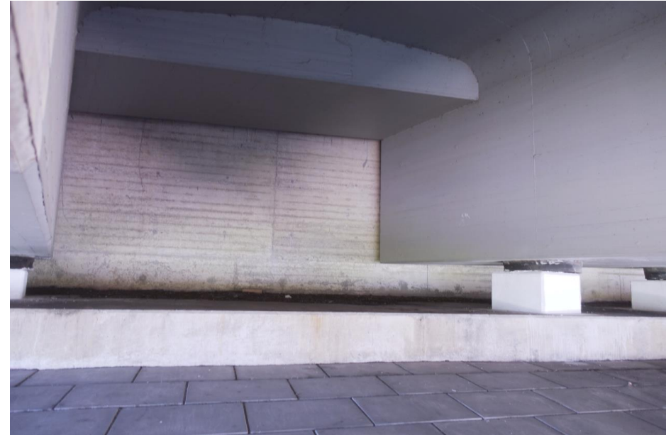
Zicht op het opgaande werk van het noordelijke landhoofd.
