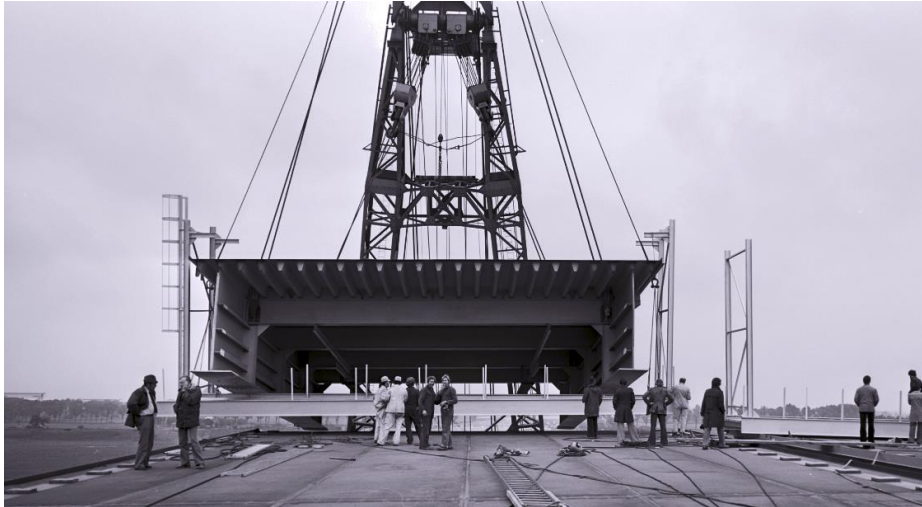
Zicht op de constructie van de hoofdo overspanning bij plaatsing in 1976. RWS beeldbank nr. 487833.
