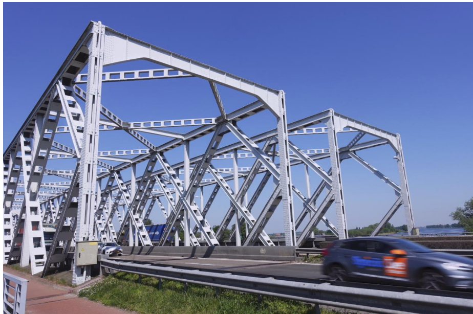
Zicht op de met volwandige liggers uitgevoerde portalen van de twee zuidelijke brugdelen.
