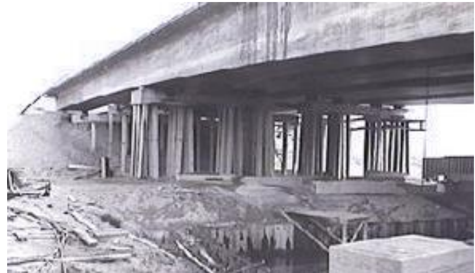
Zicht op de noordelijke onderbouw van de brug, waarbij de liggers al aanwezig zijn en de bekisting voor het storten van de pijlers is aangebracht. RWS beeldbank, maker: Bart van Eyck, nr. 22359-025.
