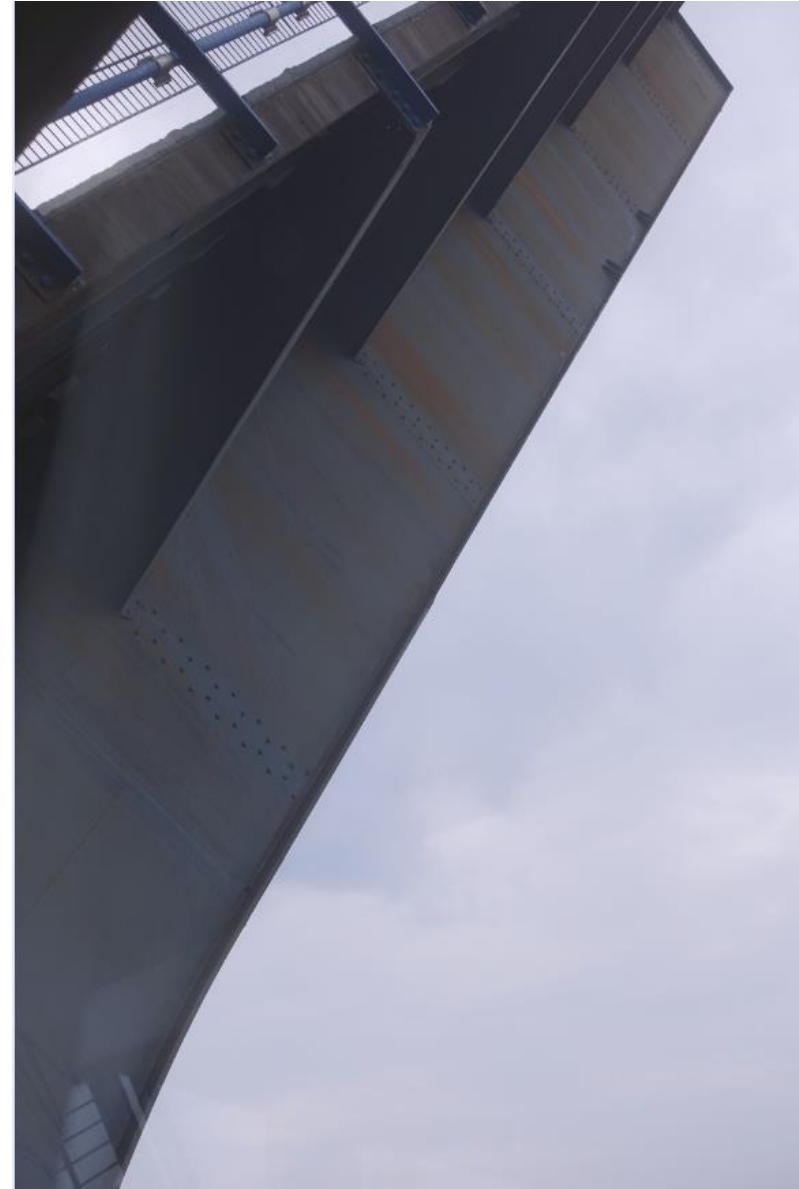
Zicht op de westelijke gelaste hoofdligger van het val, gezien bij open toestand van de brug vanuit het brugwachtershuis.
