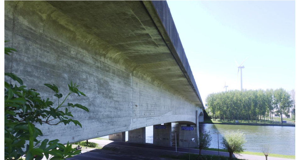
Zicht op de buitenste koker ter hoogte van de zijoverspanning op de noordzijde van de oever, waarbij de opbouw van zijwand en bovenrand met uitkraging goed zichtbaar is.
