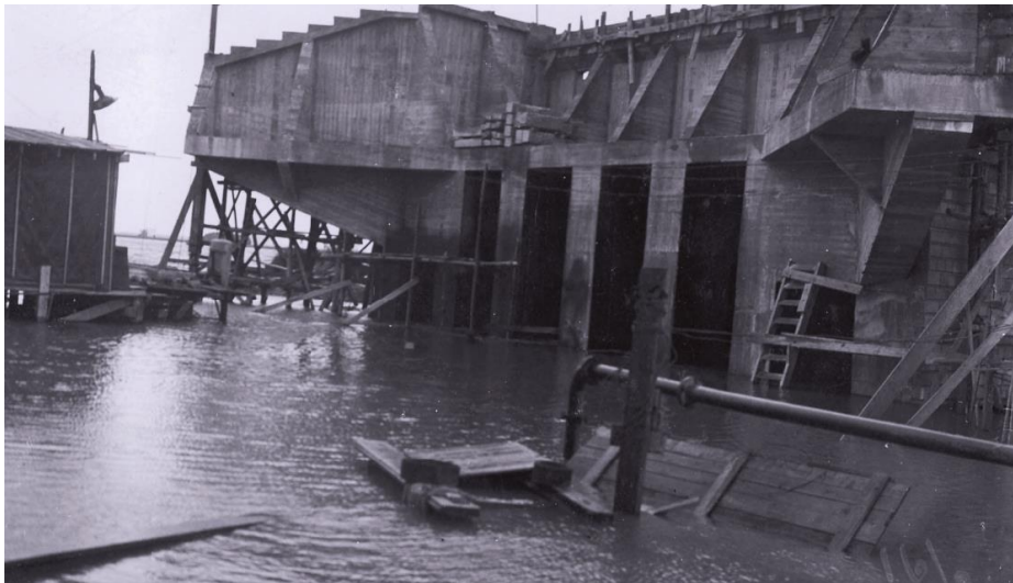
Zicht op de bouw van een betonnen landhoofd bij de Keizersveerbrug. RAT coll. 2639, Collectie foto's en glasnegatieven Geertruidenberg, 1870-2000, inv.nr. 604825.
