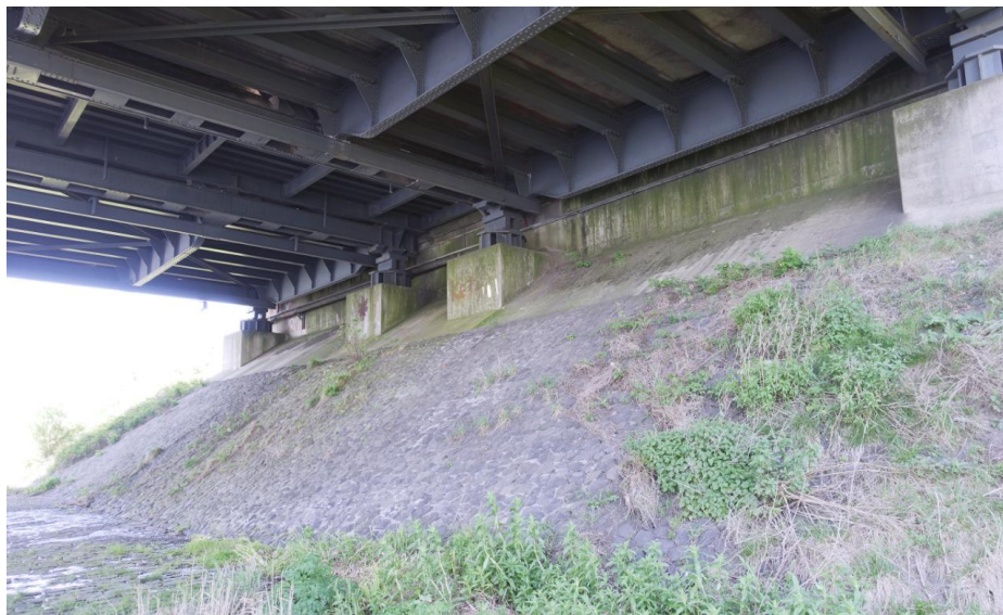
Zicht op het noordelijke betonnen landhoofd.
