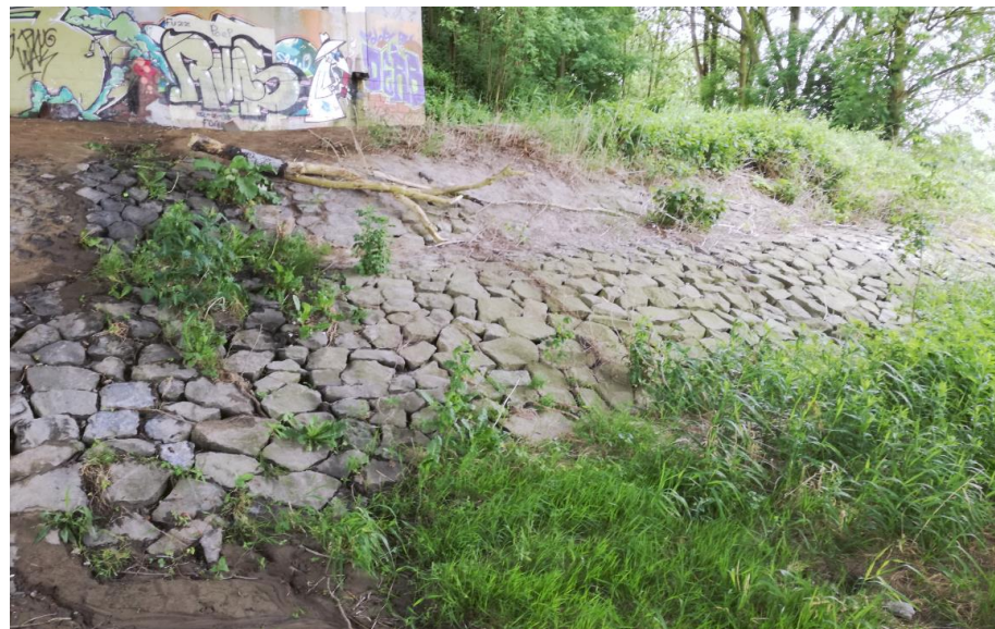
Detail van het met stenen beklede talud aan de rivierzijde bij het zuidelijke landhoofd.
