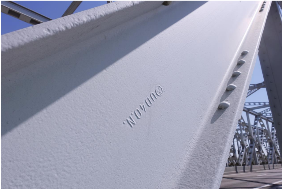
De buitenste vakken van de brugdelen zijn opgebouwd uit profielen van st.40.
