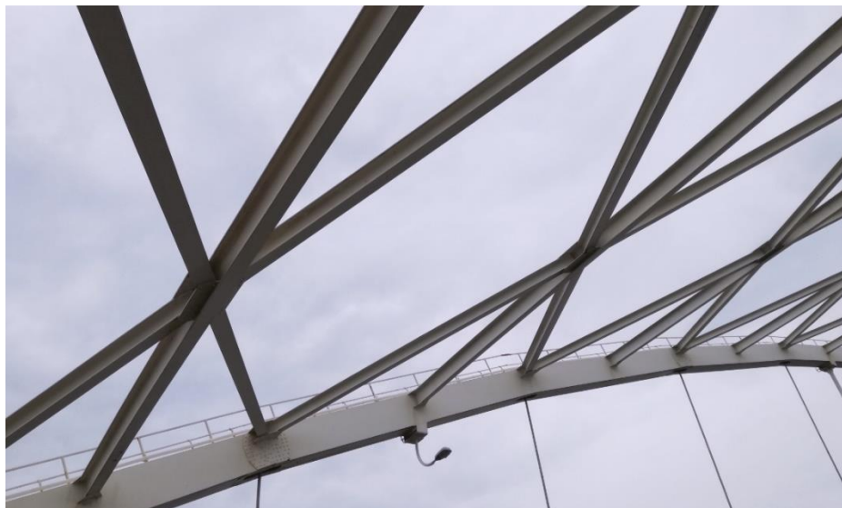
Zicht op de bovenwindverbanden die op verschillende manieren aan de boogrand zijn bevestigd.
