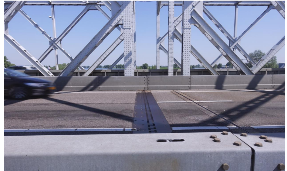
Zicht op de stalen rijvoeg tussen het zuidelijke en middelste deel dat in 1978 is aangebracht.
