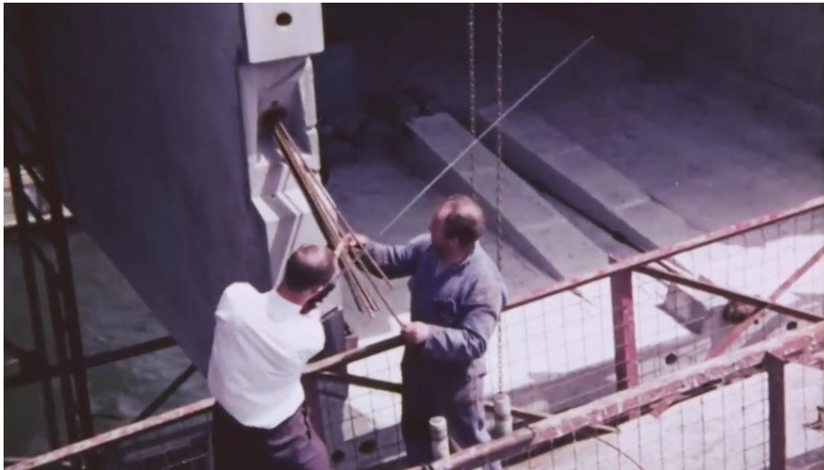
Het doorvoeren van de spanningskabels, ook wel Freyssinet kabels genoemd, bij de brug over de Brielse Maas uit 1969 waardoor het beton gespannen kan worden. Uit: Over lijmen gesproken , promotiefilm provincie Zuid-Holland, 1967-1968.
