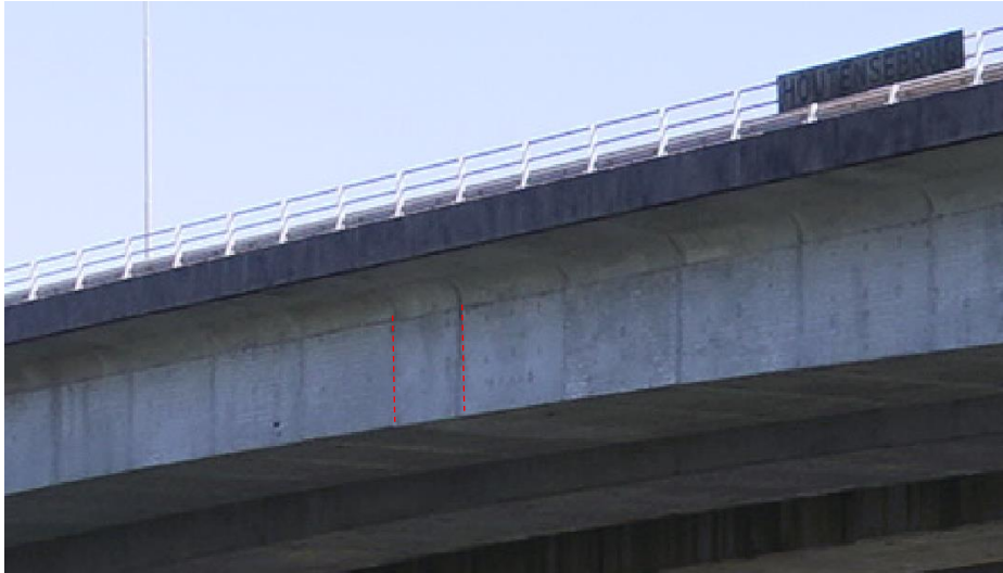
De sluitmoot bij de overspanning is herkenbaar aan de afwijkende afmeting.
