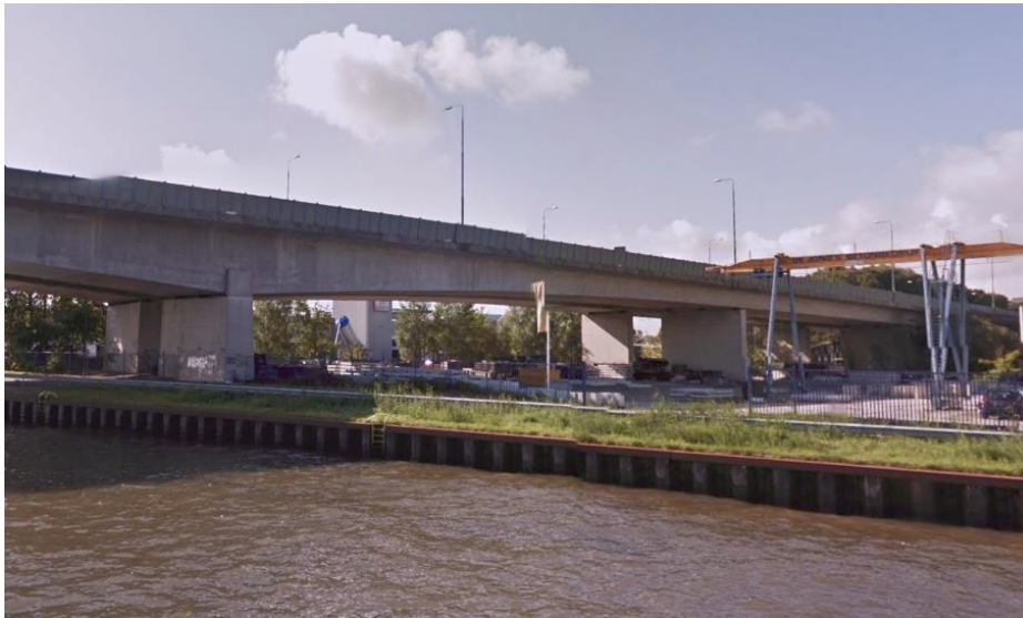
Zicht op de dubbele zijbruggen op de zuidoever van het kanaal bij Maarssen. De pijlers hebben hier een dichte vorm, net als de onderzijde van de liggers. Google Maps 2018.
