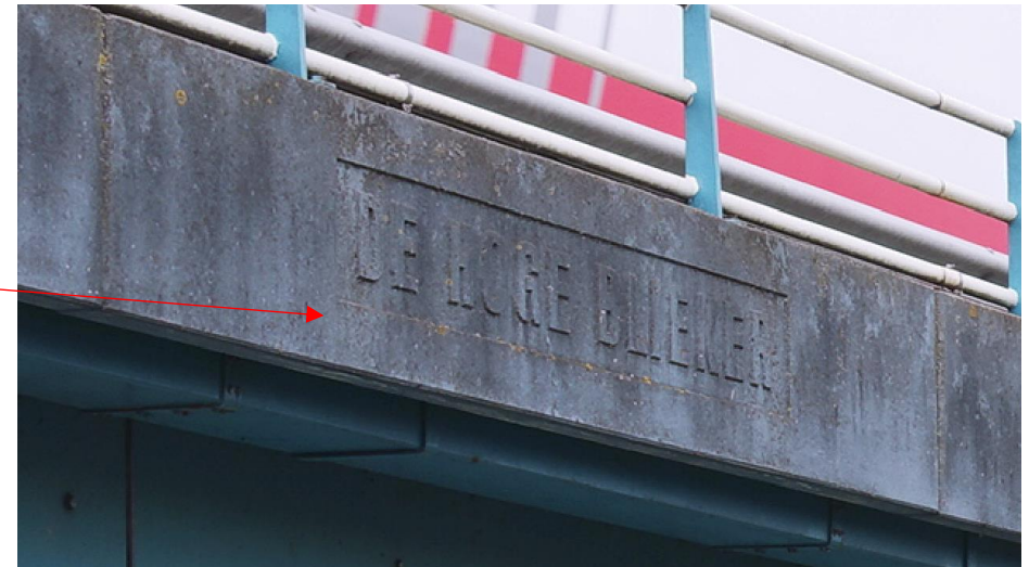
Detail van de tekst DE HOGE BLIEKER op de bovenste rand van de zuidelijke zijoverspanning.
