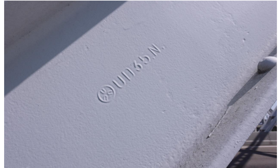
Richting het midden van elk brugdeel zijn er steeds minder zware profielen gebruikt.
