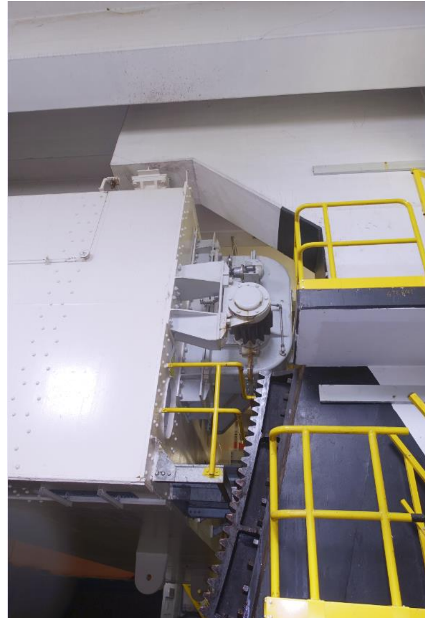
Zicht op de oostelijke hoofdlijger met aan de achterzijde de bevestiging van een tandrad en elektromotor.
