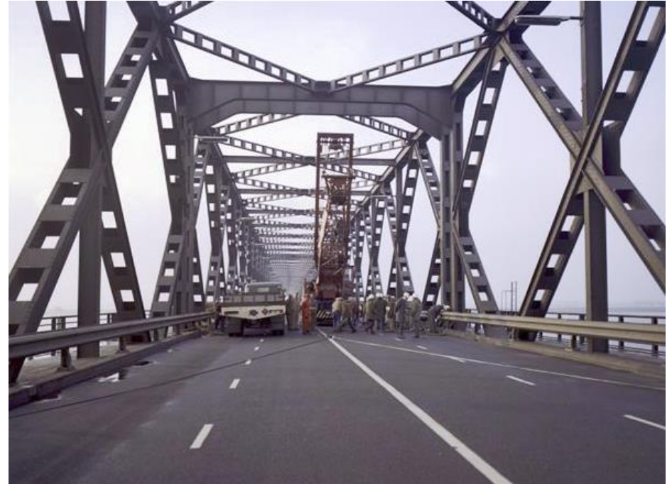
Zicht op de Moerdijkbrug bij de ontmanteling in 1976. RWS beeldbank nr. 23622-013.
