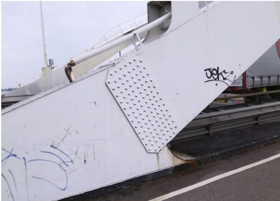
Zicht op de aansluiting aan de buitenzijde van de noordelijke boogrand op de hoofdligger.
