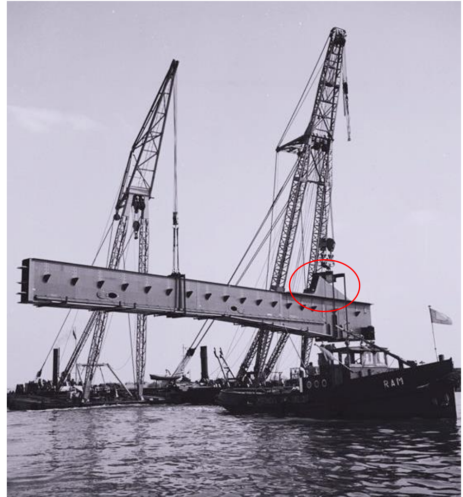
Het invaren van een deel van de stalen hoofdligger. Bij de rode cirkel is de aansluiting zichtbaar waar de losse delen van de bovenrand van de boog op worden aangesloten. De consoles tegen de zijwand van de ligger vormen de opleggingen voor de dwarsdragers van de rijvloer. RWS beeldbank, Afdeling Multimedia, nr. 24022-003.
