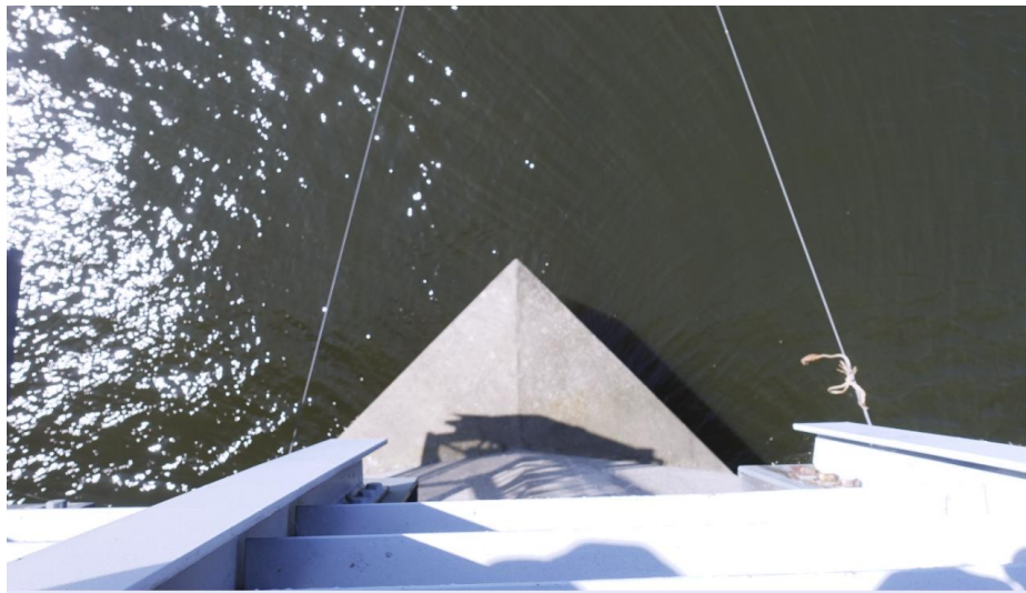
Zicht op het betonnen uiteinde van het in 1978 verbrede deel van de noordelijke rivierpijler, gezien van bovenaf.
