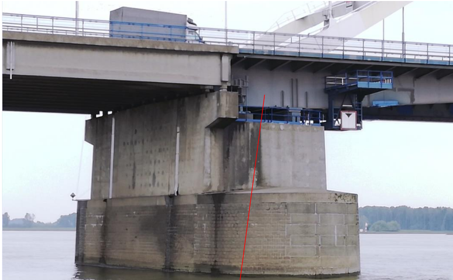
Zicht op de brede zuidelijke rivierpijler met de aansluiting van de boogbrug op de aanbrug.
