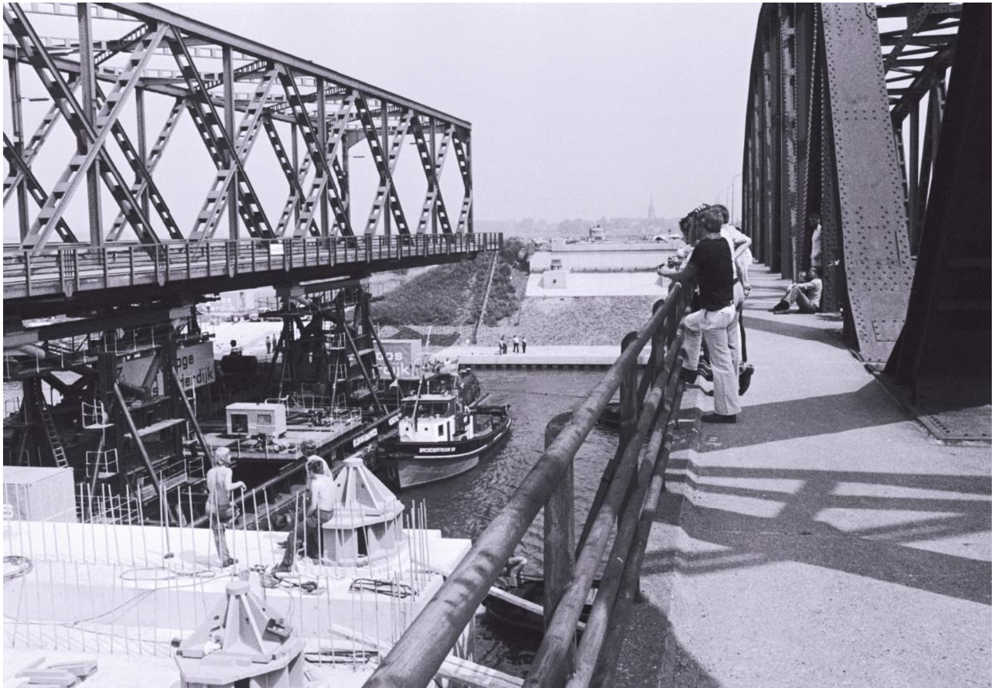
Het invaren van een brugdeel gezien vanaf de oude Keizersveerbrug in juni 1976. SB beeldbank, coll. BN De Stem / Johan van Gorp, nr. JVG19760623002
