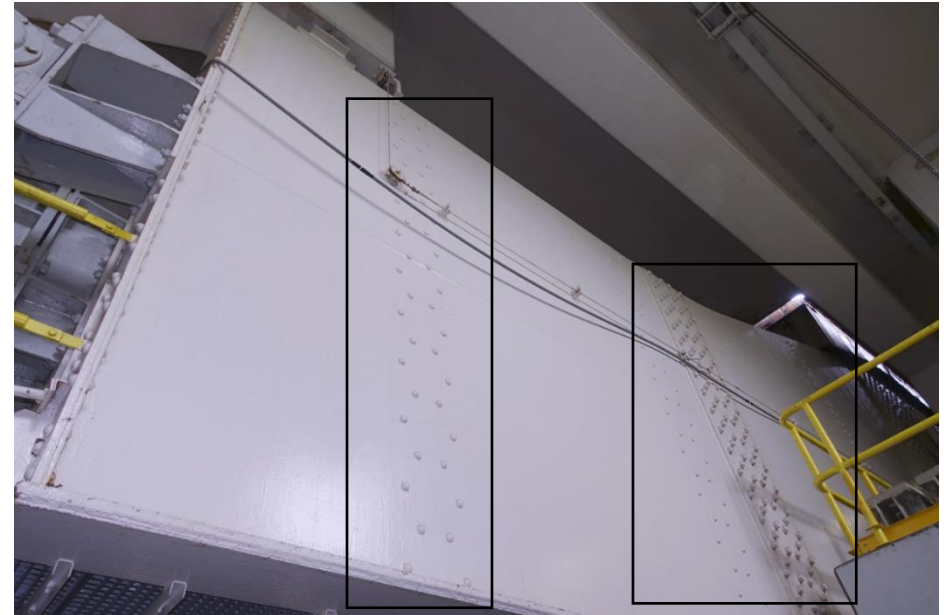
Zicht op de buitenzijde van het staartgedeelte bij de westelijke ligger met de verstevigingen in de omlijning.
