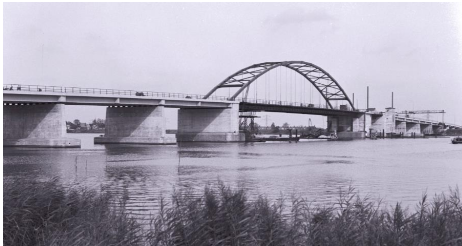
Zicht op de brug over het IJ bij Schellingwoude uit 1957. RWS beeldbank, Afdeling Multimedia, nr. 25170-005.
