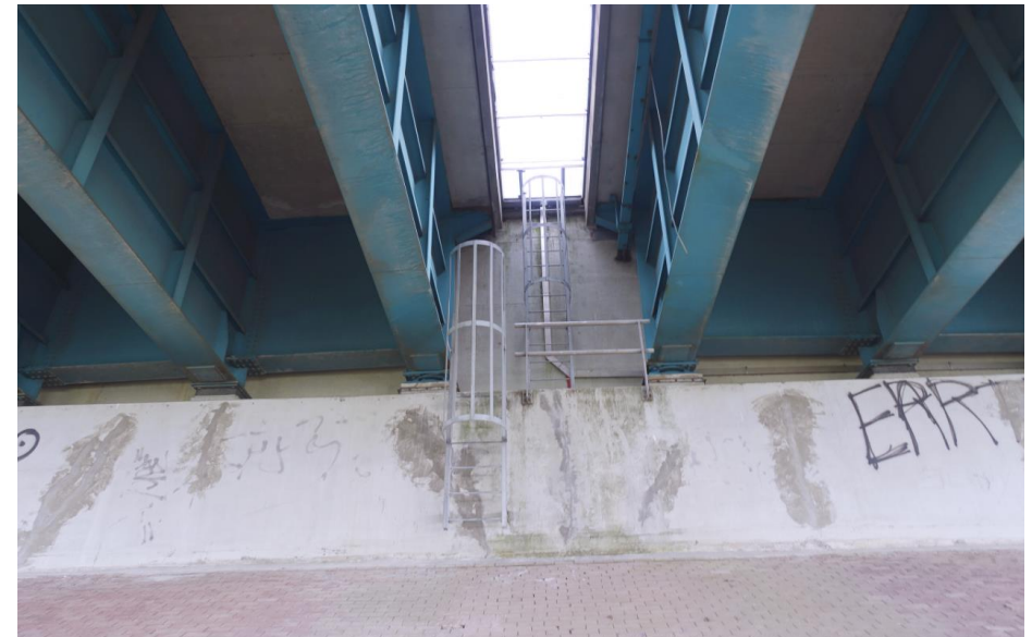
Vanaf het noordelijke landhoofd kan het veiligheidspad tussen de twee weghelften worden beklommen.
