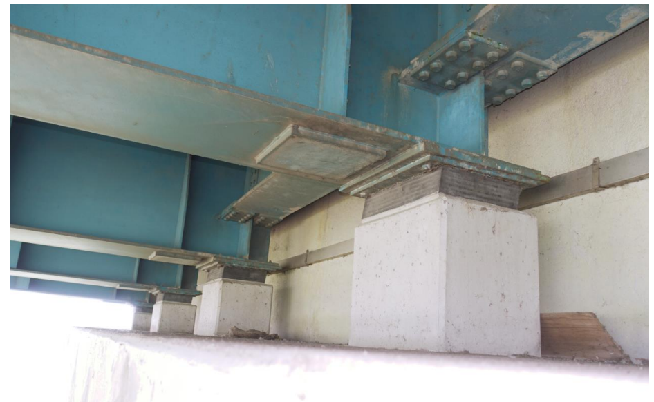
Detail van de teflon opleggingen bij het zuidelijke landhoofd op betonnen poeren.
