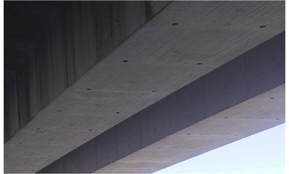
Aan de onderzijde van de kokers ter hoogte van de hoofdoverspanning zijn ronde gaten aanwezig, mogelijk een restant van de bekisting.
