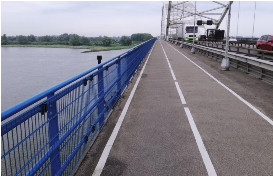
Zicht op het oostelijke fietspad bij de aanbruggen richting zuidoever.
