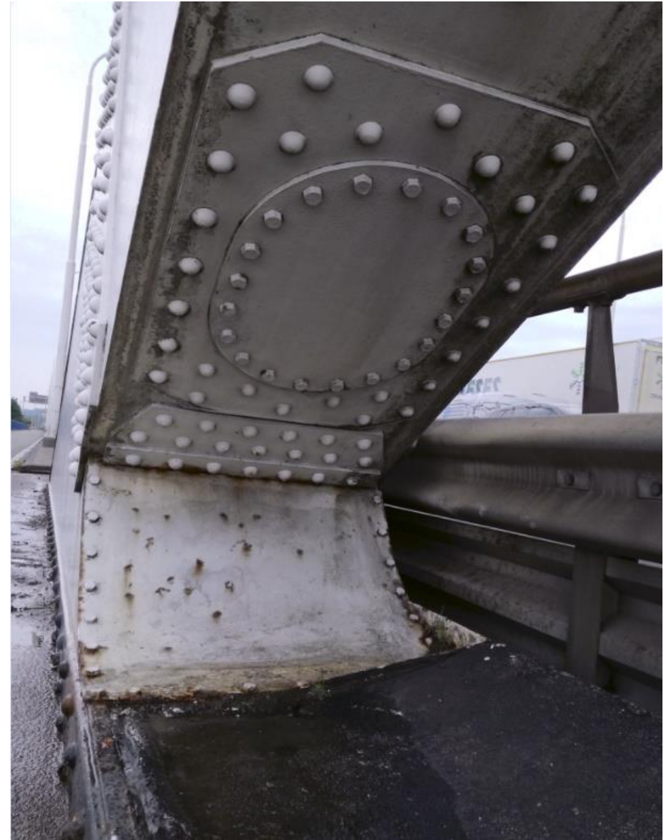
Zicht op de onderzijde van de geklonken en geschroefde aansluiting van de boogrand op de noordelijke hoofdligger.
