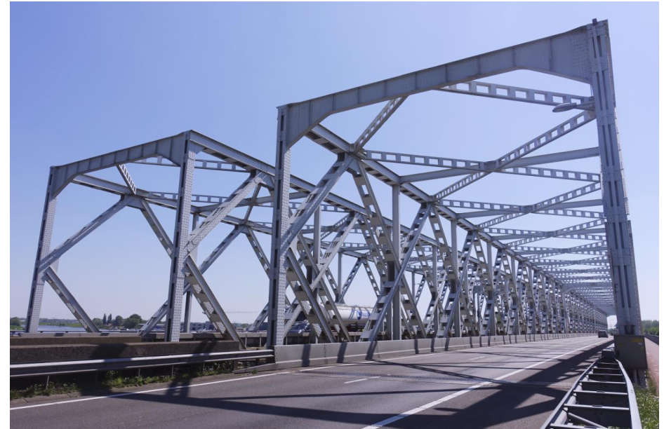
Zicht op de twee portalen van de noordelijke bruggdelen.
