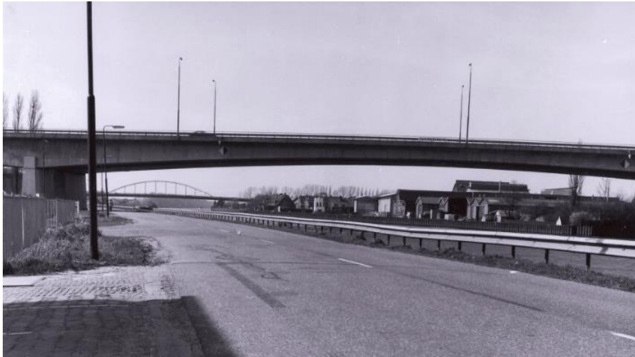
De Zuilensebrug uit 1979 over het Amsterdam-Rijnkanaal in Maarssen is een soortgelijke kokerliggerbrug als in Houten. UA beeldbank: coll. HUA, nr. 93899.
