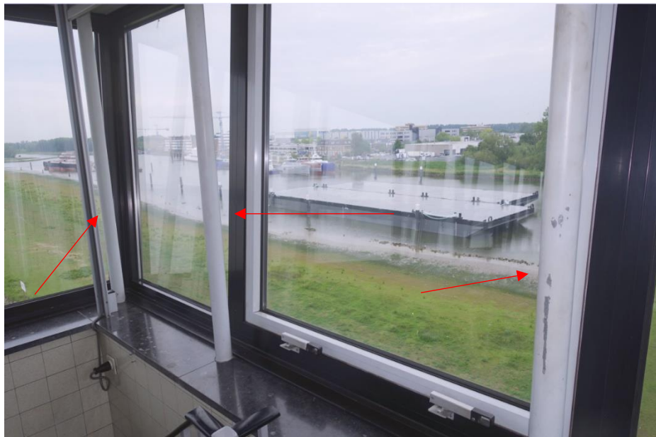
Het dak heeft op de bovenste verdieping een stalen ondersteuning gekregen.
