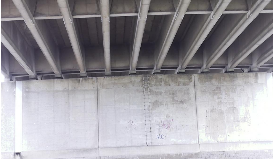
Zicht op de oplegging van rubbers bij een van de zuidelijke aanbruggen.
