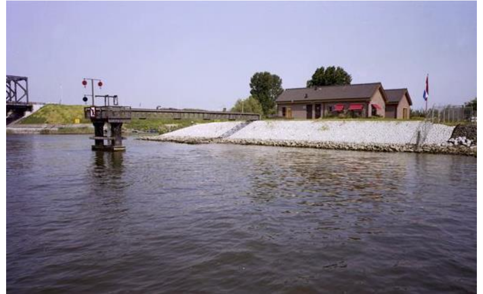
Zicht op het in 1977 gebouwde meetstation voor waterkwaliteit in de voormalige aanlegplaats van de veerpont op de noordelijke oever van de Bergsche Maas. RWS beeldbank nr. 24958-006.
