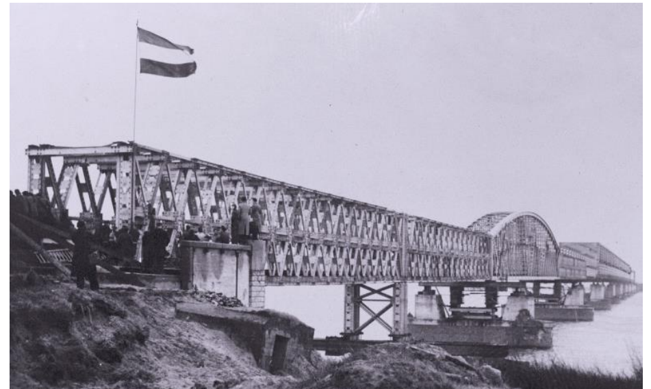
Opening op 31 december 1945 van de verkeersbrug bij Moerdijk. De ernstig beschadigde oorspronkelijke brugdelen zijn vervangen door overspanningen uit de spoorbrug en Callender-Hamiltonbrugdelen. NA beeldbank, coll. Fotocollectie Elsevier, nr. 901-5537
