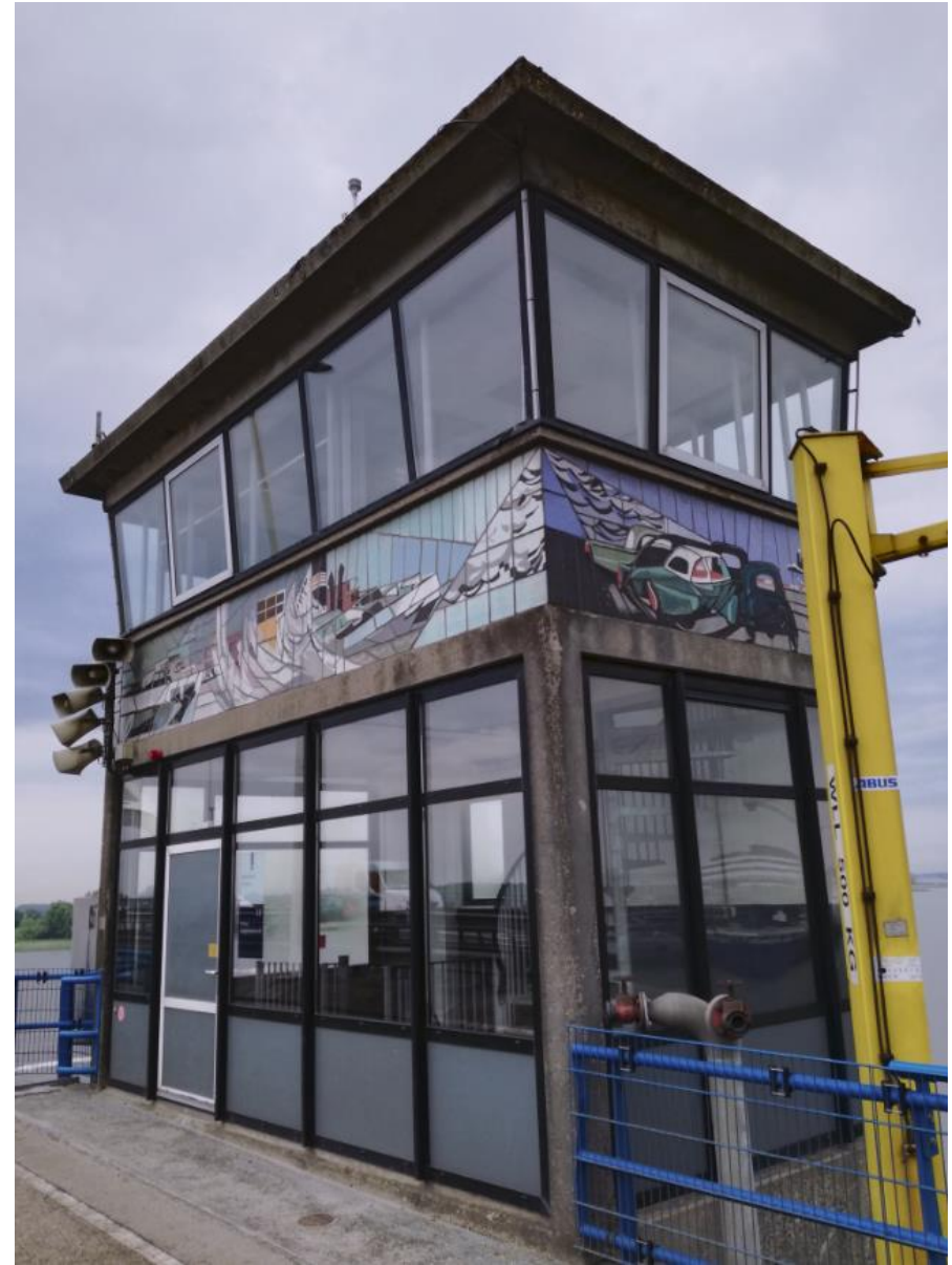
Zicht op de bovenste twee verdiepingen van het brugwachtershuis, gezien vanuit het noorden.
