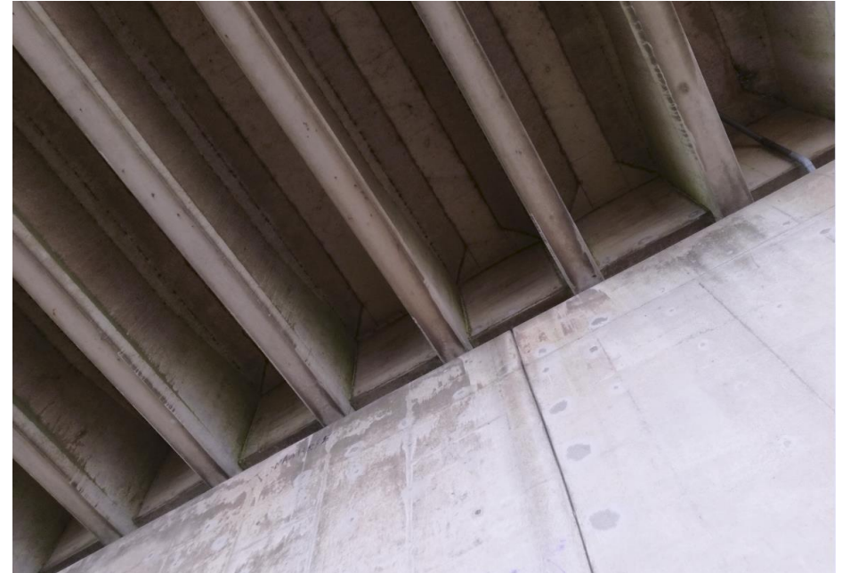
Detail van de langsliggers van voorgespannen beton bij de aanbruggen.
