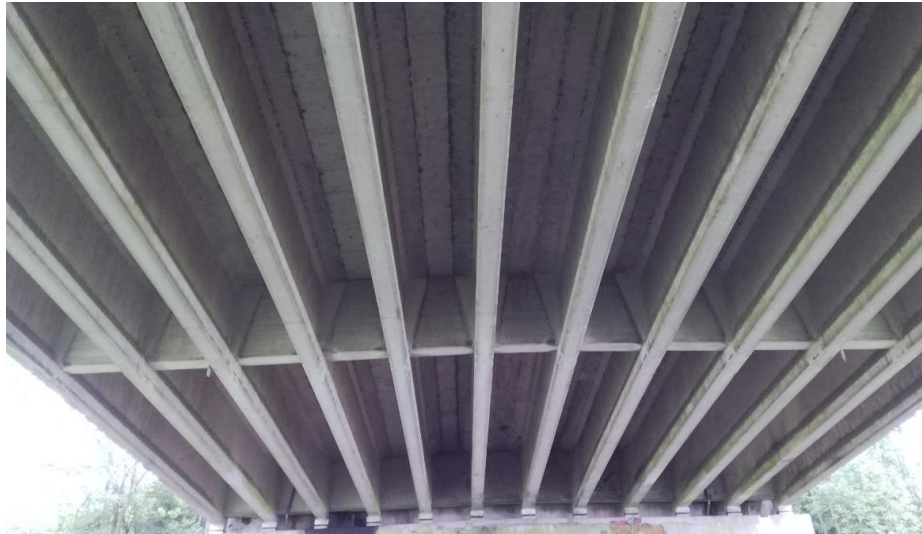
De langsliggers hebben een dwarsverband in de vorm van betonnen wiggen.
