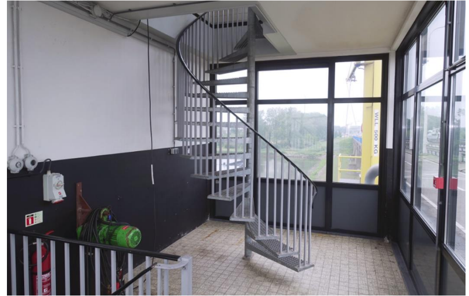
Zicht op de verdieping in het brugwachtershuis op het niveau van het rijdek. Hier zijn de later aangebrachte trapopgangen naar de bovenste verdieping en het ondergelegen niveau gesitueerd.
