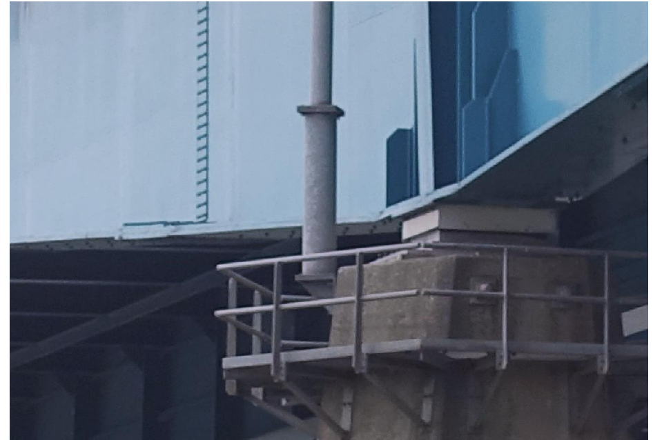
Detail van de bevestiging van een stalen console voor de lantaarn aan de buitenzijde van de pijler bij de hoofdoverspanning.
