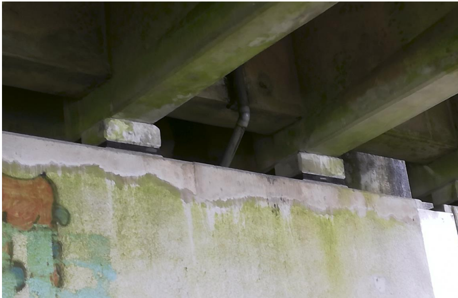
Detail van de oplegging met rubbers bij het zuidelijke landhoofd.
