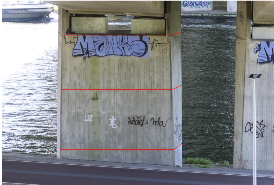
Zicht op een van de pijlers op de noordoever met in de rode lijnen de horizontale lijnen die de moten aangeven.
