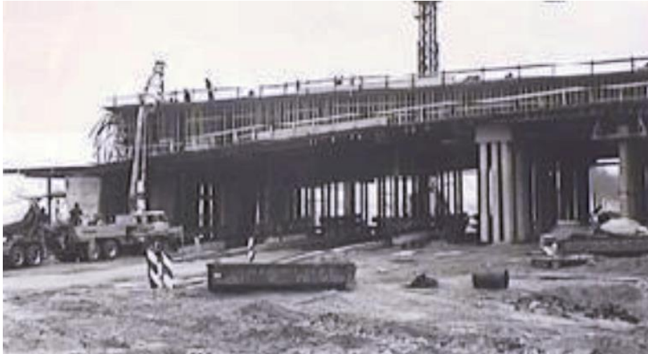
Zicht op de manier waarop de doorlopende bekisting van de kokers bij de zijoverspanning aan de noordzijde van de brug is gemaakt. RWS beeldbank, maker: Bart van Eyck, nr. 22359-003.
