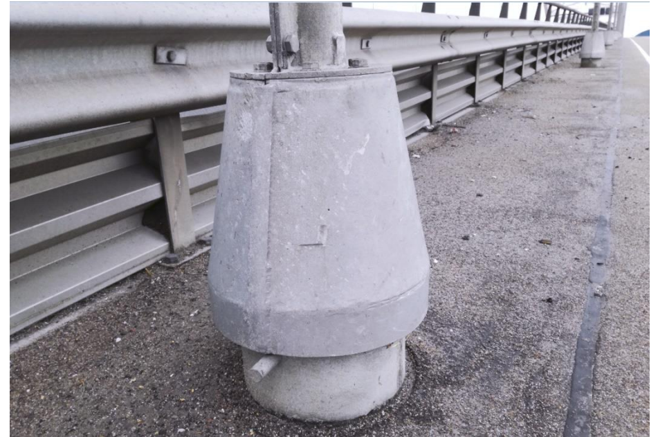
Detail van de voet van de staalkabel bij de noordelijke boog.
