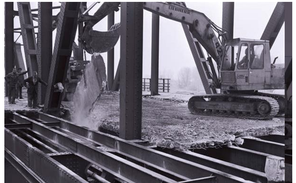
Sloop van het betonnen wegdek. RWS beeldbank nr. 23740-004.
