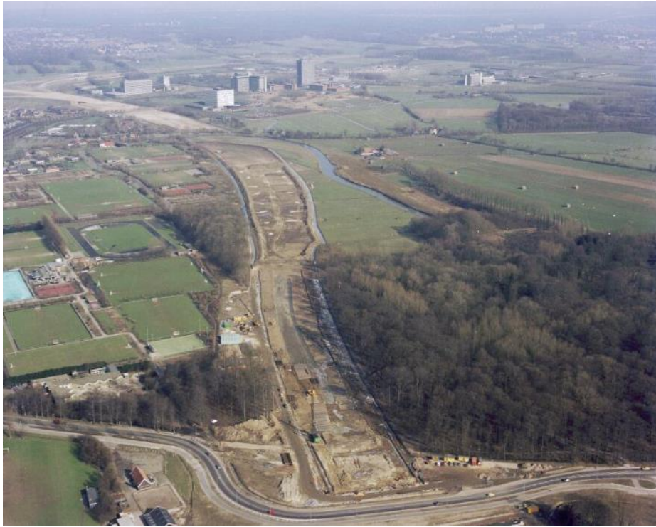
Zicht op de bouwwerkzaamheden bij het nieuwe tracé van de A27 ter hoogte van het landgoed Amelisweerd, rechts op de foto uit 1983. UA beeldbank, coll. Fotodienst GAU.
