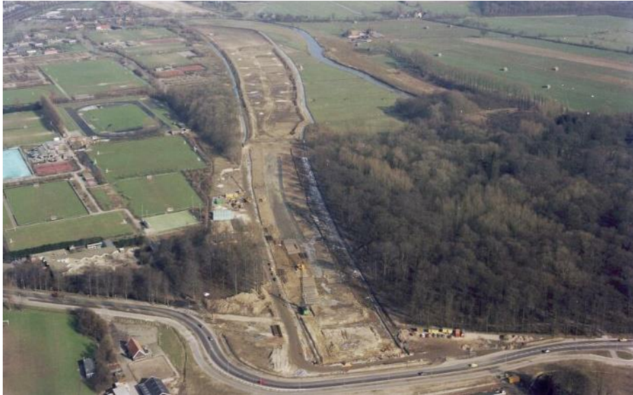
Zicht op de bouwwerkzaamheden bij het nieuwe tracé van de A27 ter hoogte van het landgoed Amelisweerd, rechts op de foto uit 1983. UA beeldbank, coll. Fotodienst GAU.
