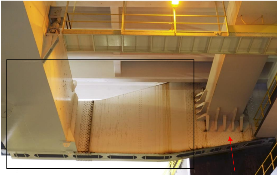
Zicht op de binnenzijde van de oostelijke ligger met de draaias die de twee liggers met elkaar verbindt bij de rode pijl en het staartgedeelte in de omlijning.
