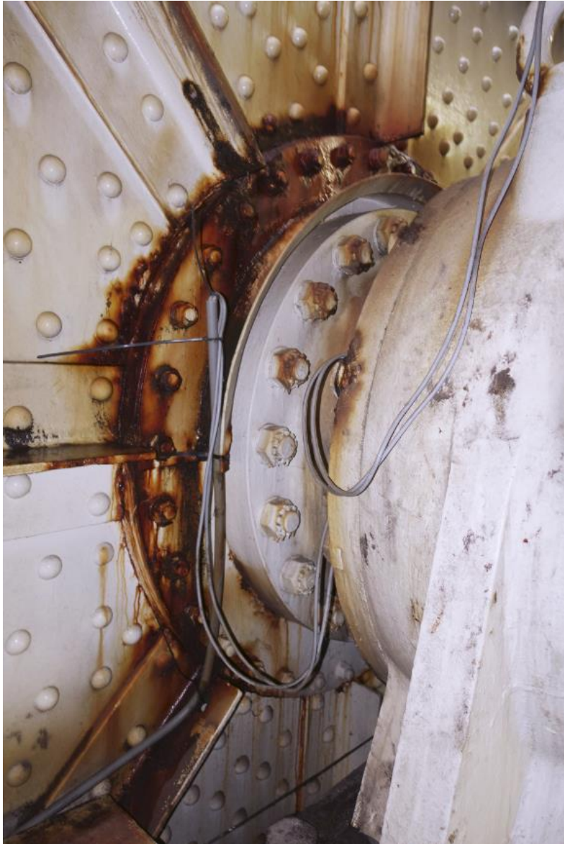
Detail van de geklonken en geschroefde bevestigingen bij de draaias bij de westelijke hoofdligger.
