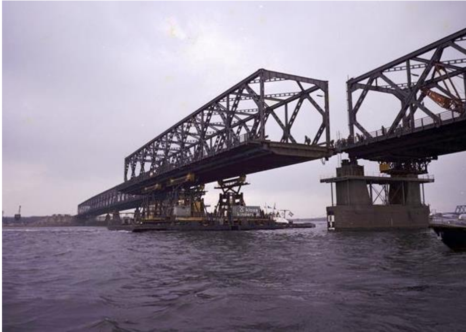
De ontmanteling van de Moerdijkbrug in 1976. RWS beeldbank nr. 23622-044.
