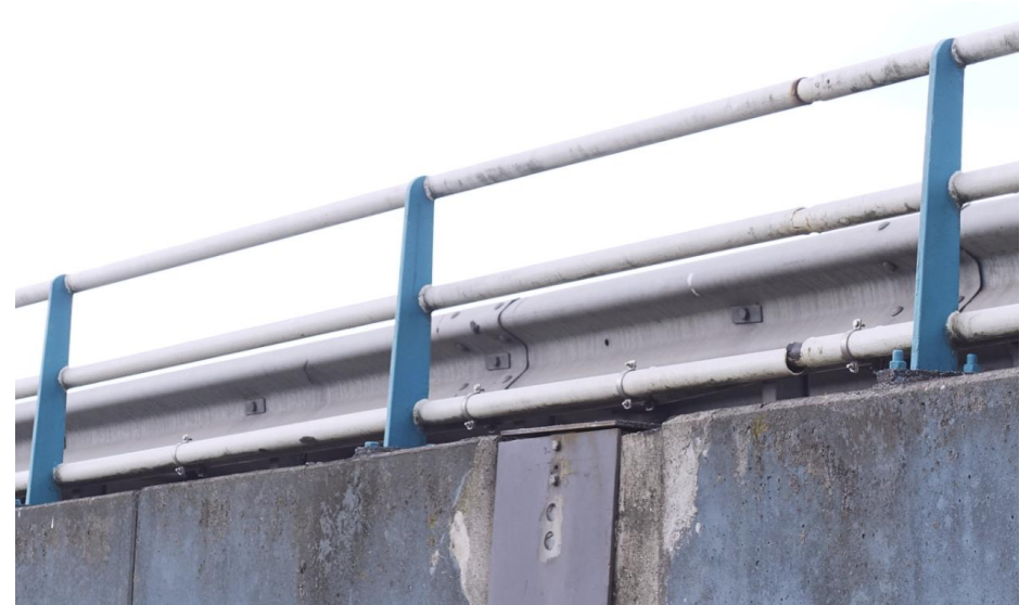
Het rijdek wordt afgesloten door een stalen leuning en vangrail.
