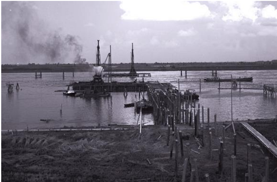
De bouw van de Merwedebrug tussen Gorinchem en Sleetwijk is in 1958 begonnen. RWS beeldbank nr. 24020-015.
