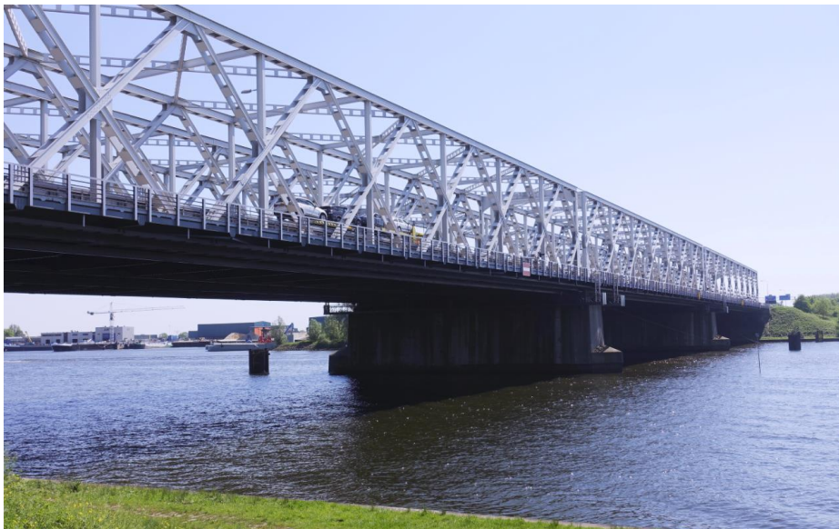
Zicht op de Keizersveerbrug gezien vanaf de noordoever.
