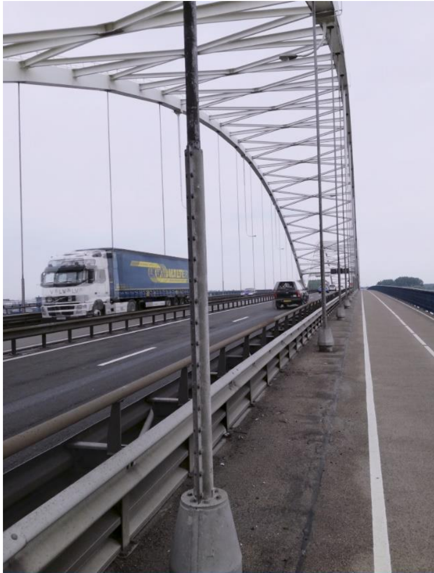
Zicht op de staalkabels tussen de boogrand en de hoofdligger bij de noordelijke boog.
