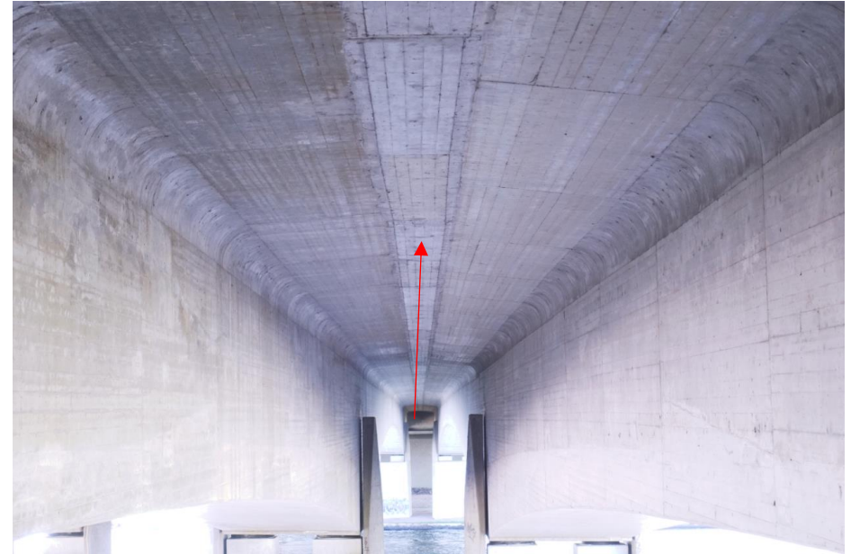
Het rijdek wordt gevormd door een dek van gestort beton.
