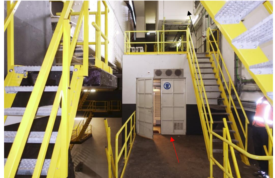
Zicht de westelijke helft van de basculepijler waar een machinekamer is (rode pijl) en een moderne technische ruimte (zwarte pijl), gezien richting het zuiden.
