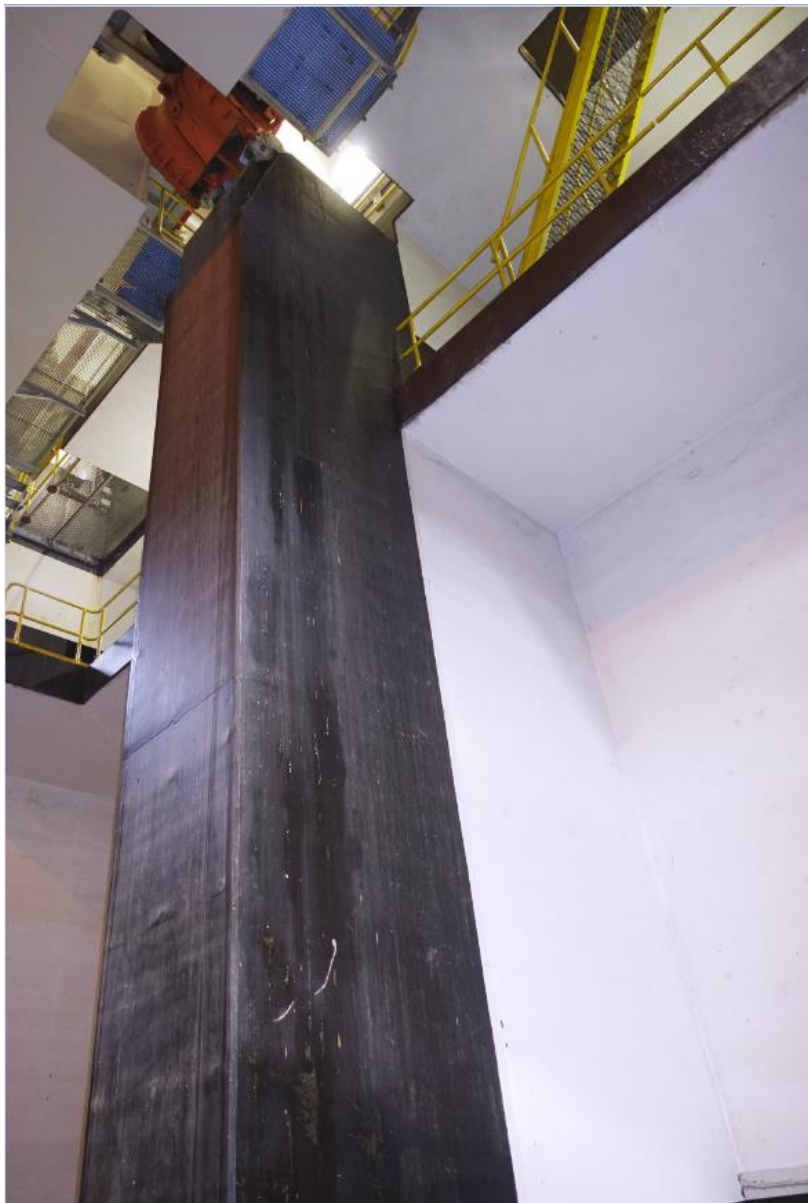
Zicht op de betonnen fundering met daar boven op de schelp, gesitueerd tegen de noordwand van de basculepijler.
