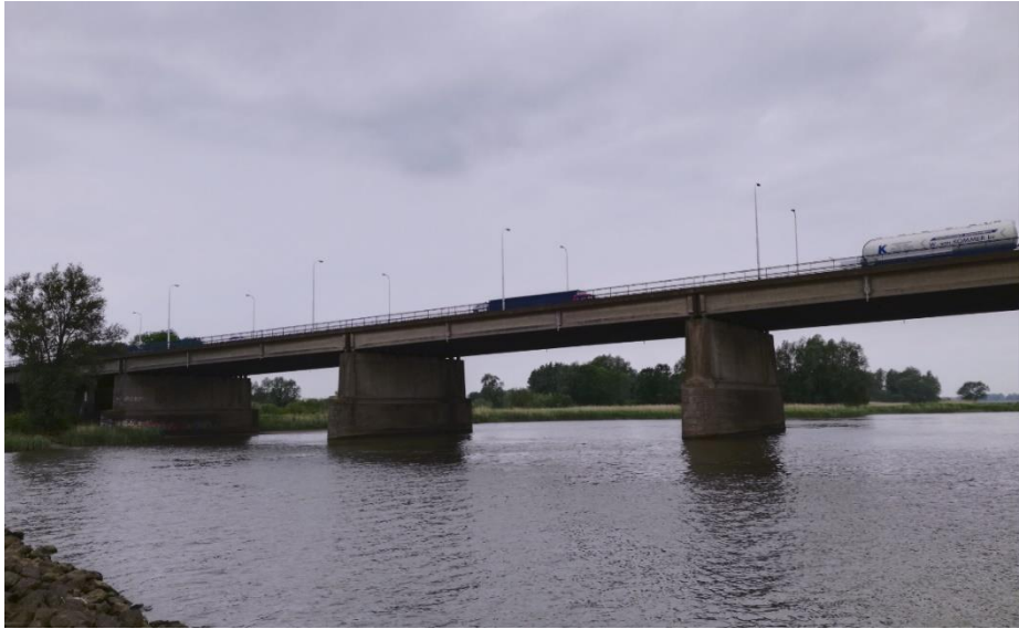
Zicht op de zuidelijke aanbruggen.
