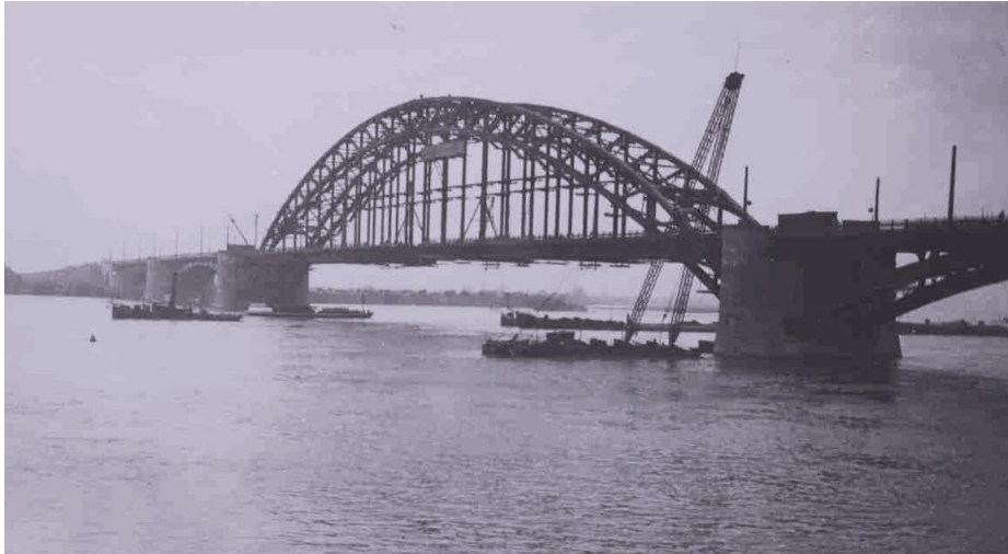
De bouw van de Waalbrug bij Nijmegen in 1935. RAN beeldbank: Fotocollectie Regionaal Archief Nijmegen, nr. F47131.
