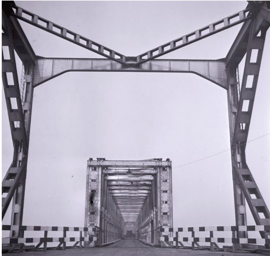
Op 31 december 1945 is de verkeersbrug weer geopend, gerepareerd met de nodige tijdelijke overspanningen, zoals de smallere Callender-Hamiltonbruggen. NA beeldbank, coll. Fotocollectie Anefo, nr. 901-3221.
