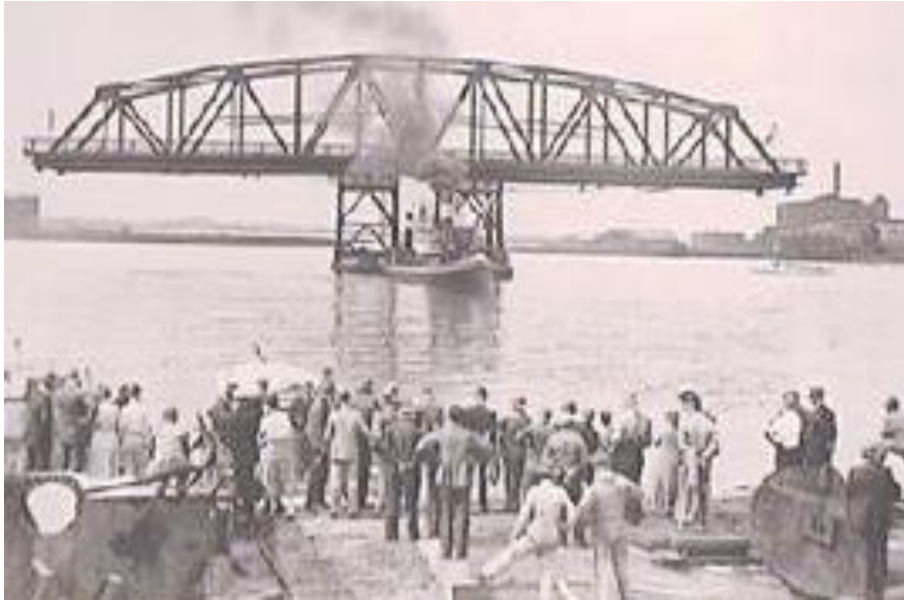
Het invaren van een brugdeel bij de bouw in 1933 van de brug bij Muiden over het Amsterdam-Rijnkanaal. RWS beeldbank nr. 22645-021.
