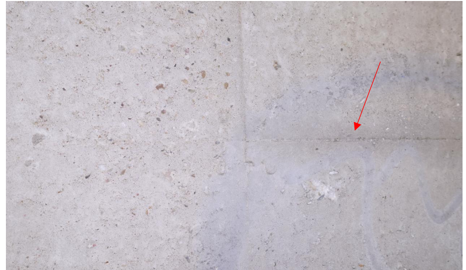
Detail van het beton met stortvoeg (pijl) van de staander bij de pijler die de noordelijke aanbrug met de hoofdoverspanning verbindt.
