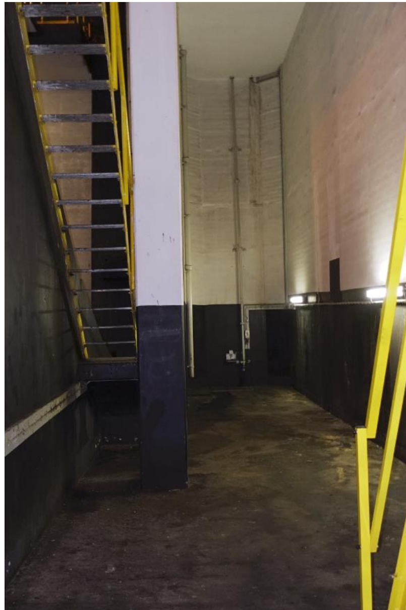
Zicht op de oostelijke helft van de basculepijler waar geen indelingen aanwezig zijn.
