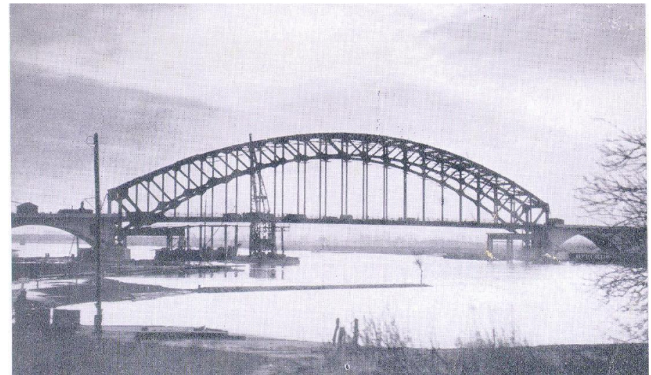
De IJsselbrug bij Zwolle is een vroege constructie van een stalen boog met betonnen aanbruggen uit 1930. HCO beeldbank nr. NL-ZIHCO_PBKR4235.
