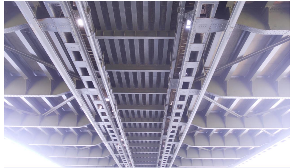
Zicht op de dwars- en langsliggers van de brugdelen met in het midden de rijdekker van de langzaam verkeer strook.
