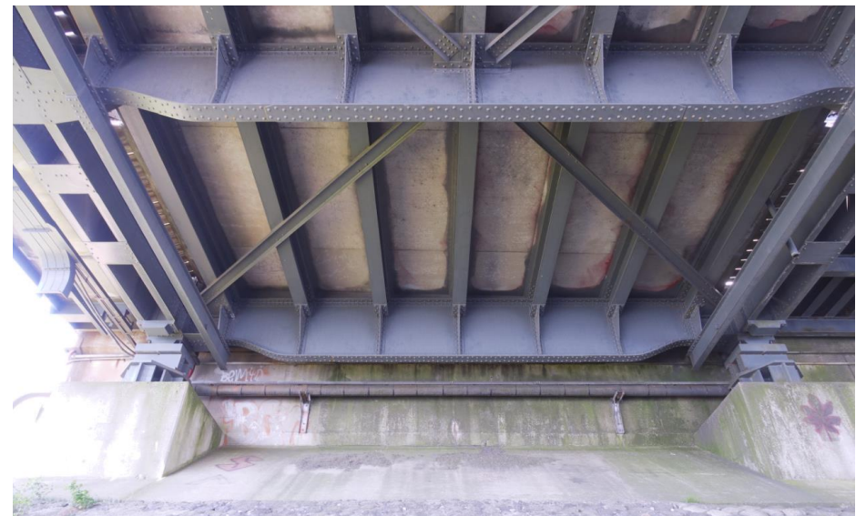
Zicht op het kruisvormige onderwindverband met U-profiel uit 1936.
