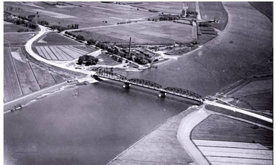
Luchtfoto van de Keizersveerbrug vlak na oplevering. RWS beeldbank nr. RWS-1457.
