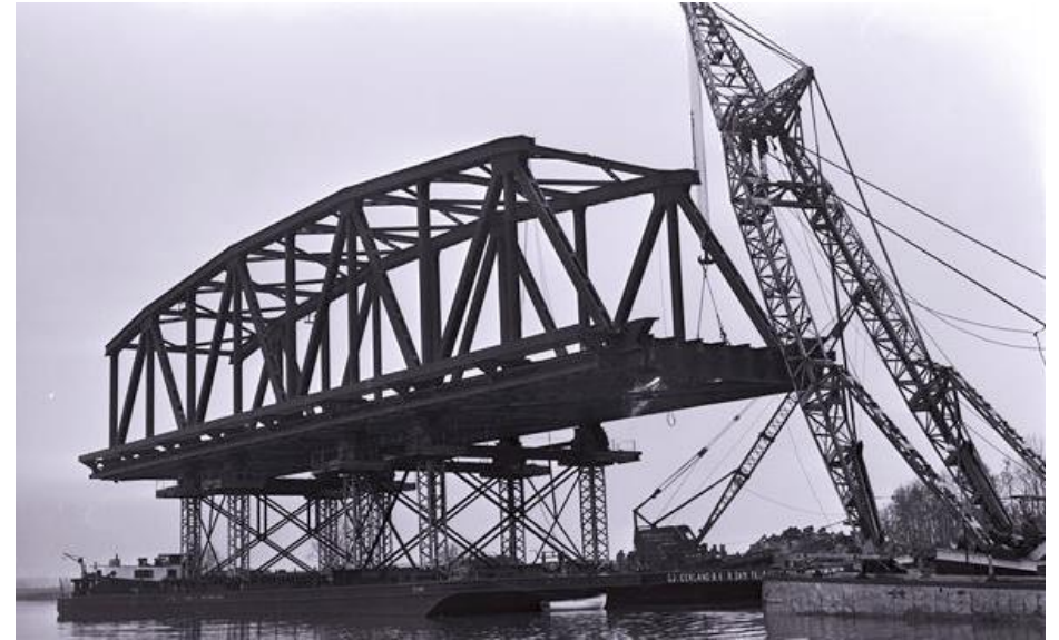
Ontmanteling van de eerste Keizersveerbrug in 1977. RWS beeldbank nr. 23740-001.
