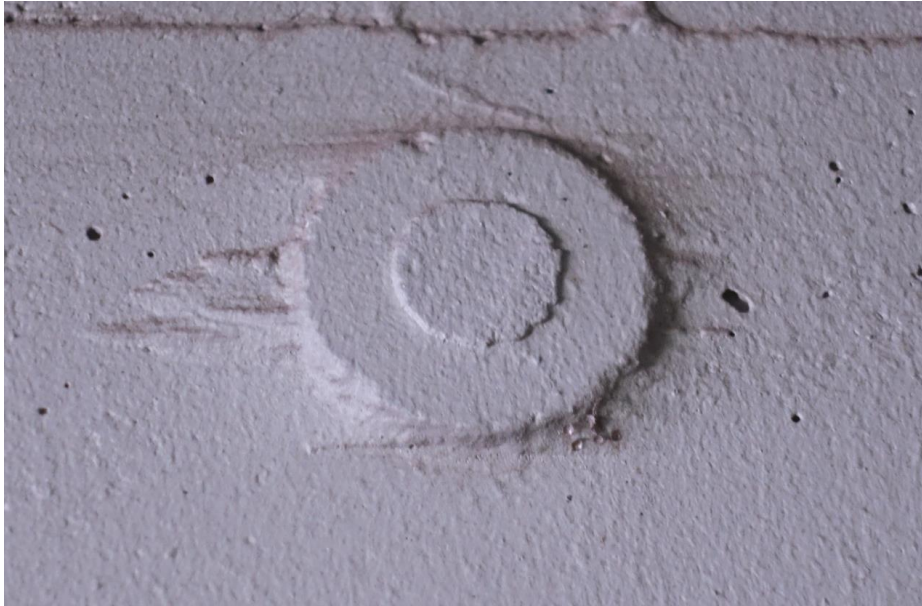
Detail van een dichtgesmeerd gat in het opgaande werk van het noordelijke landhoofd, een overblijfsel van de bekisting.
