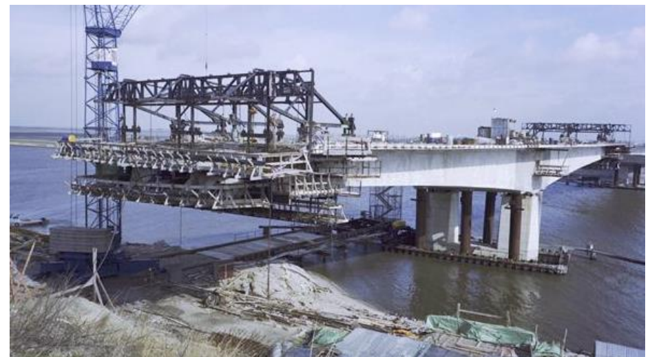
Bouw van de Stichtse Brug bij de oversteek naar Flevoland in 1982. RWS beeldbank nr. 25338-016.
