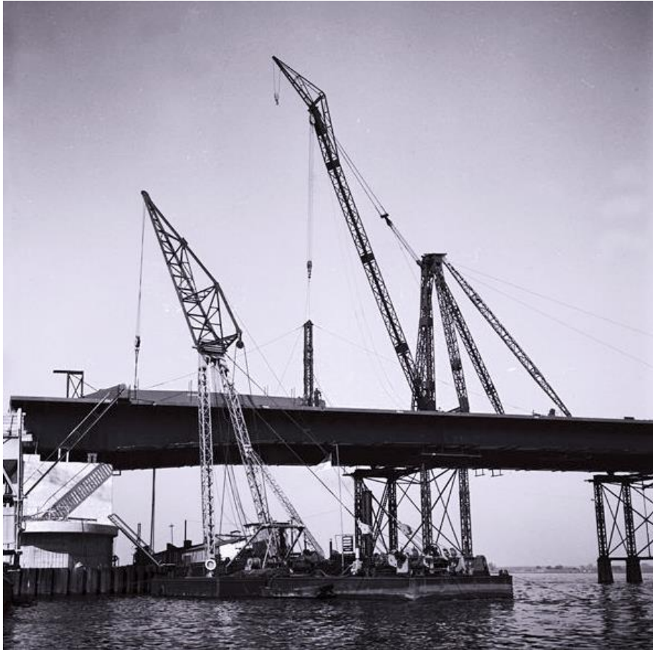
Zicht op het invaren van het val bij het basculedeel van de Merwedebrug. RWS beeldbank, Afdeling Multimedia, nr. 24026-031.
