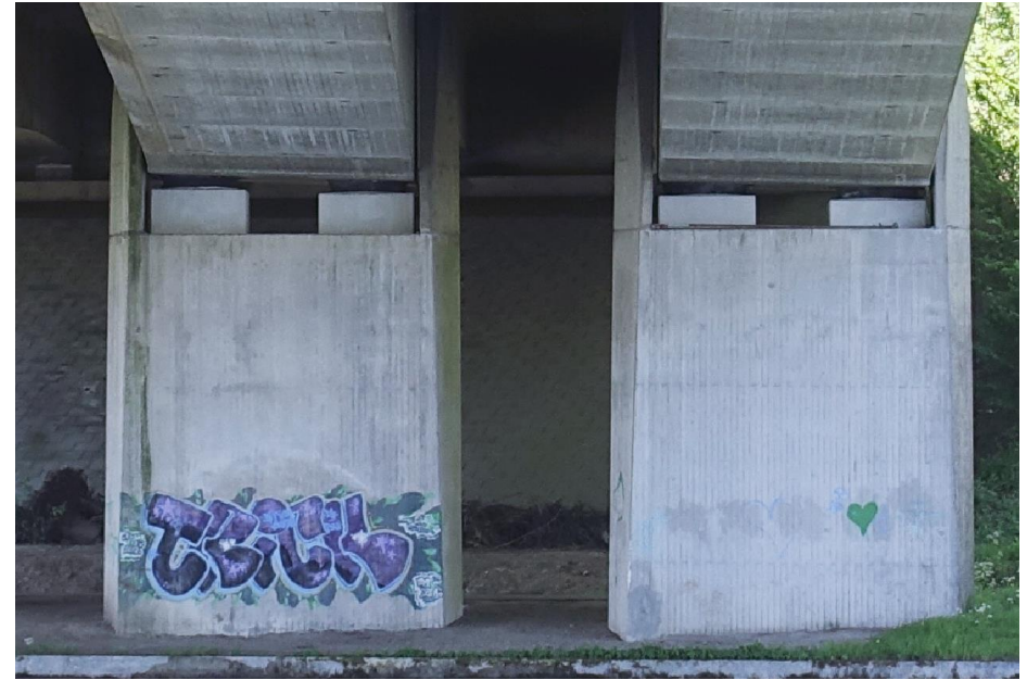
De opleggingen bij de pijlers zijn verschillend in hoogte, zoals hier goed zichtbaar is bij de pijlers op de zuidoever.
