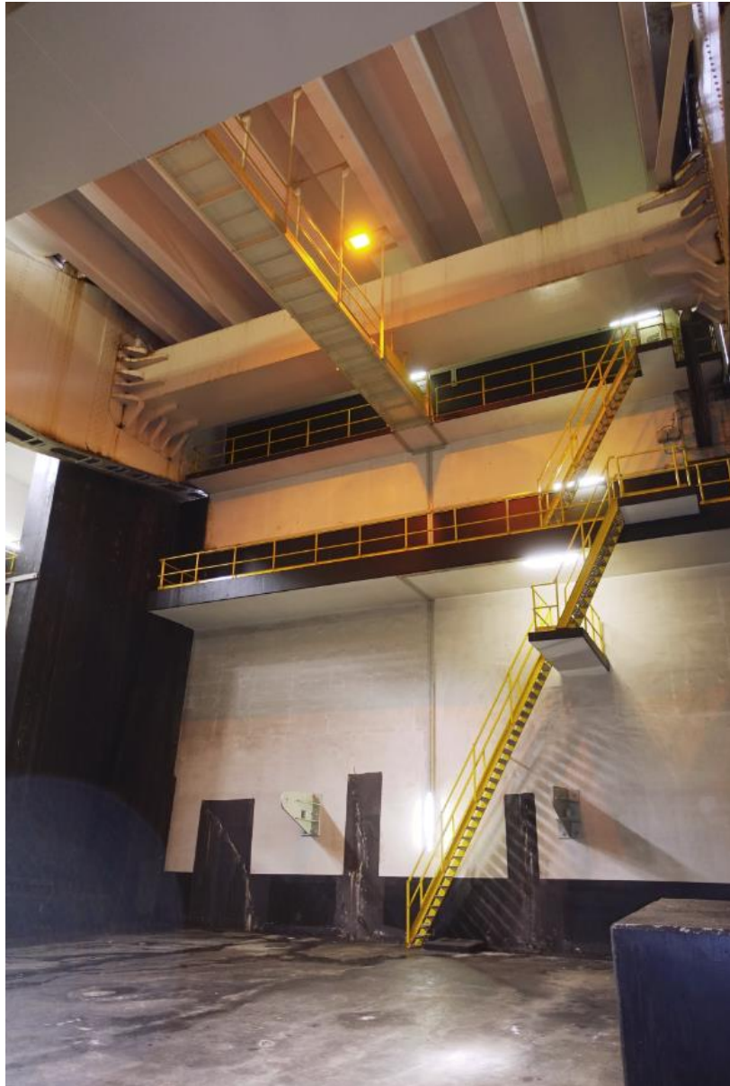
Langs de zuidwand van de basculepijler lopen op verschillende niveaus bordessen.
