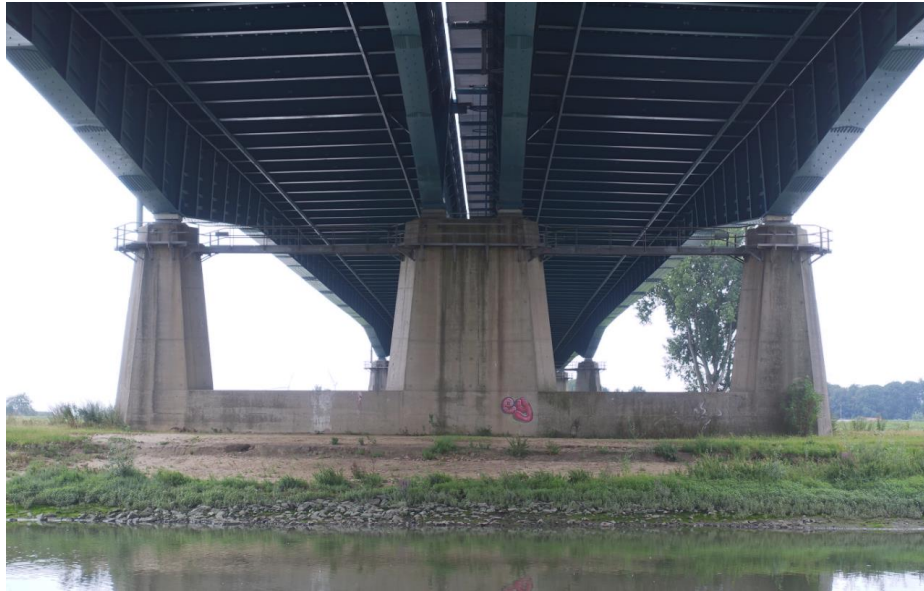
Zicht op de pijler bij de hoofdoerspanning op de noordoever.
