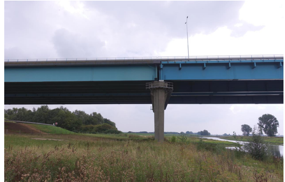
Zicht op de opbouw van de buitenzijde van de hoofdoverspanning (rechts) en zijoverspanning. Bij de hoofdoverspanning is het wegdek voor een deel op consoles gemaakt.
