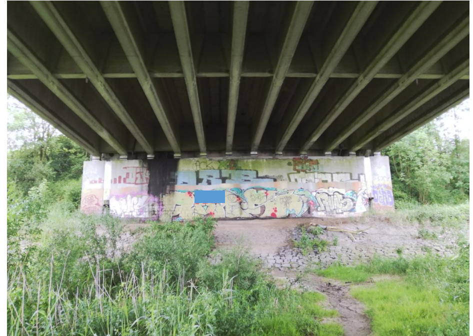
Zicht op het zuidelijke landhoofd.
