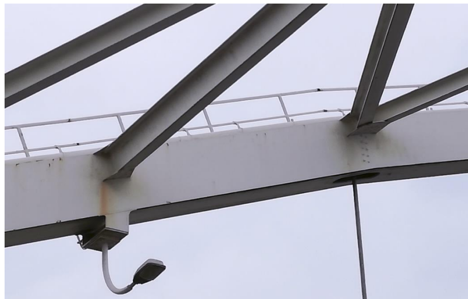
Andere delen van het bovenwindverband zijn bij de aansluiting op de boogrand gelast. Ook de lantaarn uit 1976 is gelast.
