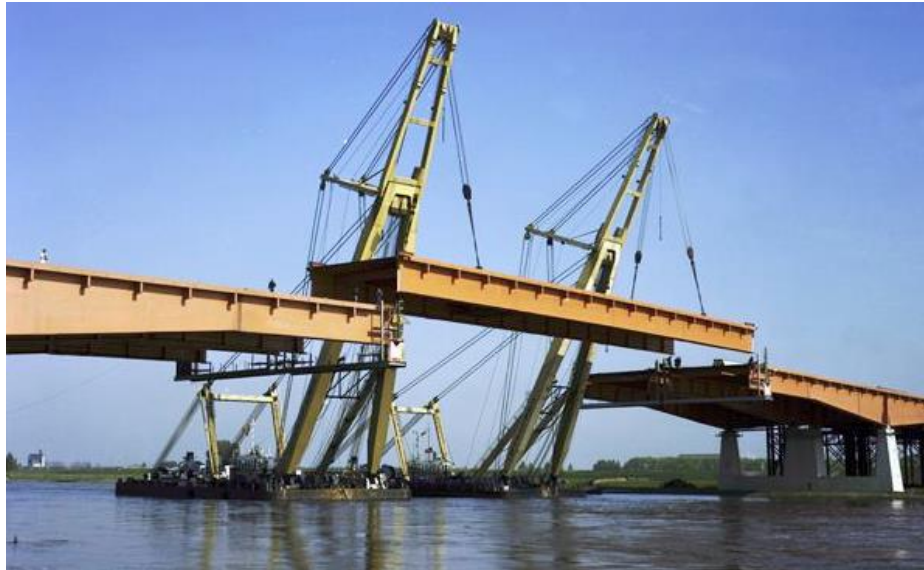
Het laatste deel van de overspanning van de Hagesteinsebrug wordt in 1978 ingevaren en geplaatst. RWS beeldbank, Afdeling Multimedia Rijkswaterstaat, nr. 24970-020.
