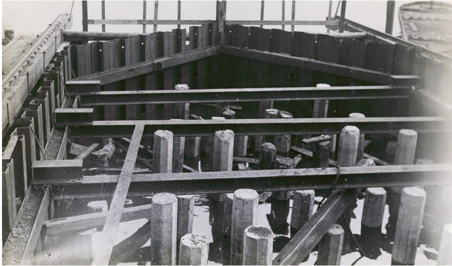
Zicht op de funderingspalen van de waterpijler. RAT coll. 2639, Collectie foto's en glasnegatieven Geertruidenberg, 1870-2000, inv.nr. 604819.
