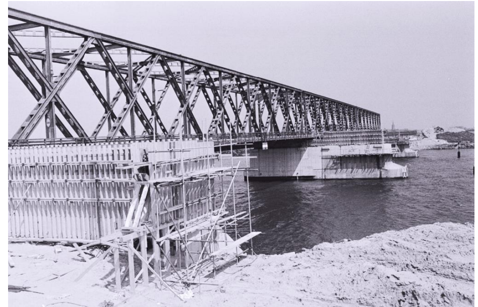
Zicht op de verbreding van de pijlers. SB beeldbank nr. JVG19770704018.
