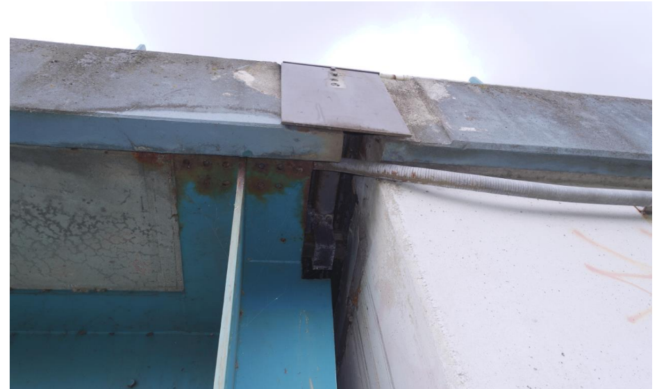
Detail van de overgang tussen zijoverspanning en noordelijk landhoofd met de afdekking van de rijvoeg door een stalen plaat.
