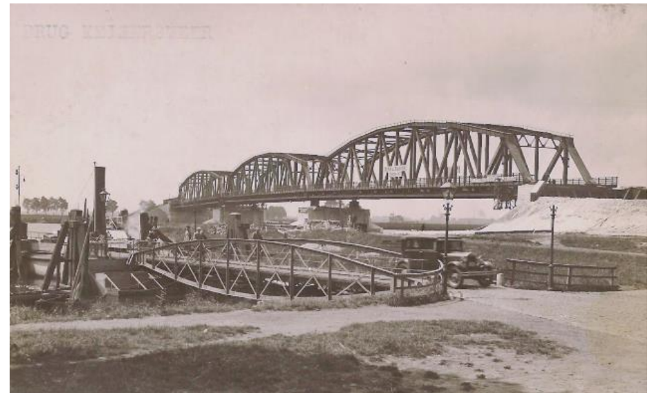
Foto van vlak voor de oplevering van de brug in 1931 met op de voorgrond de aanlegplaats voor het veerpont aan de noordelijke zijde van de Bergsche Maas.
