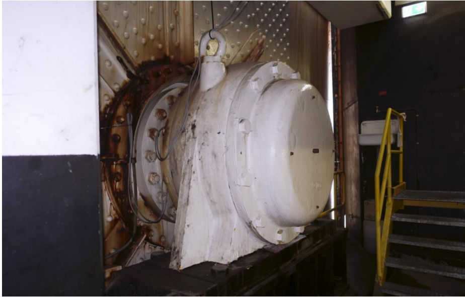
Zicht op het draaipunt aan de buitenzijde van de westelijke hoofdligger.
