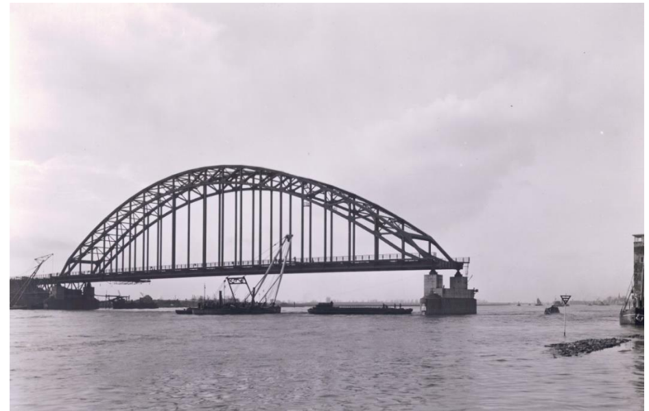
Zicht op de bouw van de boogbrug over de Noord bij Hendrik Ido Ambacht in 1939. RWS beeldbank, Afdeling Multimedia.
