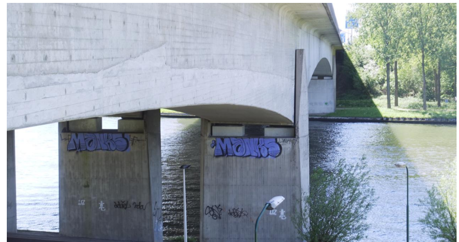
Detail van de onderrand bij de buitenste koker van de zijoverspanning aan de noordzijde van de oever, waar een lichter type beton is toegepast.
