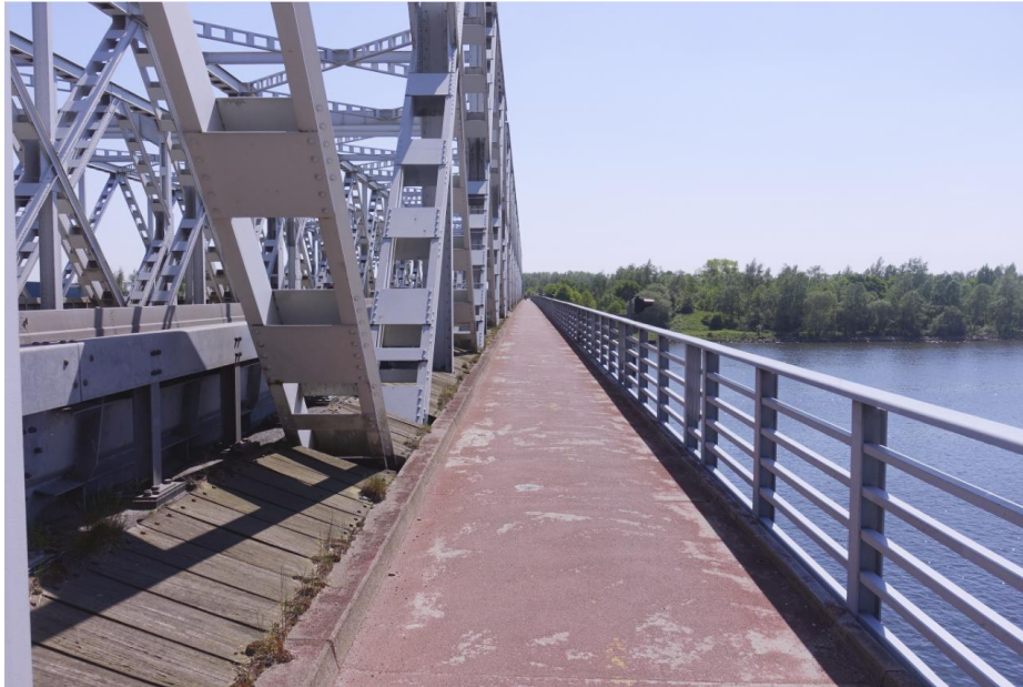
Zicht op het fietspad aan de westzijde van de brug, gezien in zuidelijke richting.
