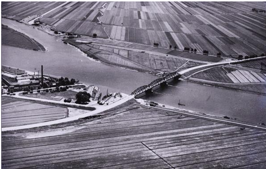
Luchtfoto van de Keizersveerbrug vlak na oplevering. De haven op de noordoever was toen ook al aanwezig. RWS beeldbank nr. RWS-0902.
