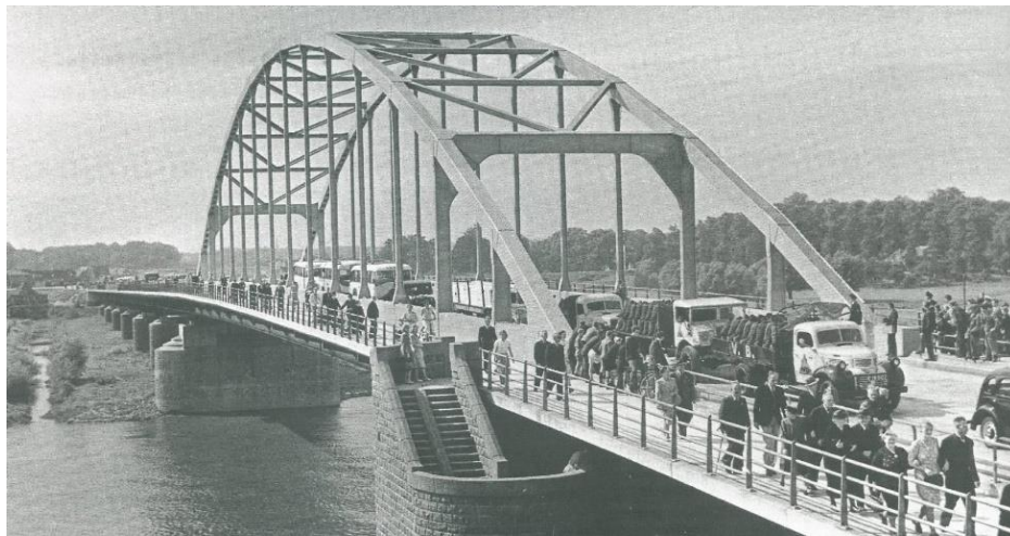
De IJsselbrug in Deventer (1943) was van het type verstijfde staafboogbrug, dat ook veel is toegepast bij de eerste bruggen over het Amsterdam-Rijnkanaal. Ook deze brug heeft fietspaden aan de buitenkant, zoals gebruikelijk in die periode. Het bovenwindverband bestaat hier uit een K-verband. Uit: Bruggen in Nederland 1800-1940 Vaste bruggen van ijzer en staal , (1997)
