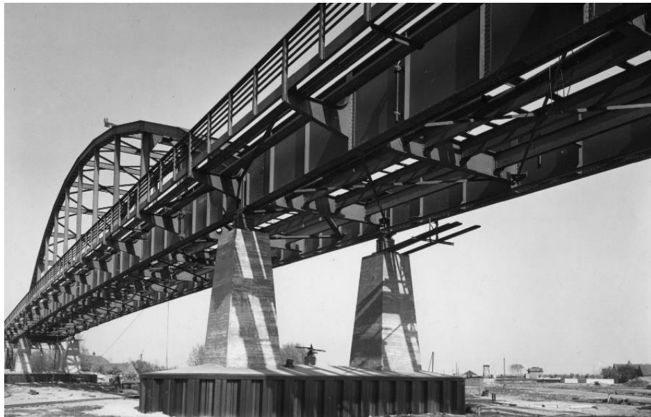
Een brug van het Amsterdam-Rijnkanaal uit 1938. Ook deze brug heeft fietspaden aan de buitenkant, zoals gebruikelijk in die periode. Beeldbank RWS.
