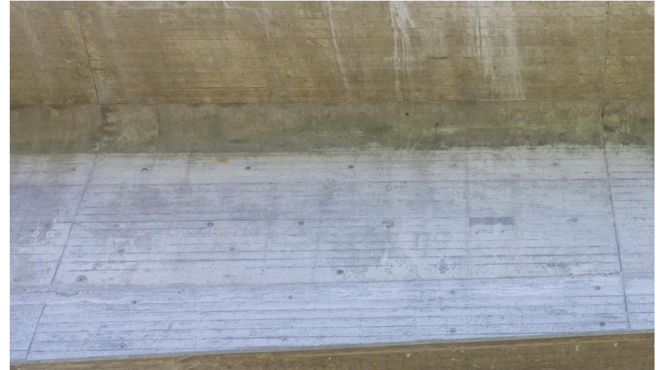
Zicht op een moot bij de buitenste koker van de zijoverspanning aan de noordzijde van de oever. De verticale lijnen geven de afmeting van de gestorte moot aan, de horizontale lijnen en dichtgesmeerde gaten zijn overblijfsels van de bekisting.
