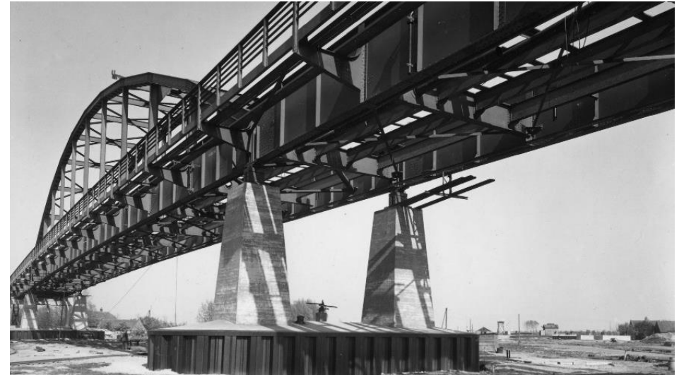
Een brug van het Amsterdam Rijnkanaal uit 1938. Ook deze brug heeft fietspaden aan de buitenkant, zoals gebruikelijk in die periode. Beeldbank RWS, nr. onbekend.
