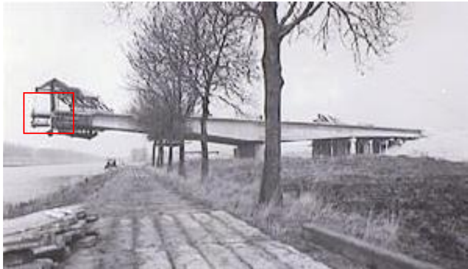
Hoewel slecht zichtbaar op deze foto uit 1980 zijn de onder-, en bovenzijde van de jongste moot al gestort. De zijwanden zijn nog open. RWS beeldbank, maker: Bart van Eyck, nr. 22359-024.
