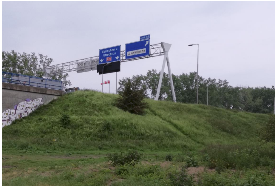
Zicht op het talud van de noordelijke oprit.
