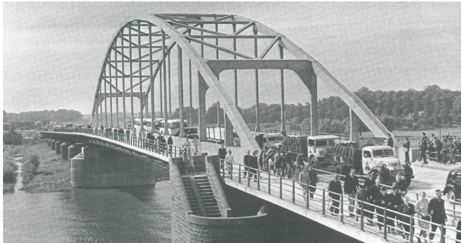
De IJsselbrug in Deventer (1943) was van het type verstijfde staafboogbrug, dat ook veel is toegepast bij de eerste bruggen over het Amsterdam-Rijnkanaal. Ook deze brug heeft fietspaden aan de buitenkant, zoals gebruikelijk in die periode. Het bovenwindverband bestaat hier uit een K-verband. Uit: Bruggen in Nederland 1800-1940 Vaste bruggen van ijzer en staal , (1997)
