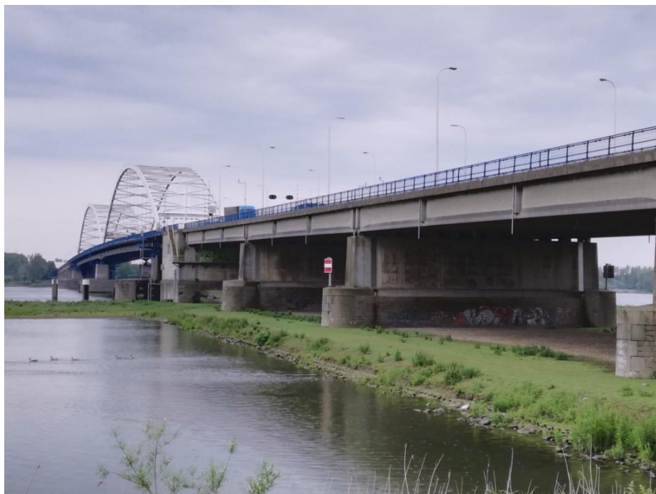
De Merwedebrug gezien vanaf de zuidoever met op de voorgrond de aanbruggen, dan de basculebrug en vervolgens de twee boogbruggen.
