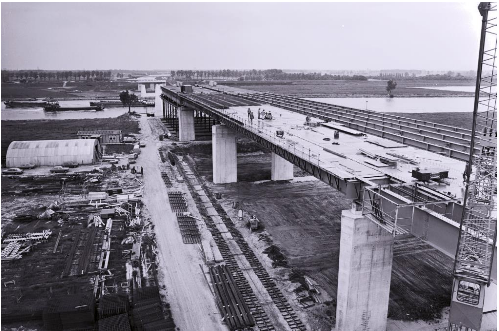
De bouw van de Hagesteinsebrug is in volle gang, gezien vanaf de zuidoever. De aanbruggen zijn al aan beide zijden van de Lek opgetrokken en voorzien van een bovenbouw. Alleen boven de Lek is nog geen overspanning aanwezig. RWS beeldbank.
