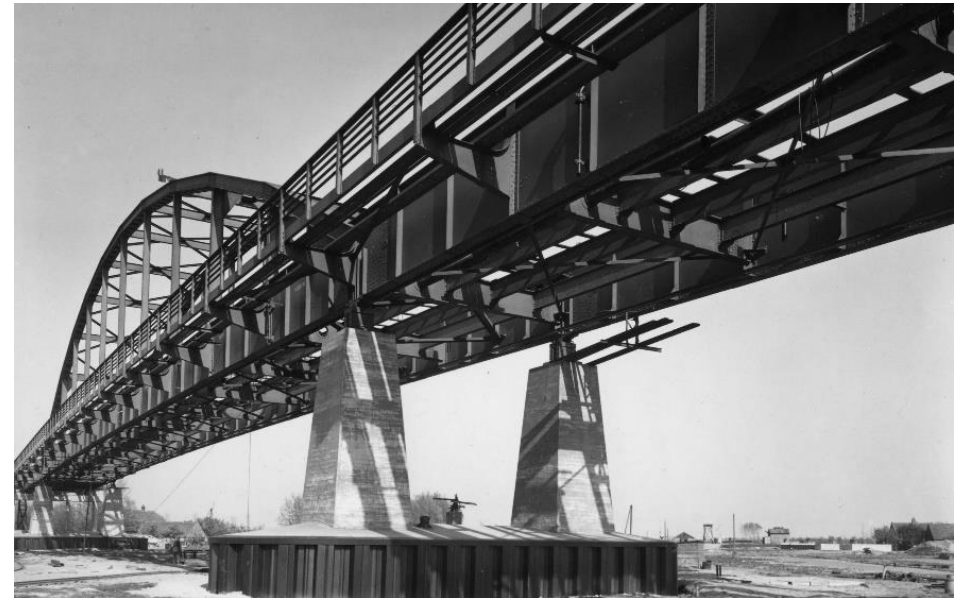
Een brug van het Amsterdam Rijnkanaal uit 1938. Ook deze brug heeft fietspaden aan de buitenkant, zoals gebruikelijk in die periode. Beeldbank RWS.
