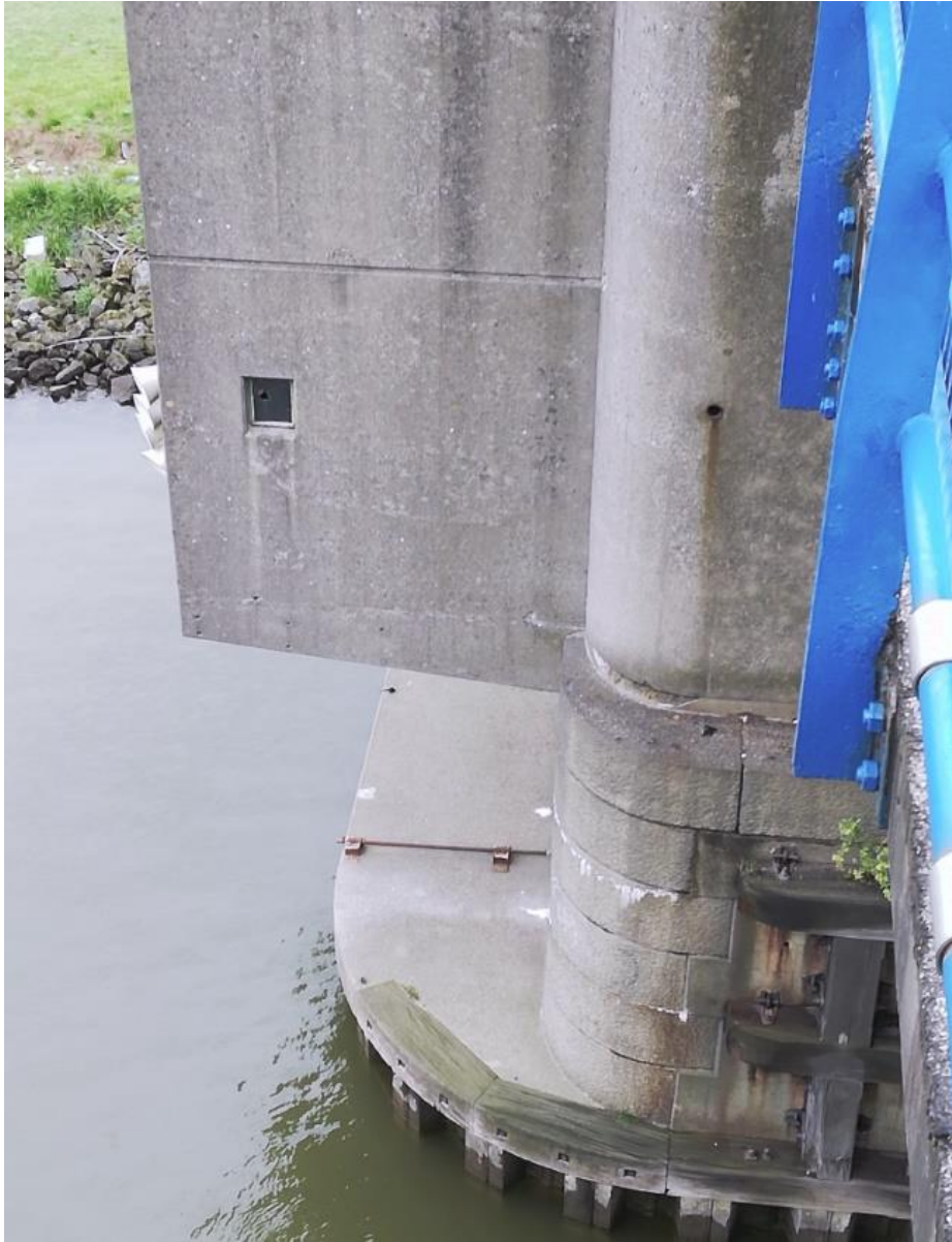
Zicht op de onderzijde van de westelijke helft van de basculepijler, met links de onderbouw van het brugwachtershuis.
