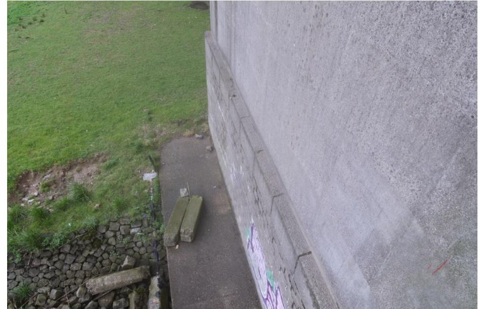
Detail van de westgevel van de basculepijler.
