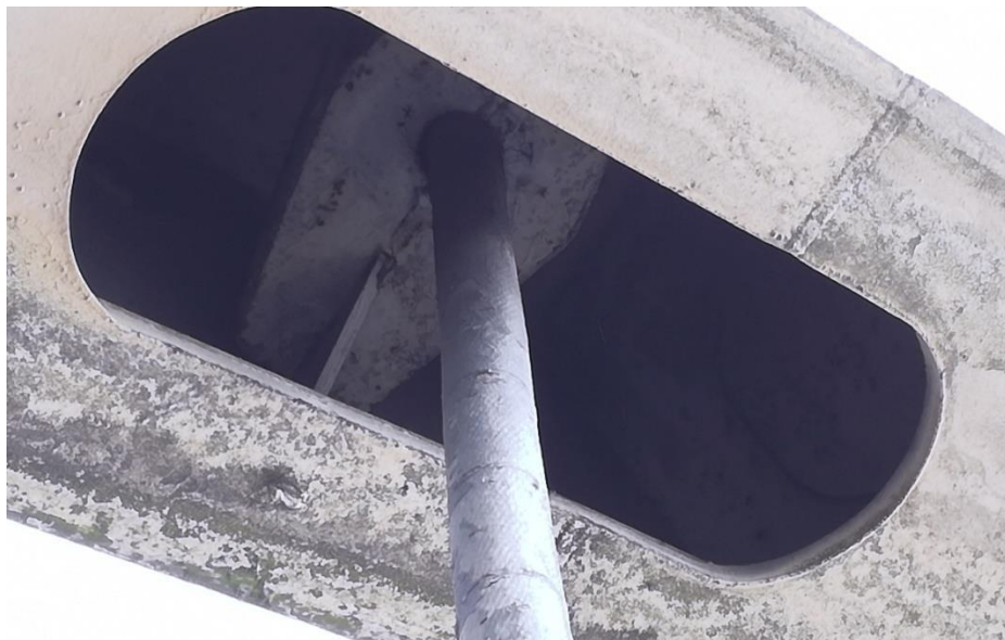
De staalkabels zijn vastgemaakt in de boogrand via een stalen console.
