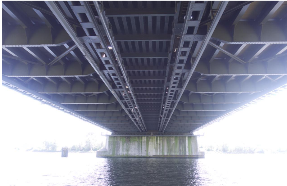
Zicht op de onderbouw van de brug, gezien vanaf de noordoever.
