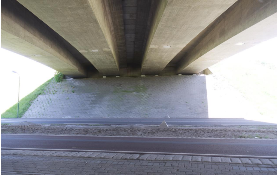
Zicht op het noordelijke landhoofd met betontegels onder de kokers.
