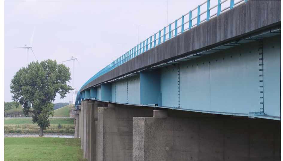
De zijoverspanning op de zuidoever, gezien richting het noorden.
