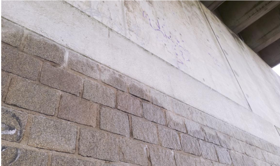
Detail van het opgaande werk van een van de pijlers van de noordelijke aanbrug.
