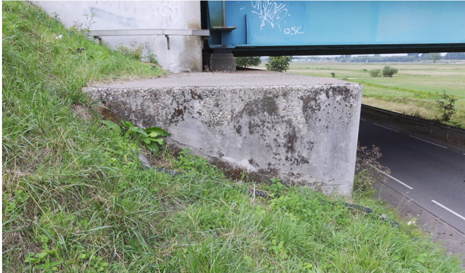
Zicht op de betonnen onderstoel van het zuidelijke landhoofd.
