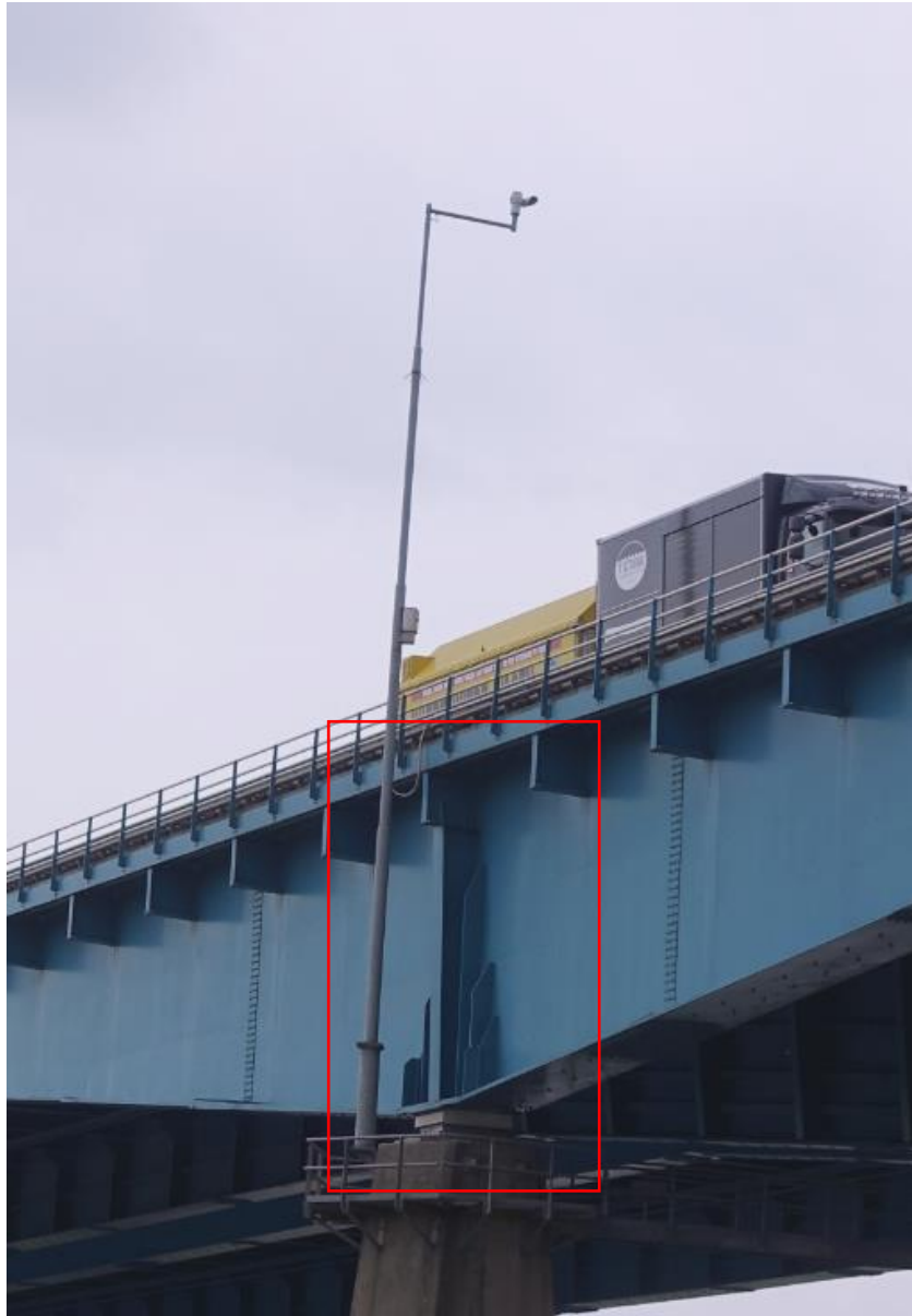
Zicht op de buitenzijde van de hoofdligger waar ter hoogte van de oplegging een sobere decoratie is aangebracht in staalwerk.
