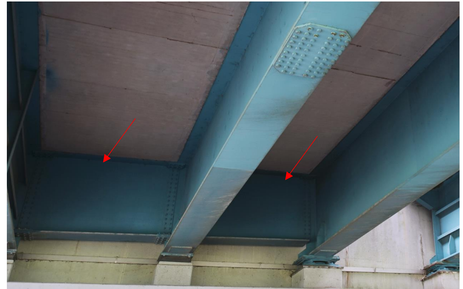
Zicht op de dwarsverbanden tussen de langsliggers van de zijoverspanning ter hoogte van het zuidelijke landhoofd.
