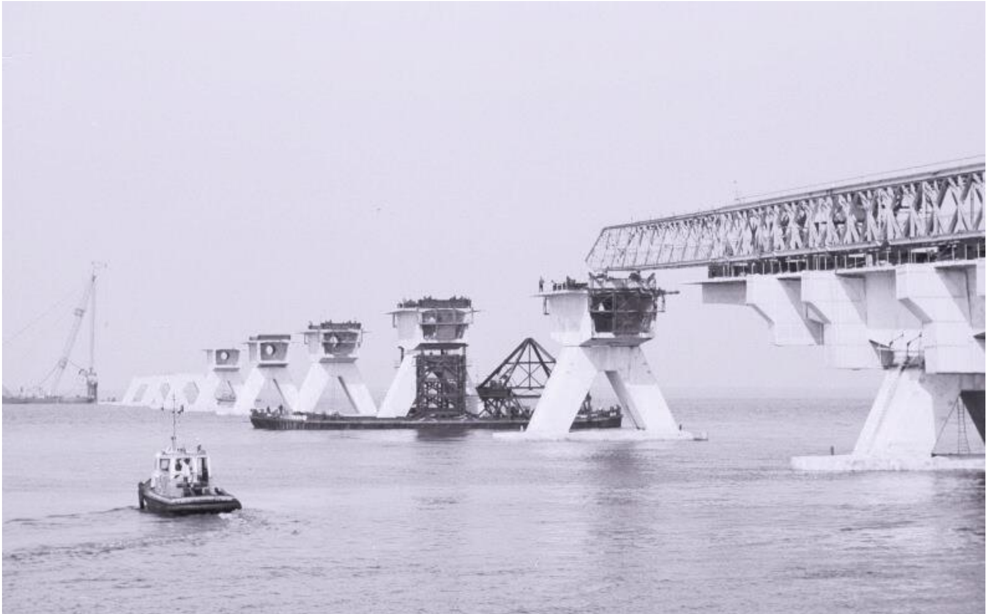
De bouw van de Zeelandbrug op een foto uit 1964. Aan de bovenzijde van de pijlers is de koker in de bovenbouw zichtbaar. Zeeuwse Bibliotheek beeldbank, foto: C. Kotvis.
