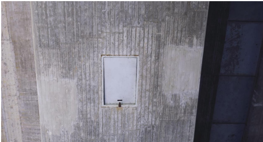
Detail van het stalen luik aan de onderzijde van een van de kokers, ter hoogte van de zijoverspanning.
