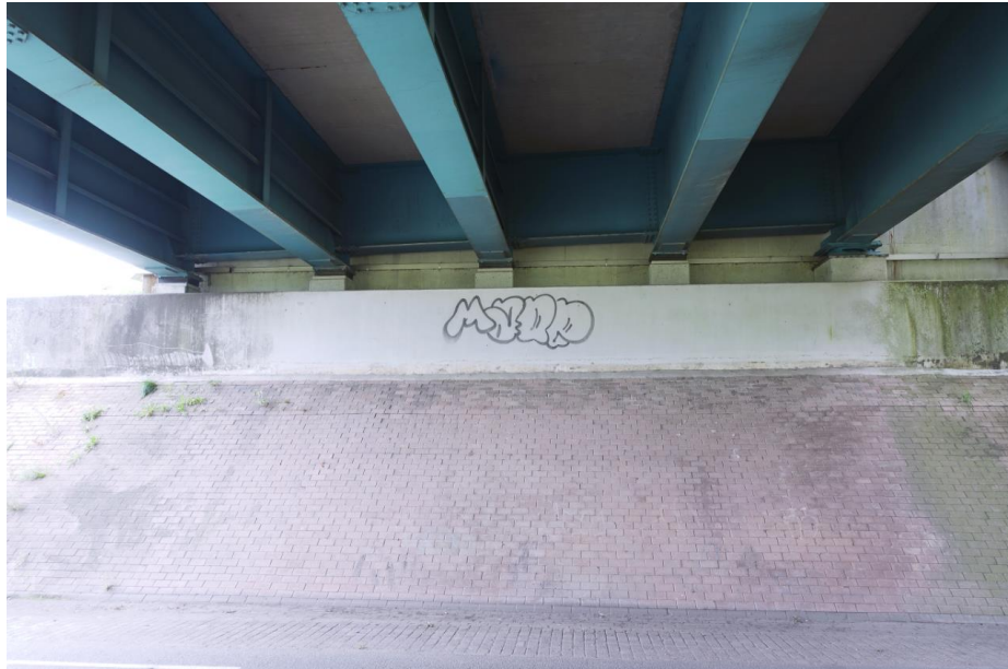
Detail van het zuidelijke landhoofd met de talusbekleding.
