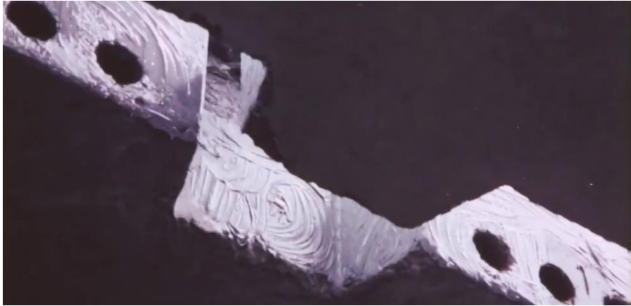
Zicht op de aangebrachte en nog natte epoxylijm op de kopse kanten van de prefab elementen bij de bouw van de brug over de Brielse Maas in 1969. De gaten worden na plaatsing gevuld met de spanningskabels van het voorgespannen beton en zo tegen elkaar aan gedrukt. Uit: Over lijmen gesproken , promotiefilm provincie Zuid-Holland, 1967-1968.
