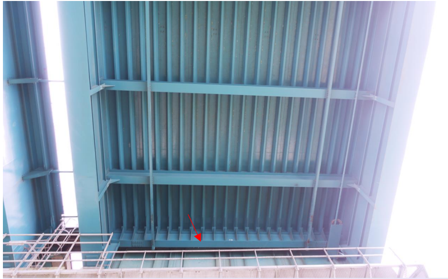
De onderzijde van de hoofdoverspanning gezien vanaf de grond. De hoofdliggers zijn uitgevoerd met langs- en dwarsverbanden. De einddwarsliggers hebben een versterking van consoles (rode pijl).
