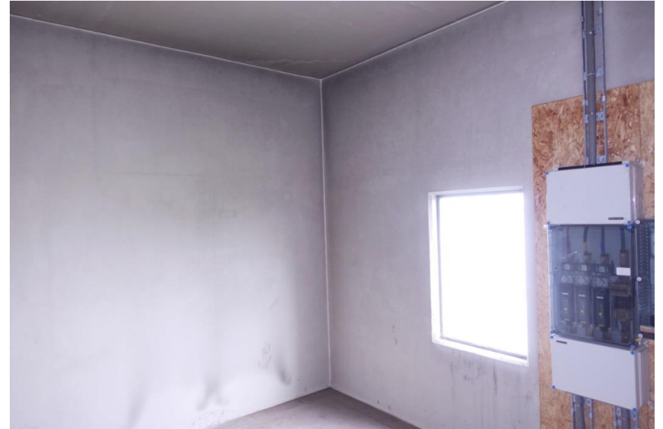
Zicht op de ruimte in het brugwachtershuis op de tweede verdieping.
