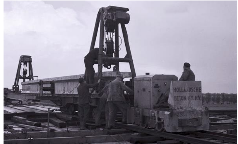
Het vervoeren van de ter plekke gemaakte betonnen langsliggers door middel van een locomotief. RWS beeldbank, Afdeling Multimedia, nr. 24035-035.
