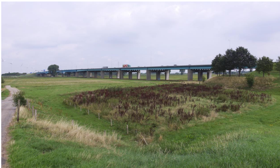
De Hagesteinsebrug gezien vanaf de zuidelijke Lekdijk, gezien vanuit het zuidwesten.
