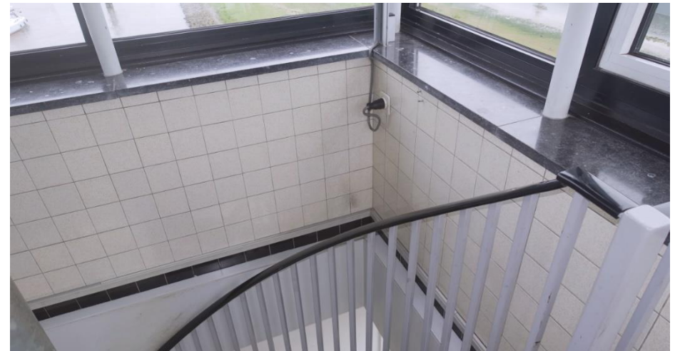
Zicht op de tegellambrisering en vensterbank op het bovenste niveau van het brugwachtershuis.
