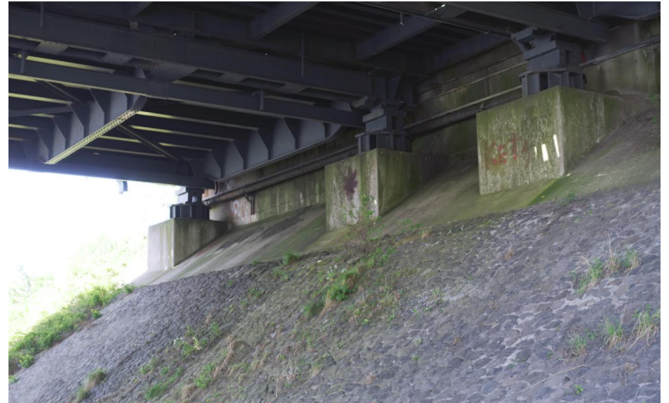
Zicht op de opleggingen bij het noordelijke landhoofd.
