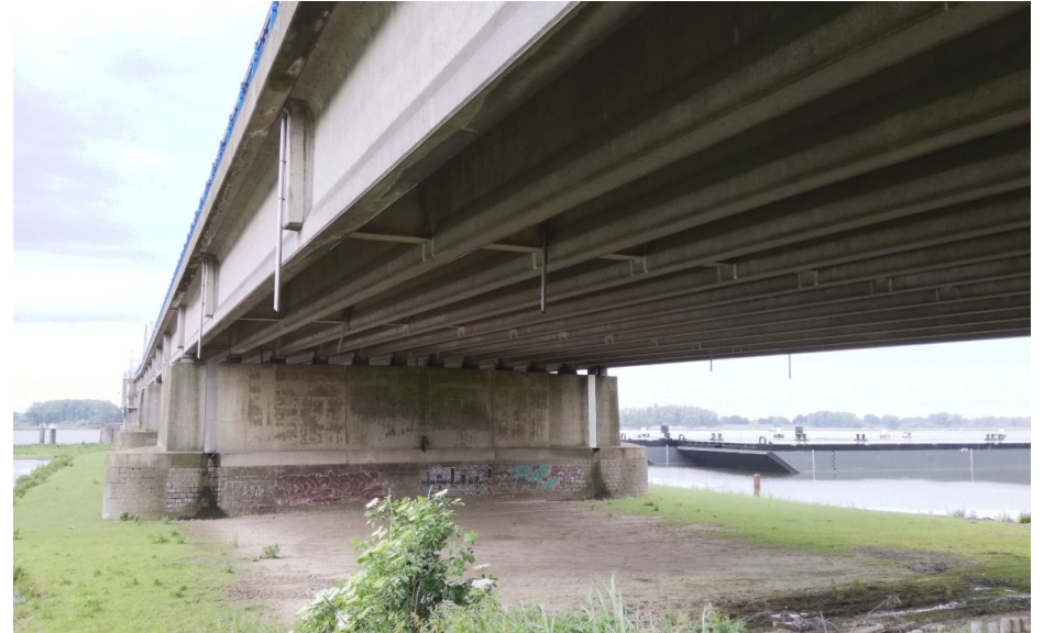
Zicht op de pijler bij de noordelijke aanbrug.
