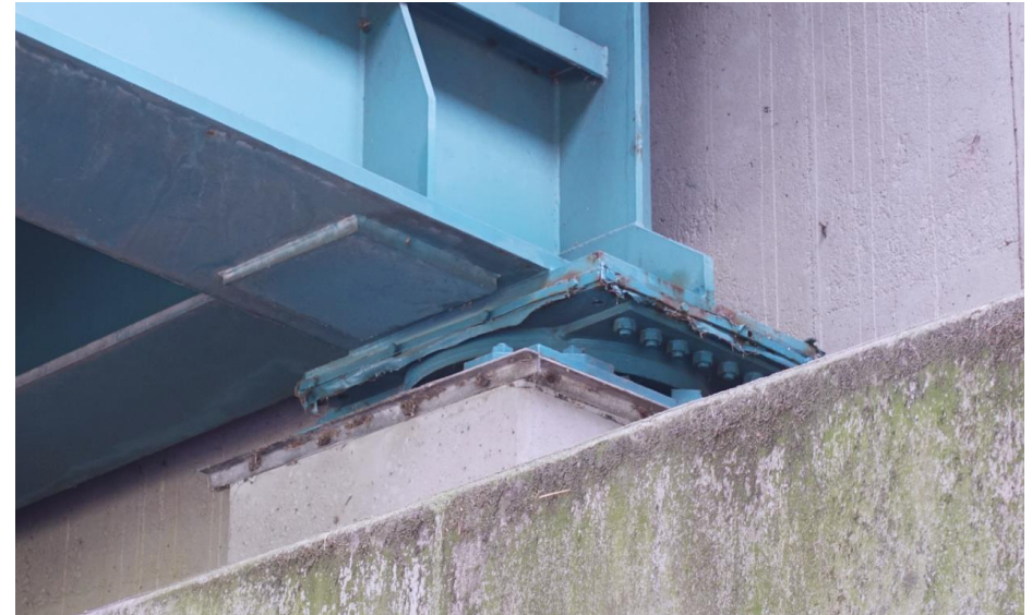
Detail van de oplegging uit 1999 bij het noordelijke landhoofd.
