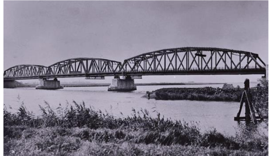
De Keizersveerbrug na oplevering in 1931. RWS beeldbank nr. RWS-0311.
