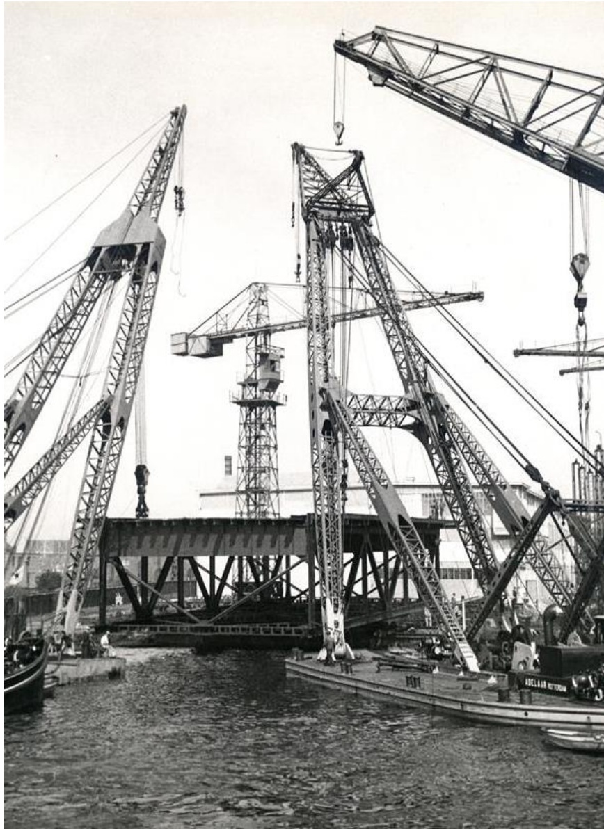
De plaatsing van het val in 1939 bij de brug over het Noord bij Alblasterdam geschiedde met veel drijvende kranen. RWS Beeldbank, nr. onbekend.
