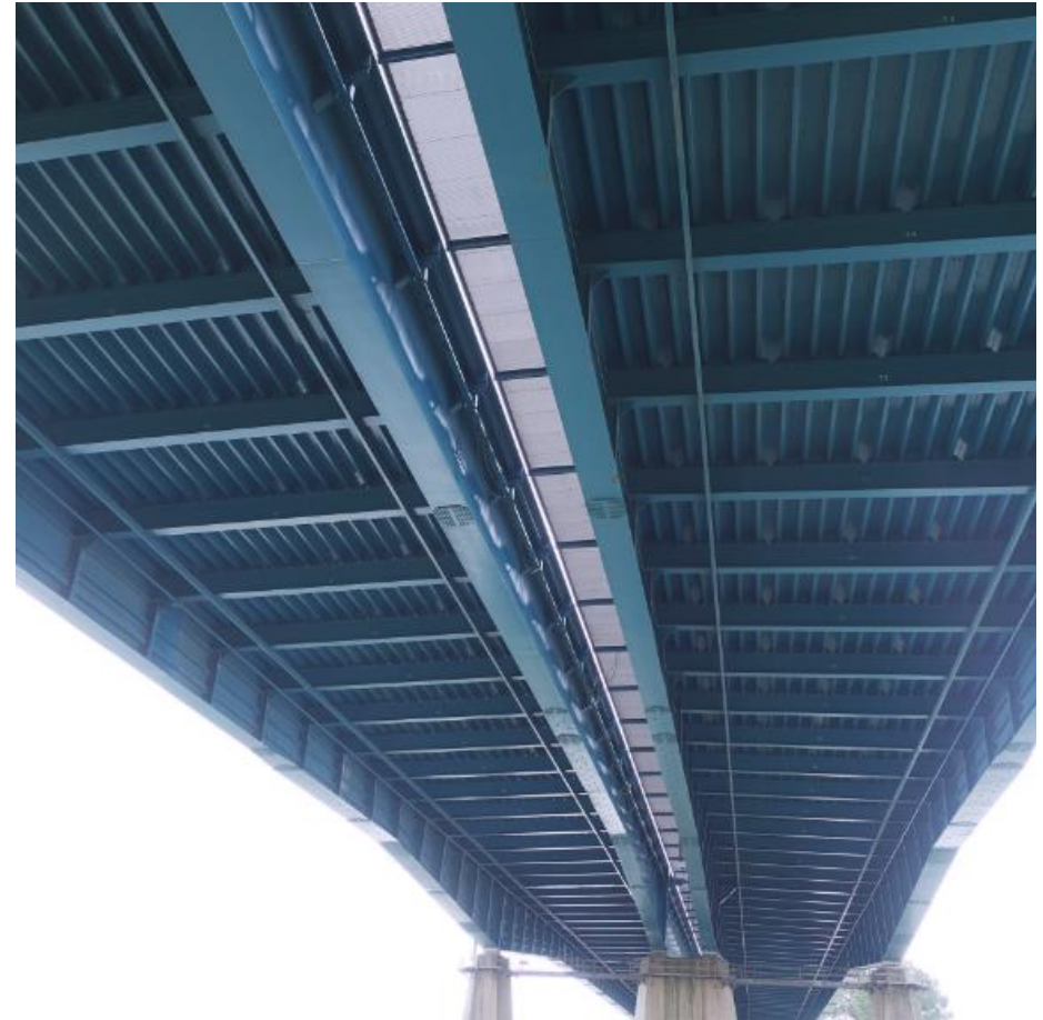
Zicht op het pad tussen de twee weghelften bij de hoofdoverspanning.
