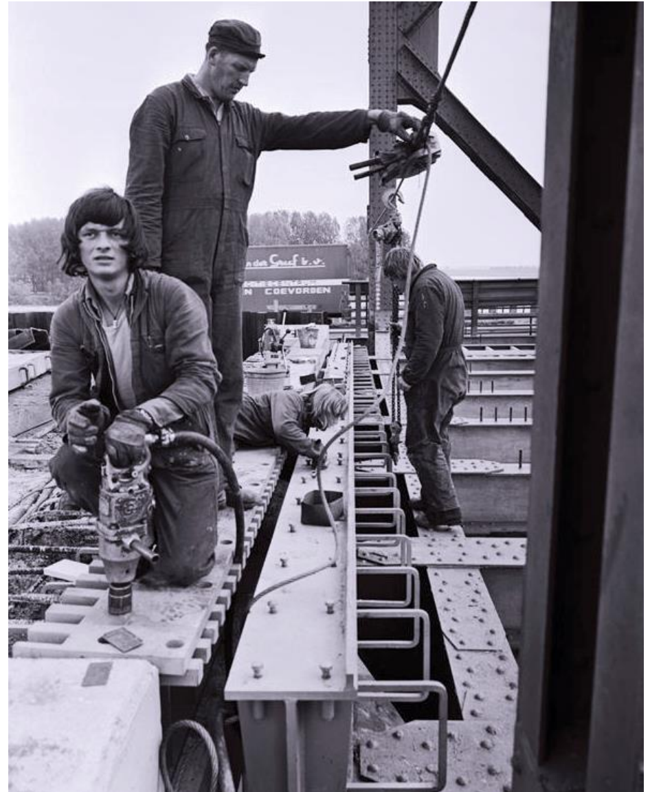
De rijvoegen bij de herplaatste delen van de voormalige Moerdijkbrug over de Bergsche Maas zijn in 1977 vervangen voor nieuwe varianten. RWS beeldbank nr. 23737-013.
