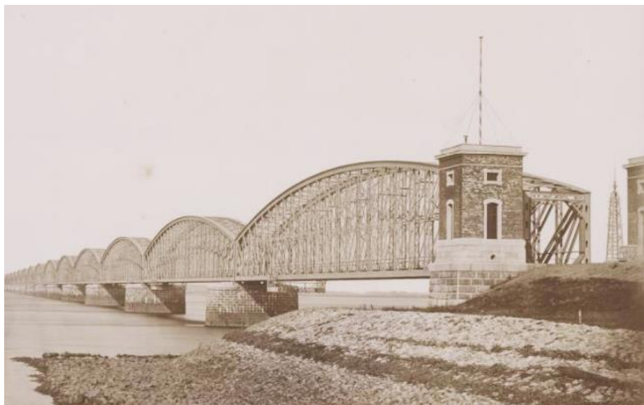
De spoorbrug met enkelvoudige vakwerkliggers met een gebogen bovenrand bij Moerdijk uit 1871. RA beeldbank, maker: Pieter Oosterhuis.
