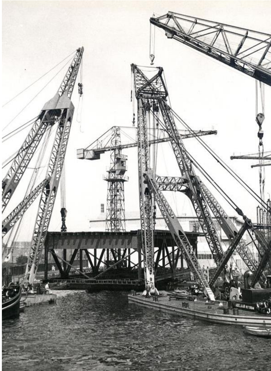
De plaatsing van het val in 1939 bij de brug over het Noord bij Alblasserdam geschiedde met veel drijvende kranen. RWS Beeldbank.
