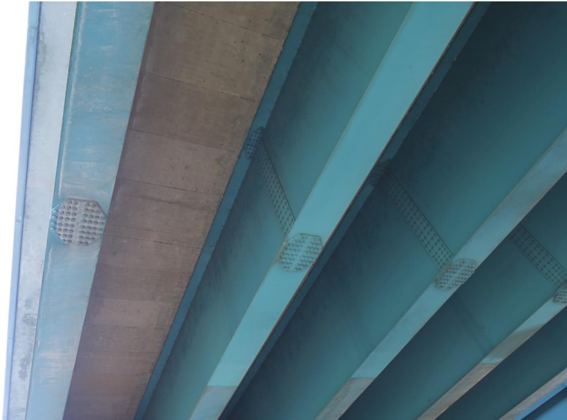
Detail van het betonnen rijdek bij de aanbruggen.
