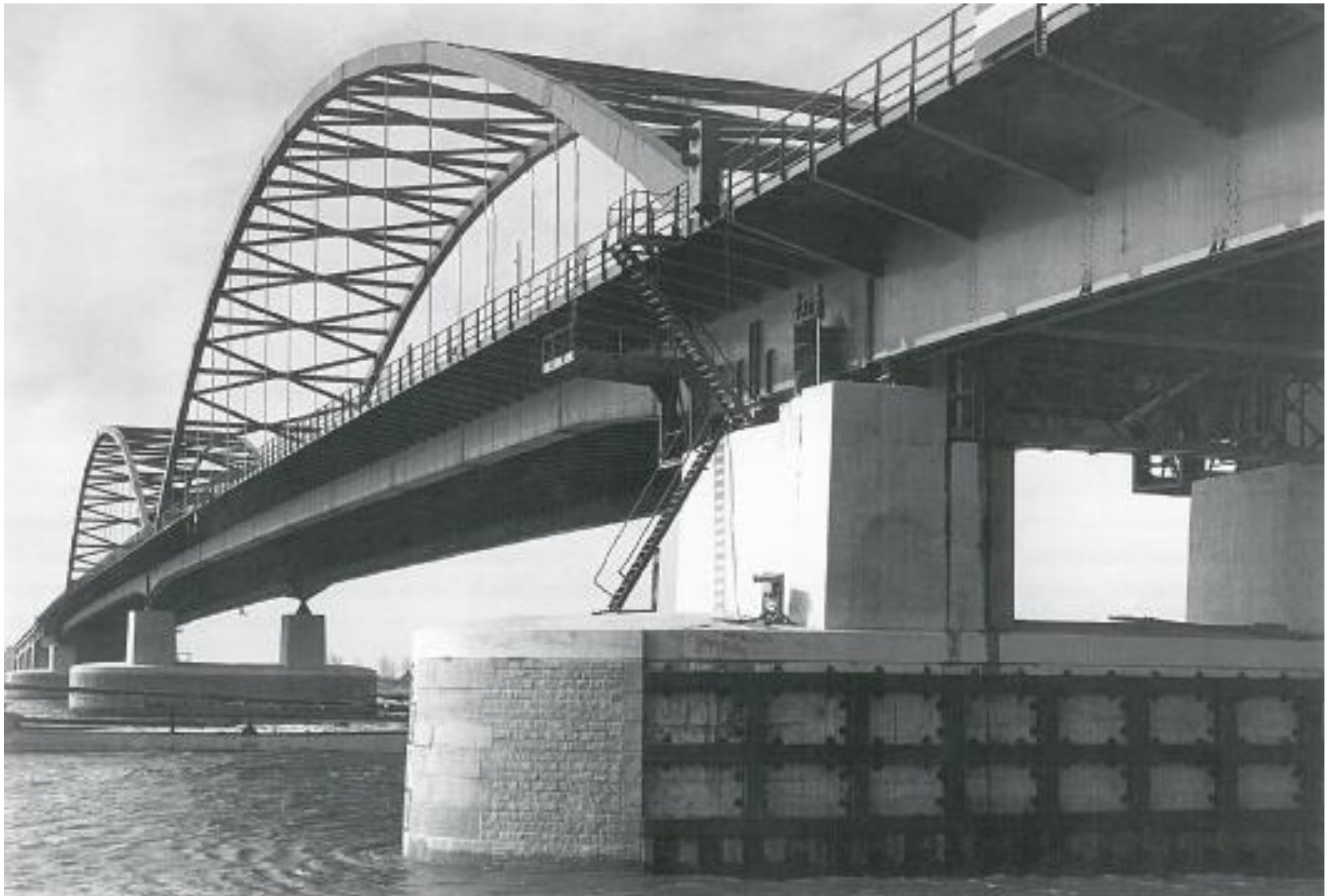
Zicht op de Merwedebrug, gezien vanaf het water richting het zuiden. Het onderlinge verschil in opbouw tussen de rivierpijlers is goed zichtbaar met op de voorgrond de brede rivierpijler bij het val en de aansluiting met de boogbrug. afb: M. Otto (eind.red.) 2008, p.17.
