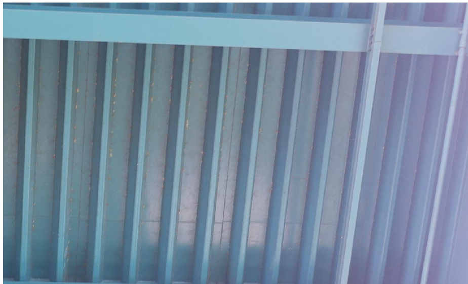
Detail van het rijdek van stalen platen bij de hoofdoverspanning.
