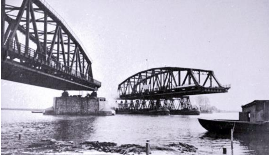
Het invaren van een overspanning van de Keizersveerbrug over de Bergsche Maas. RWS beeldbank nr. RWS-0309.
