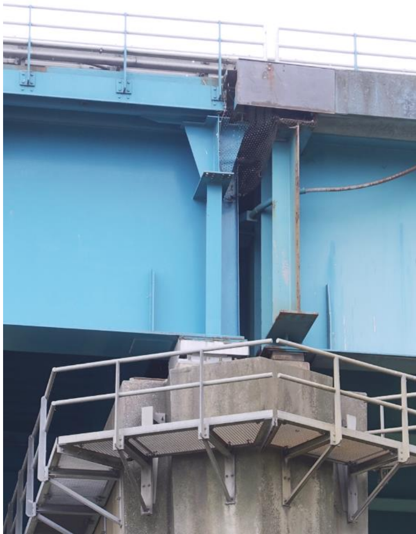
Detail van de oplegging van de noordelijke hoofdligger (links) en de aanbrug (rechts). Op de voorgrond de omgaande loopbrug.
