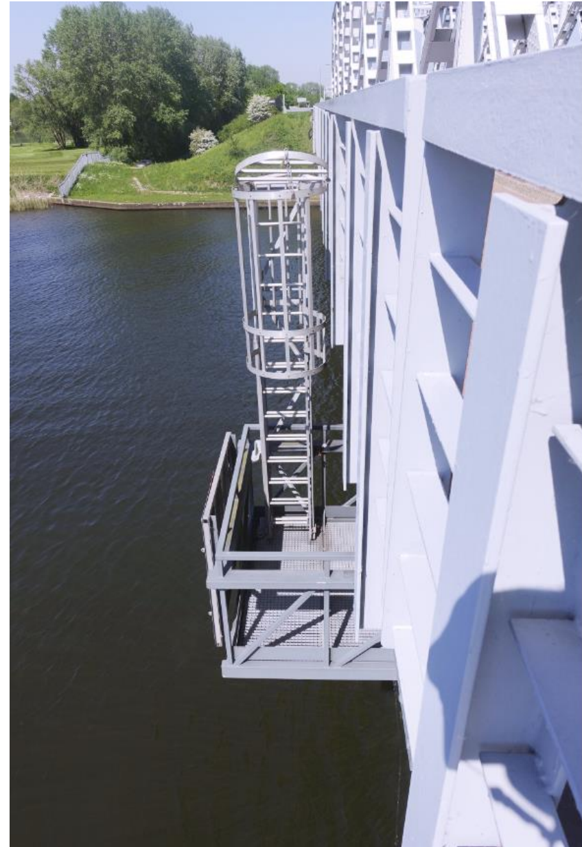
Zicht op de verfwagen en met valhekken uitgevoerde ladder uit 1978.
