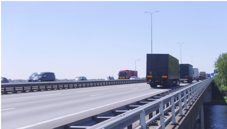
Zicht op de bovenste laag van het rijdek.
