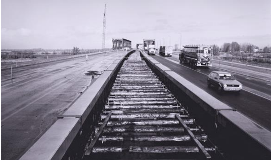
Zicht op de noordelijke oprit naar de Keizersveerbrug. Tussen de aangebrachte brugdelen is een strook aangebracht met eigen oprit voor langzaam verkeer. RWS beeldbank nr. 24703-001.
