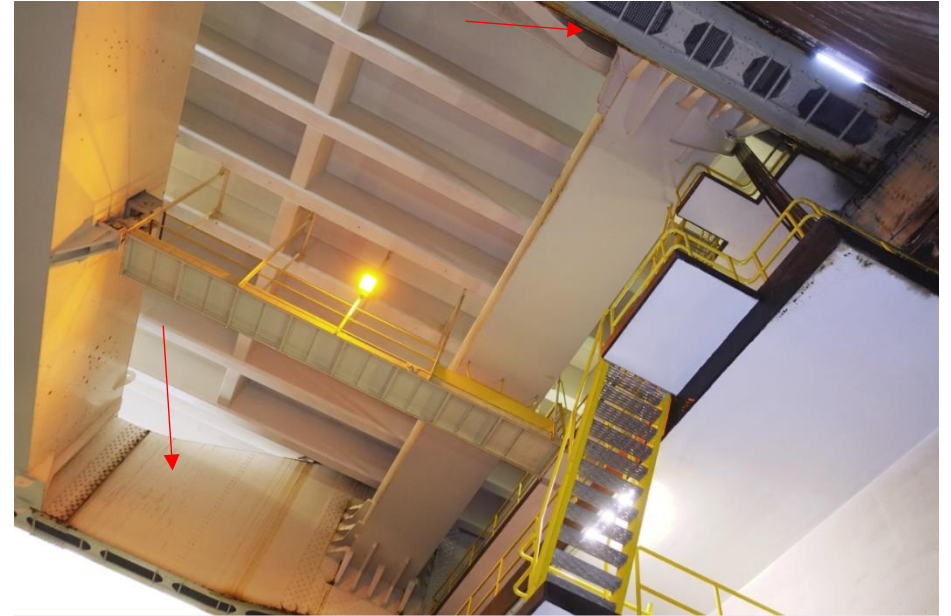
Zicht op de hoofdliggers van het val, gezien vanaf de begane grond vloer in de open ruimte.
