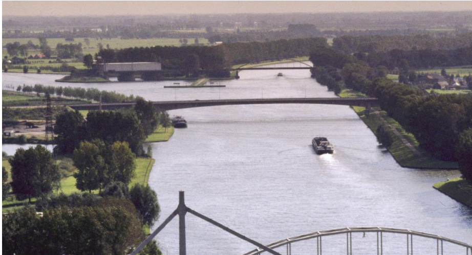
Zicht op de bruggen over het Amsterdam-Rijnkanaal bij Nieuwegein, met centraal de Nieuwegeinsebrug uit 1980. Deze brug is van een soortgelijk type als de Houtensebrug. UA beeldbank: coll. Herman Verschuur, nr. 834875.
