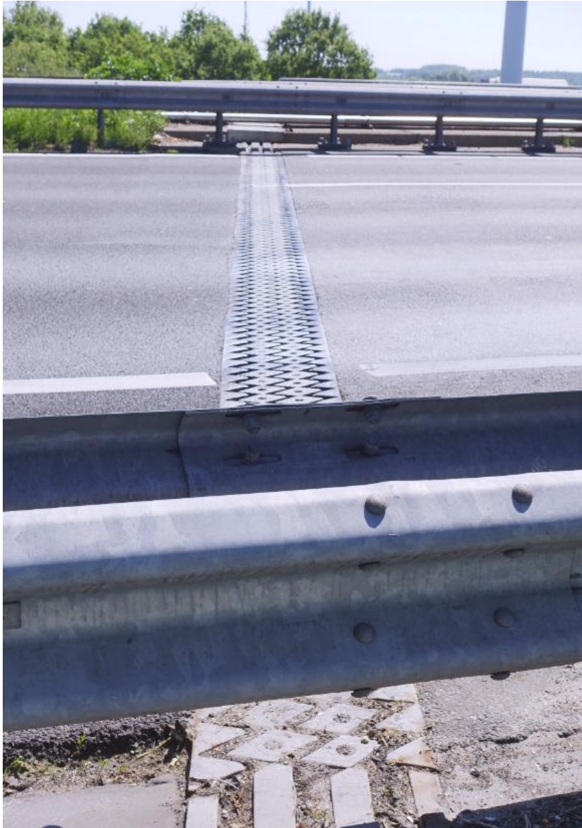
Zicht op de rijvoeg bij de overgang van oprit naar zijoverspanning aan de noordzijde van de brug.
