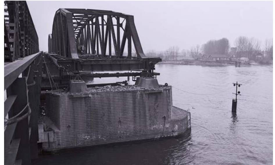
Zicht op de zuidelijke pijler van het middelste brugdeel van de oude Keizersveerbrug. De pijler zou gehandhaafd worden bij plaatsing van de vervangende brugdelen. RWS beeldbank nr. 23741-014.
