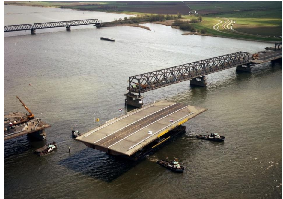
Plaatsing van de nieuwe bovenbouw bij de verkeersbrug bij Moerdijk. Deze delen zijn gemaakt met stalen kokerliggers die een trapeziumvorm hebben. Hierdoor kan een veel breder wegdek worden gemaakt. RWS beeldbank.
