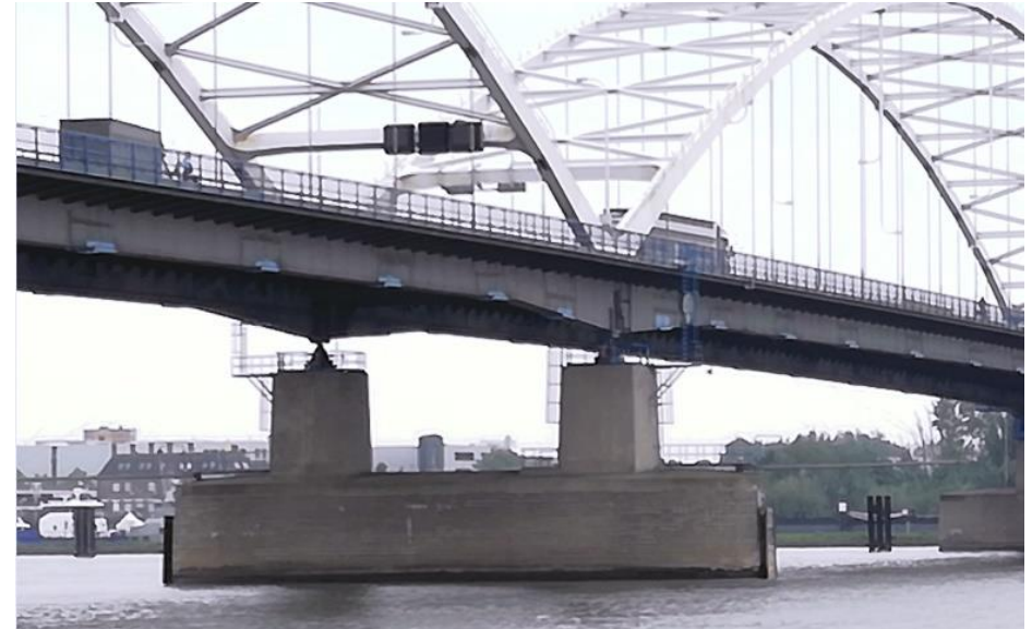
Zicht op de middelste rivierpijler met vaste opleggingen waarbij de bovenbouw ranker en minder massief is uitgevoerd dan bij de andere twee rivierpijlers.
