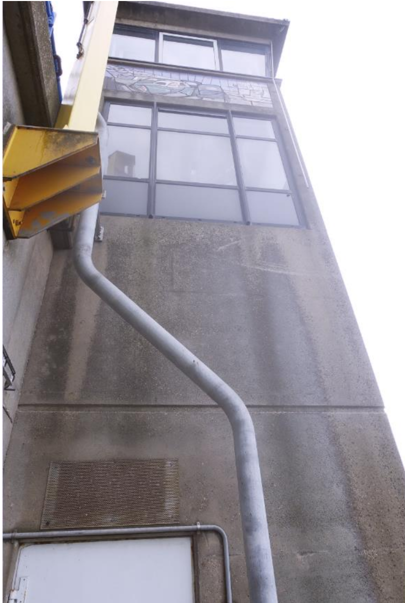
De noordzijde van het brugwachtershuis gezien vanaf het betonnen bordes tegen de westgevel van de basculepijler.
