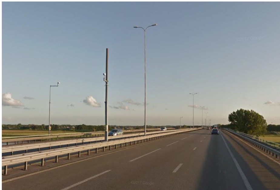
De weghelft op de hoofdoverspanning in de richting naar het zuiden waarbij ook de spitsstrook in gebruik is genomen als weghelft. Google Maps 2018.
