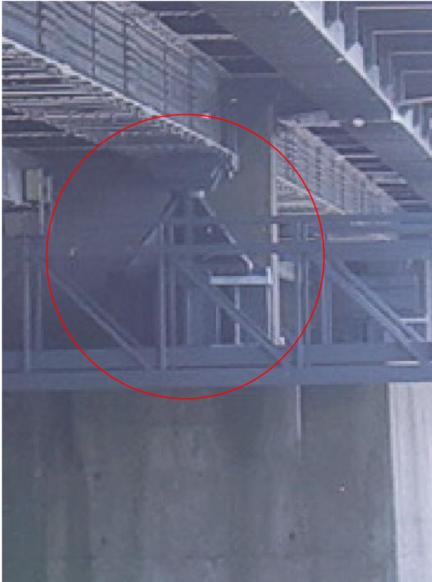
Detailopname van de vaste oplegging op de verbreding bij de noordelijke rivierpijler. Deze oplegging en onderzadel stammen uit 1978.
