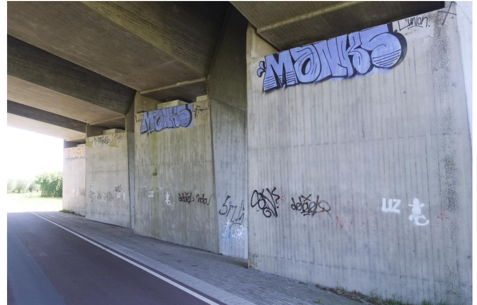
Zicht op de brede zijden van de pijlers, die in drie moten zijn gestort. De diamantvormige zijkant is de vierde constructiefase.
