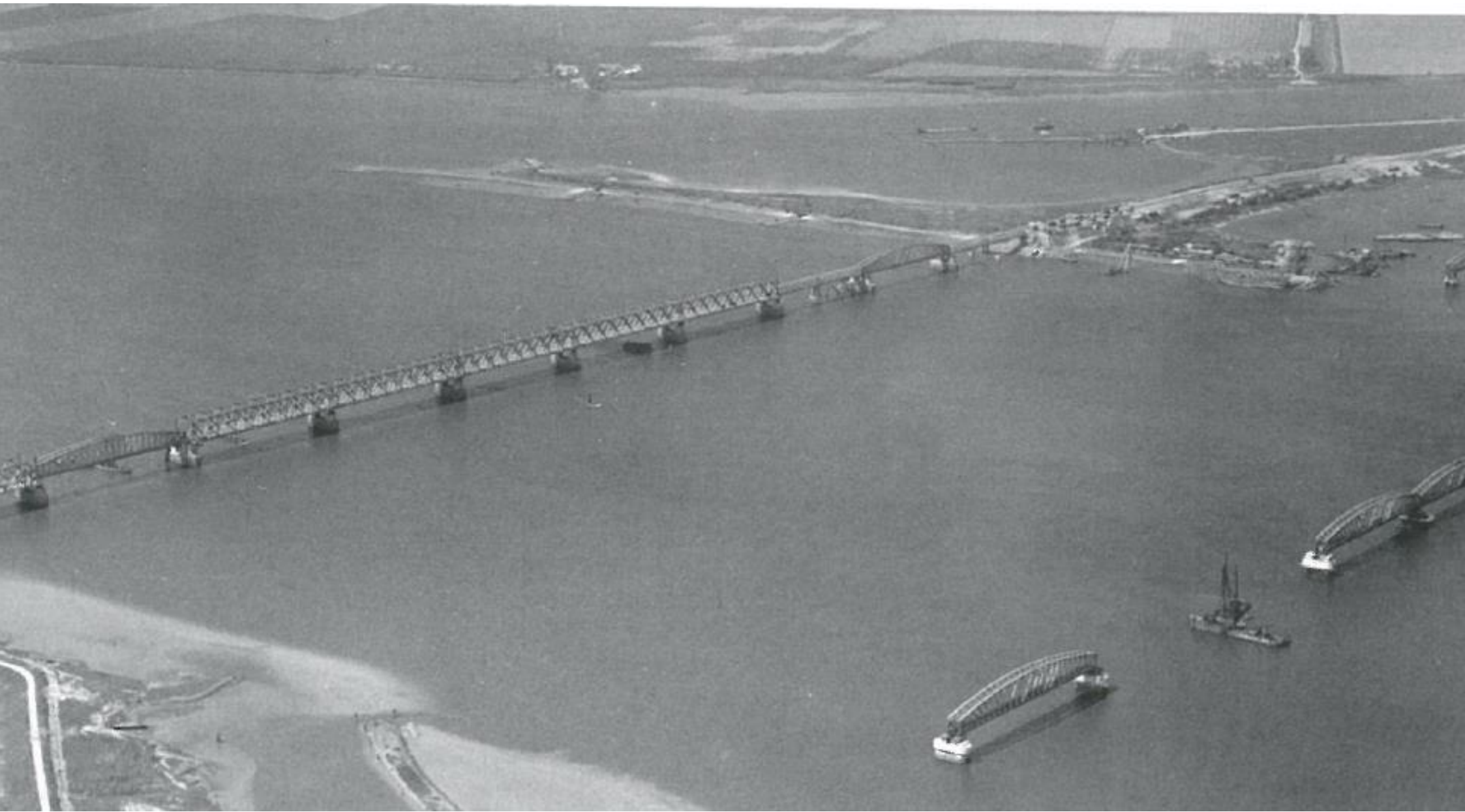
Luchtfoto uit 1945 met op de achtergrond de gerepareerde verkeersbrug bij Moerdijk en op de voorgrond de nog deels verwoeste spoorbrug. Blankenstein (2009), p.227.
