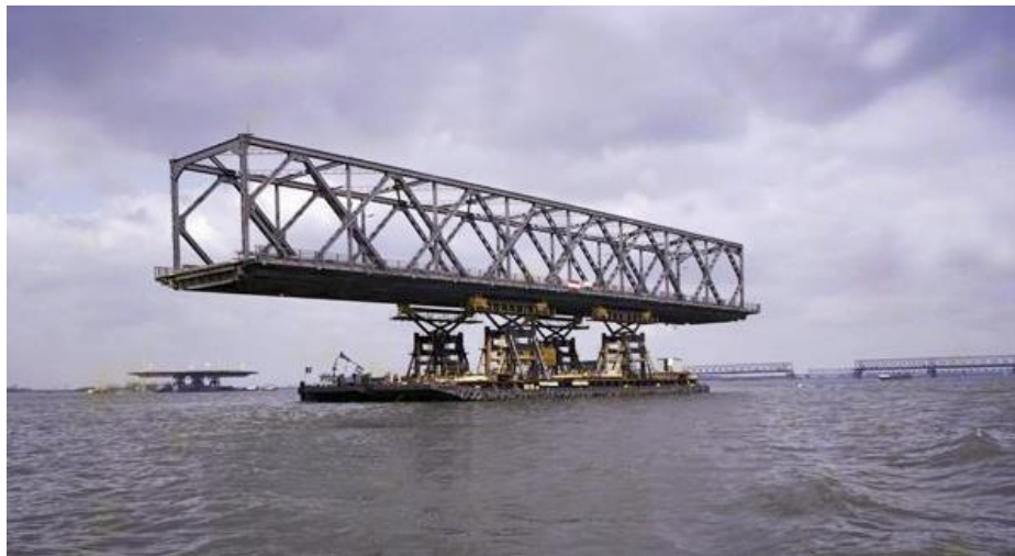
De delen van de bovenbouw zijn na ontmanteling van de Moerdijkbrug op drijvende pontons overgebracht naar de andere locaties in Nederland. RWS beeldbank nr. 23623-089.
