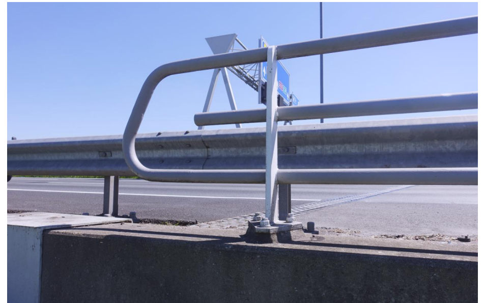
De balustrade langs de uiteinden van de brug heeft een afgeschuind uiteinde.
