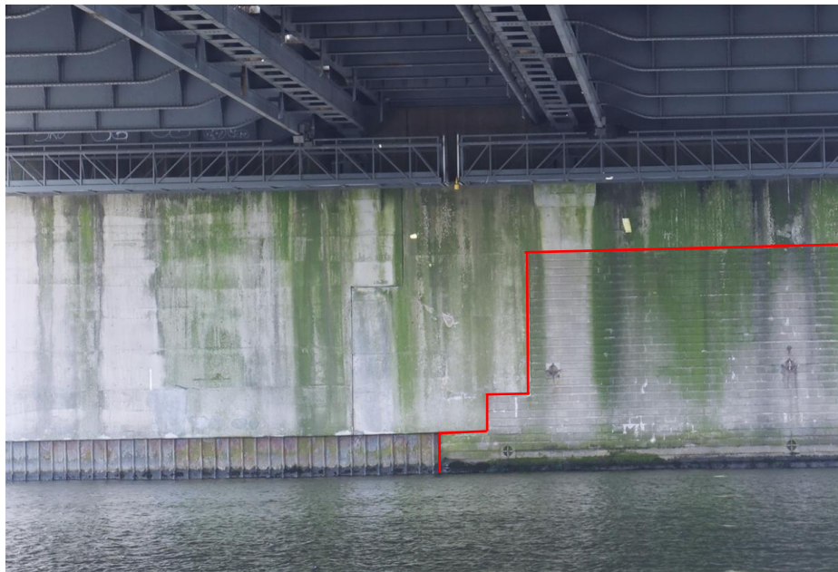
Zicht op de zuidelijke rivierpijler met bij de rode lijn de voeg die is aangebracht bij de verbreding en ophoging van de pijler in 1978. De natuursteen bekleding uit 1929-1931 is nog aanwezig bij de oude pijler.
