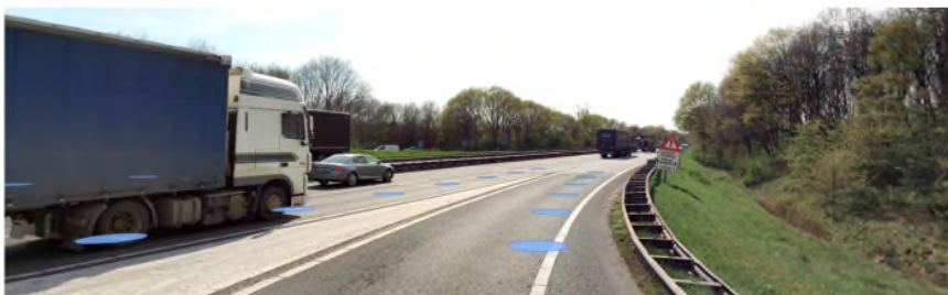
Foto 3-1 Beelden van de toerit van de rotonde bij Bogardeind (bovenste foto) tot de het puntstuk van de toerit (onderste foto)
