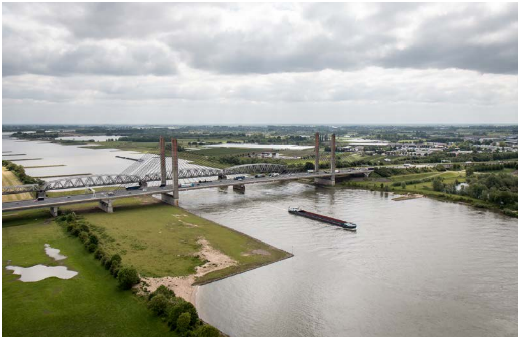
De Martinus-Nijhoffbrug over de Waal
