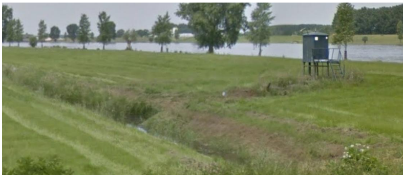
Figuur 4-6 Droge opstelling van gemaal GKM00028 (24 m 3 /min) bij de Sprank Capelse Veerweg.
