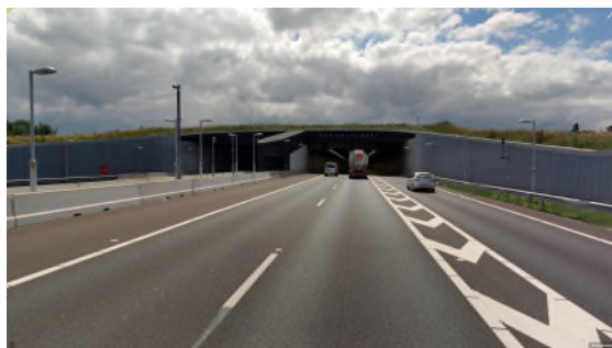
Figuur 4-34: vormgeving rijstrookscheiding in verdiepte ligging
