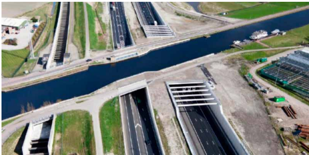
Figuur 3.3: Huidige ligging Ringvaartaquaduct met links de ligging van het oude aquaduct en rechts de ligging van het nieuwe aquaduct uit 2010
