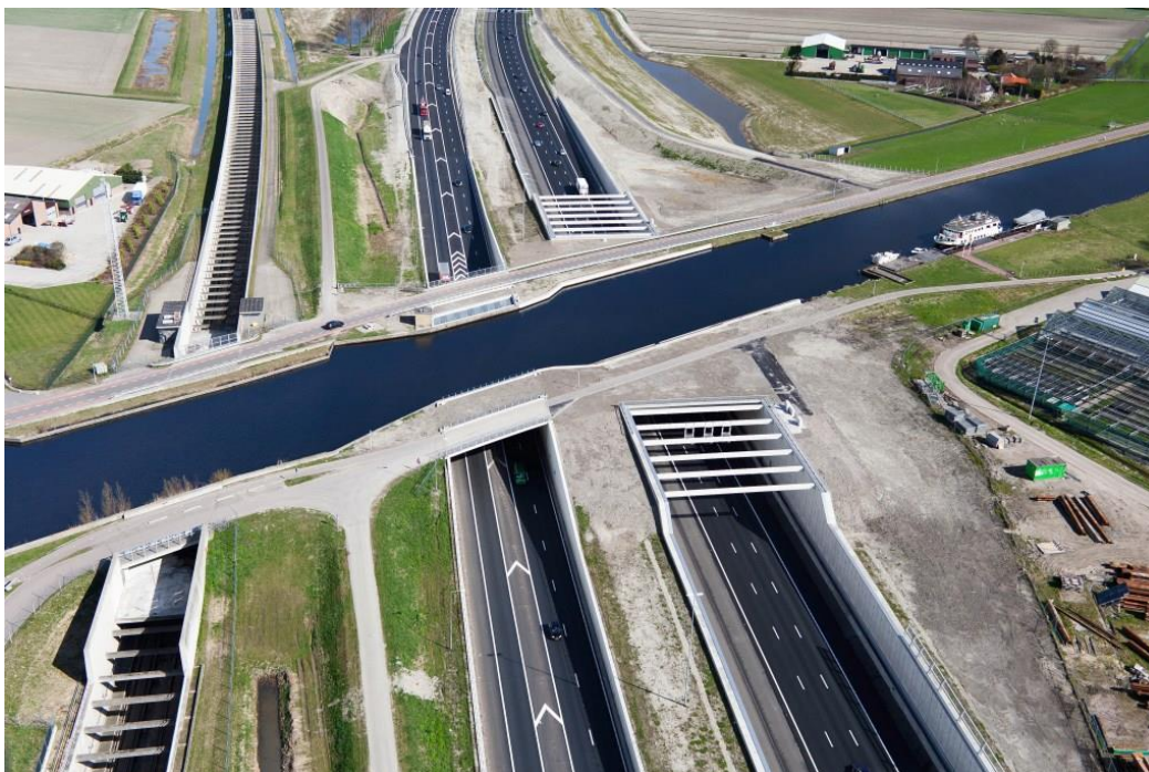
Figuur 1: Ringvaartaquaduct in de A4 bij Leiden, van L naar R: spooraquaduct (2004), oude aquaduct (1959) en nieuw aquaduct (2010)
