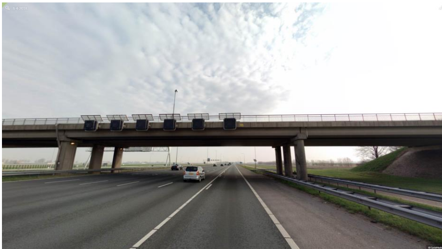
Afbeelding 2: Viaducten Venneperweg in HRL
