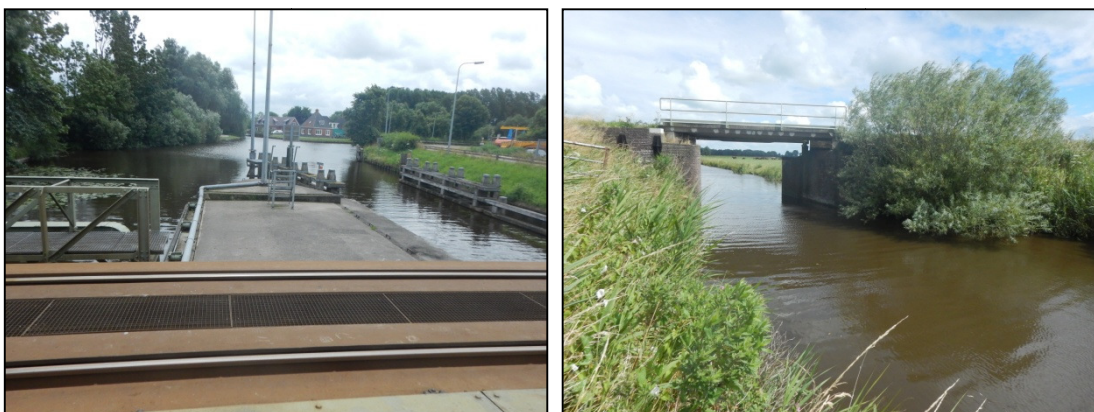
Figuur 12. Spoorbrug over het Hoendiep bij Hoogkerk (links) en ter hoogte van de spoorbrug bij de Zuidwending (rechts).
