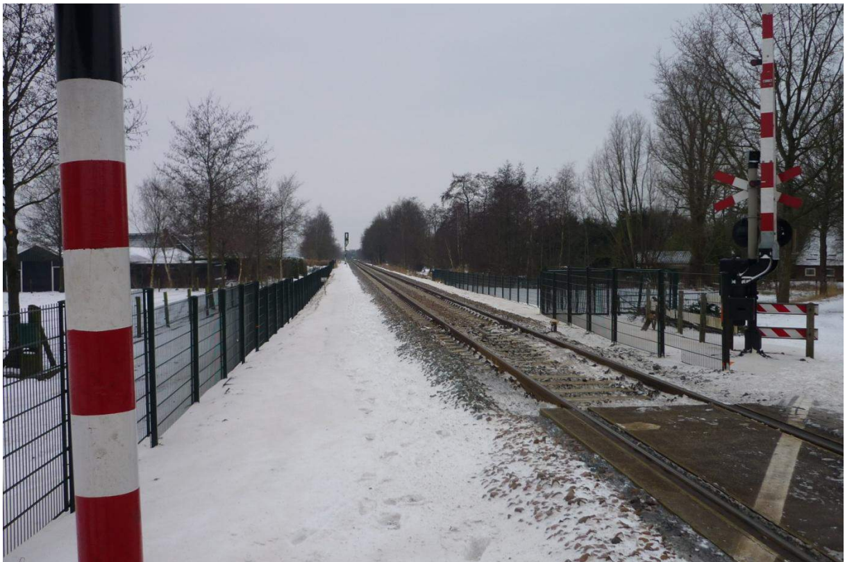
Tystjerk – overgang (foto in westelijke richting)
