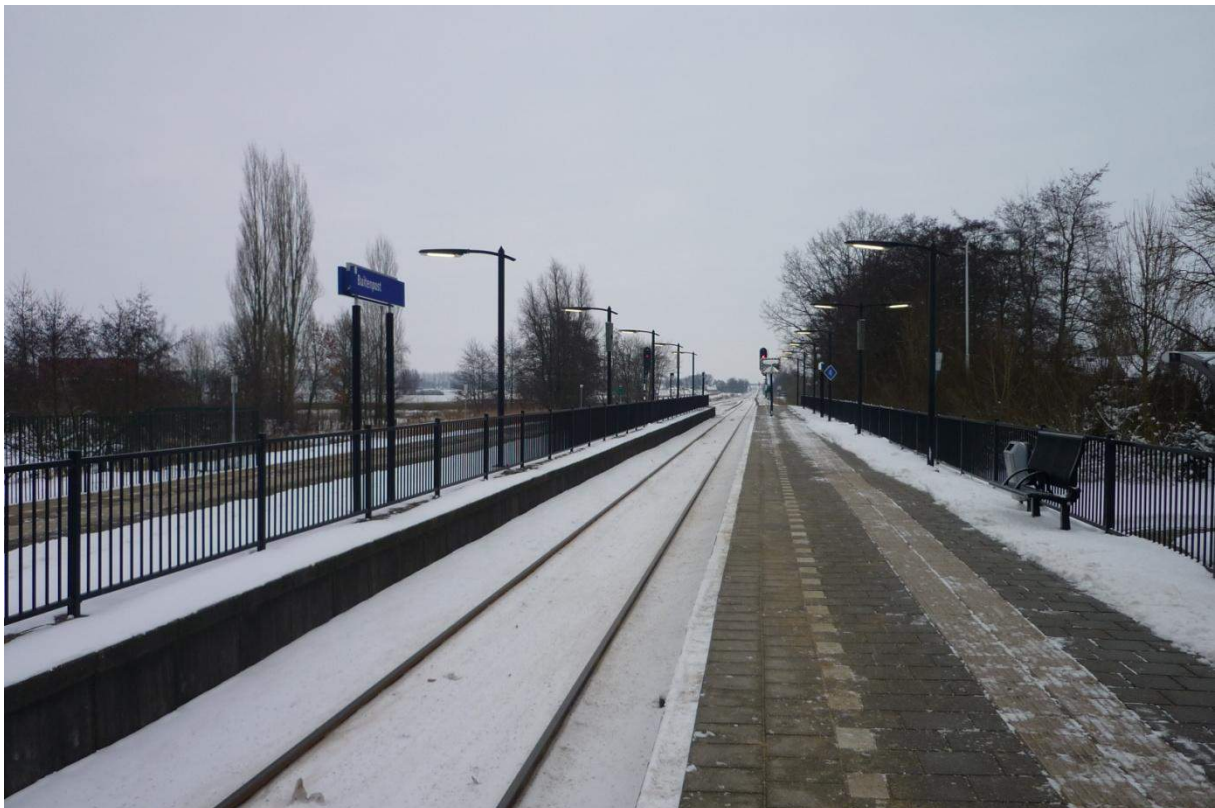
Buitenpost – station (foto in oostelijke richting)
