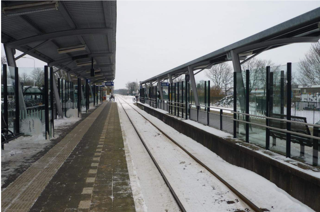
Buitenpost – station (foto in westelijke richting)
