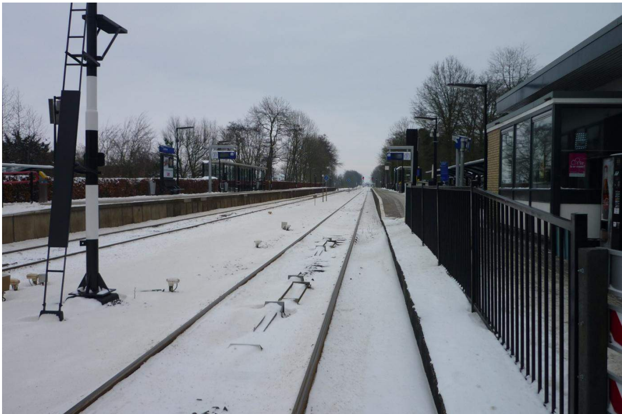
Zuidhorn – station (foto in oostelijke richting)
