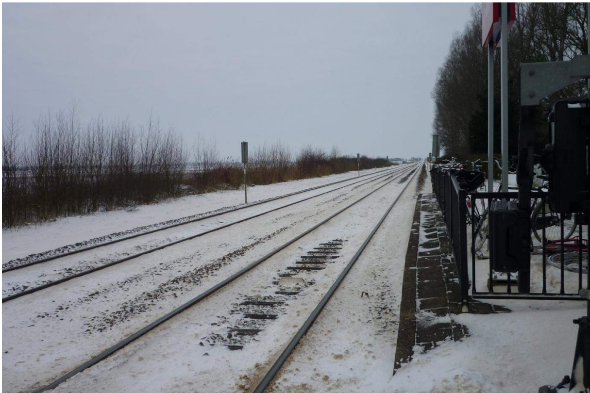
Grijpskerk – station (foto in westelijke richting)
