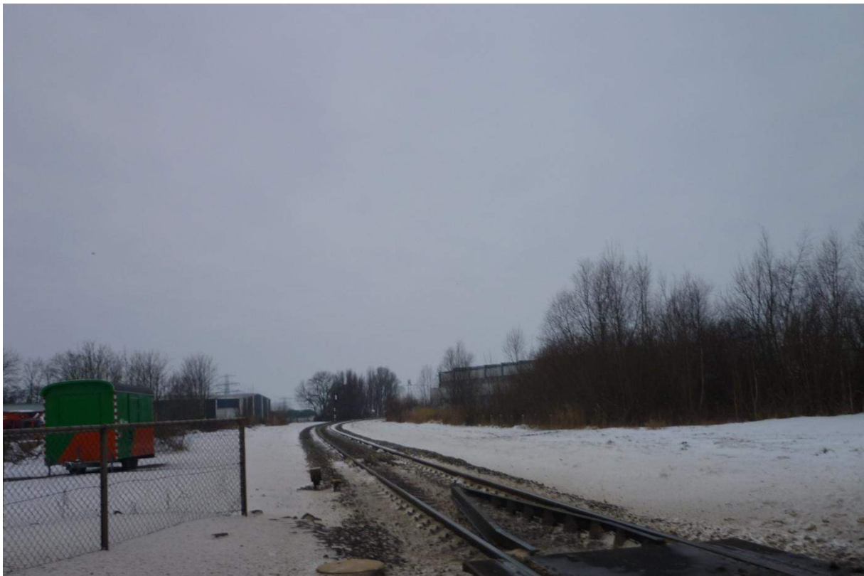
Hoogkerk – overgang richting Vierverlaten (foto in westelijke richting)
