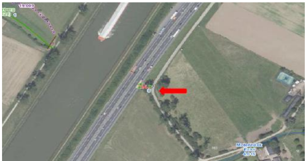
Figuur 2-24 De A2 en de Bellekeweg (dijk) sluiten niet op elkaar aan (noodplan Aasterberg)
