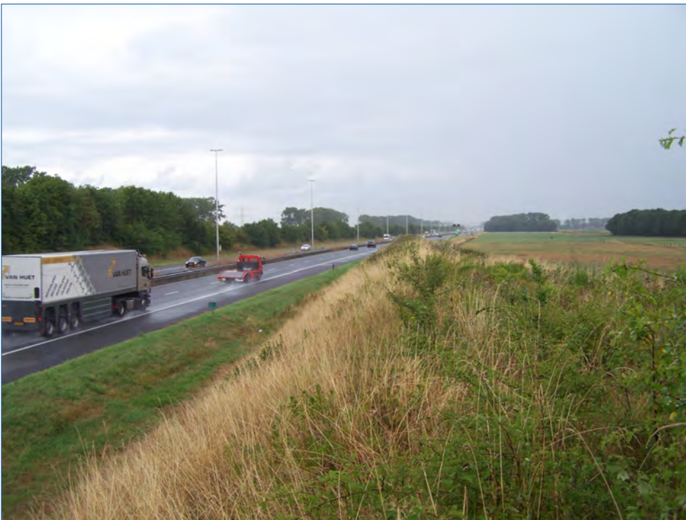
Figuur 16. Het talud van de voormalige oprit waarop pechhaven 13 grotendeels gepland is.
