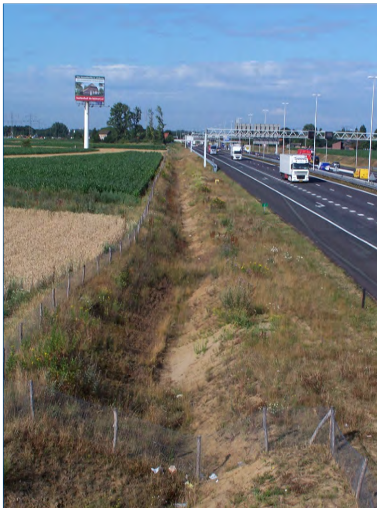
Figuur 13. De geplande locatie van de vluchtstrook is reeds grotendeels verstoord door de aanwezigheid van een sloot.
