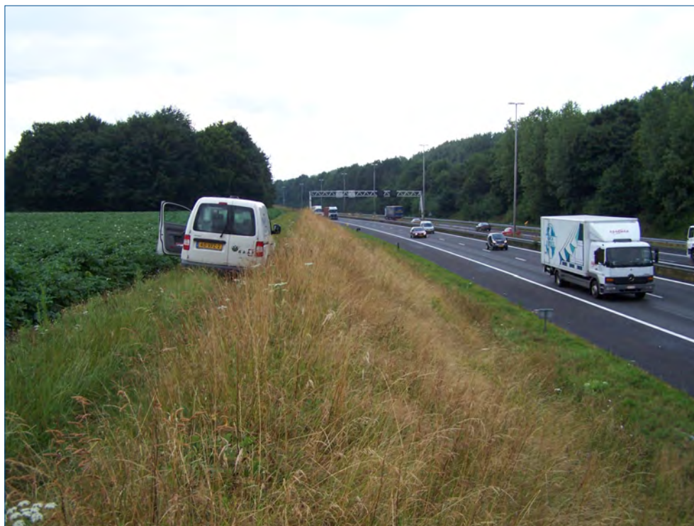
Figuur 18. Het steile talud ontstaan door de ingraving van de A2 ter plaatse van pechhaven 3.
