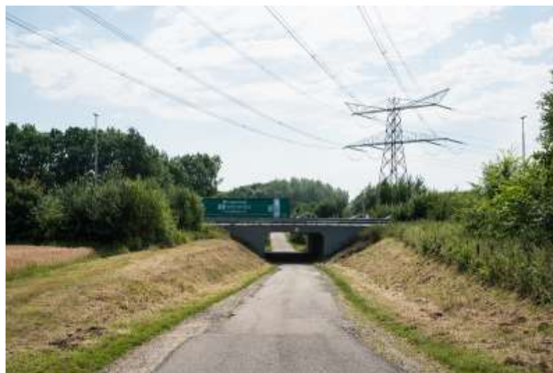
Huidige onderdoorgang Den Uil
