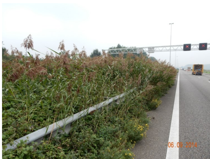
Figuur 4: Groen-/bermbeheer: riet in de middenberm
