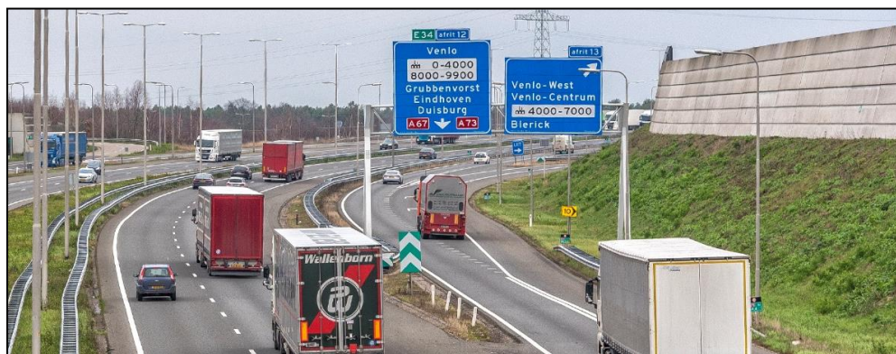
Figuur 3. De huidige situatie ter hoogte van afslag 13 Venlo- West.
