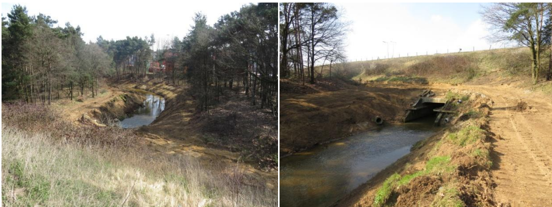
Foto 4 en 5: De situatie rond de kruising van de Everlose beek en de huidige parallelbaan, met op foto 4 de beek gezien vanaf het talud van de A73 en op foto 5 de monding van de duiker die onder de A73 ligt (foto's A&W 2016).
