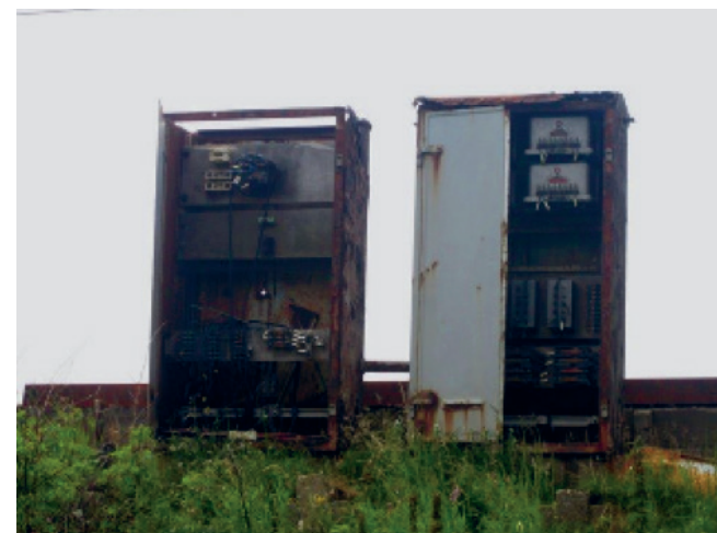
Afgedankte meterkasten met hoge concentraties polychloorbifenylen (PCB's)
