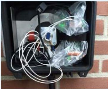
figuur 4: het funderingsmeetpunt
