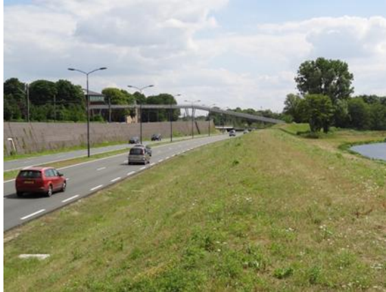
Foto 24: Spoor, randweg en afwateringskanaal
