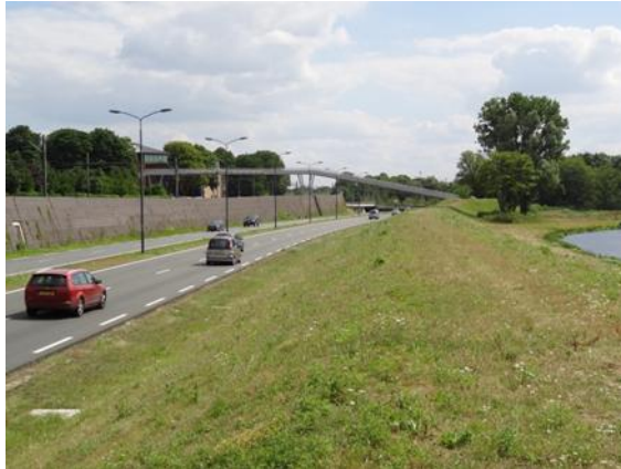
Foto 23: Spoor, randweg en afwateringskanaal
