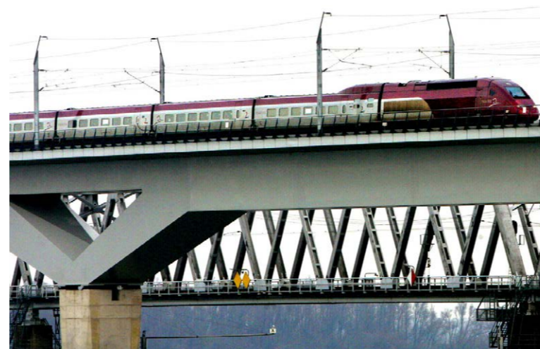
REFERENTIE STALEN TROGBRUG MET DEK OP TROG (HSL HOLLANDS DIEP) (LINKS). SPANNEND LIJNENSPEL EN STRAKKE VORMGEVING
