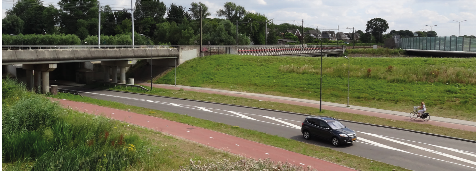
SPOORBRUGGEN OVER VLIJMENSEWEG EN DRONGELENS KANAAL
