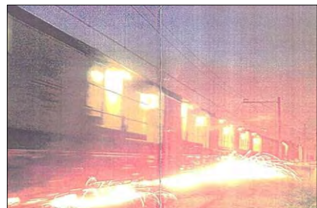
Figuur: Het bijslijpen van spoorstaven.
