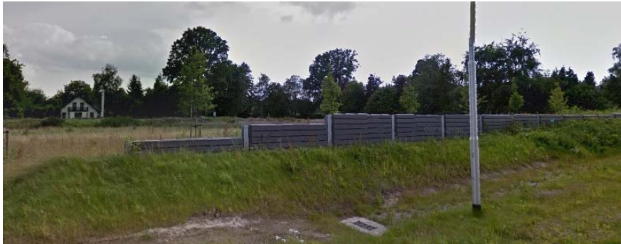
Figuur 6.15 Geluidwering type Combiplan met een getrapte opbouw aan begin en eind
