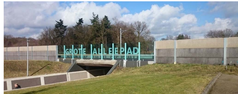
Figuur 6.14 Geluidwering type Combiplan
