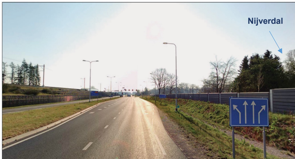
De N35 loopt door Nijverdal. Aan de zuidzijde staan betonnen geluidschermen in de vormgeving van het Combiplan (beton in drie aarde kleuren).
