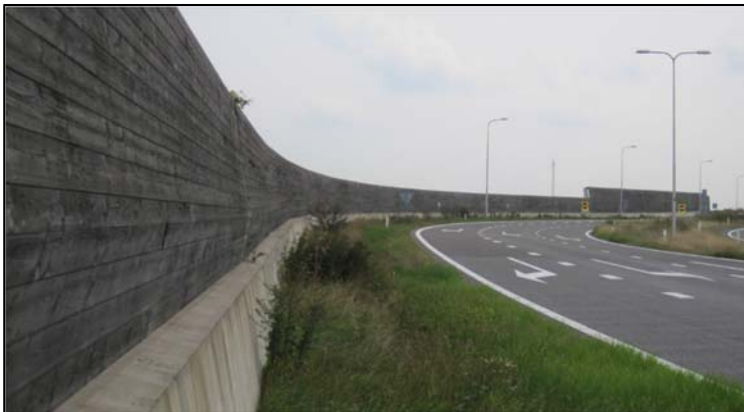
Figuur 5.4 De bestaande geluidschermen bij Wierden.
