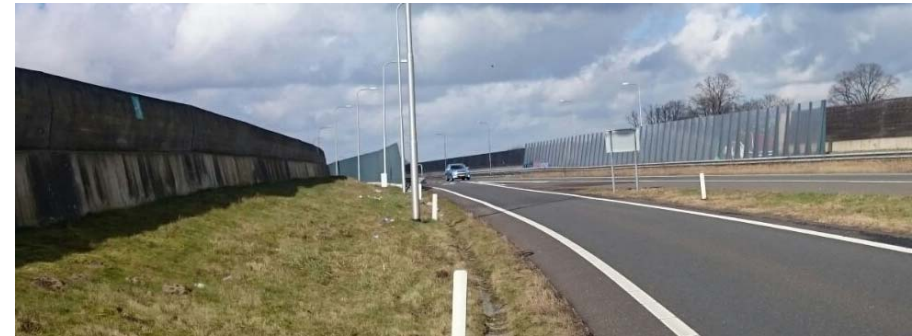
Figuur 6.13 Geluidwering type N35 uitgevoerd in betonnen plint met houten opbouw en transparant deel bij viaduct
