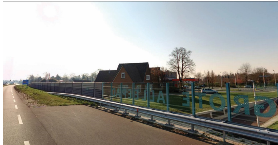
Ter plaatse van de fietstunnel, wordt het geluidscherm onderbroken door een transparant scherm van het Combiplan. De titel 'Grote Alleepad' verwijst naar het fietspad.
