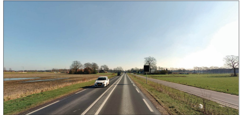
Op enkele plaatsen worden de parallelweg en de provinciale weg gescheiden door een lage haag. Richting Wierden wordt de ruimte tussen weg en spoor kleiner.
