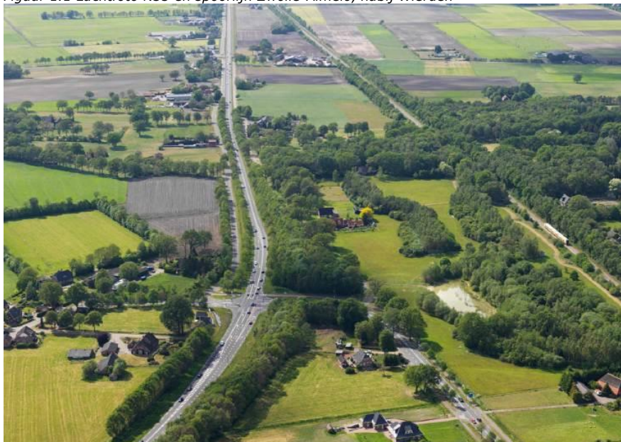
Figuur 1.1 Luchtfoto N35 en spoorlijn Zwolle-Almelo, nabij Wierden
