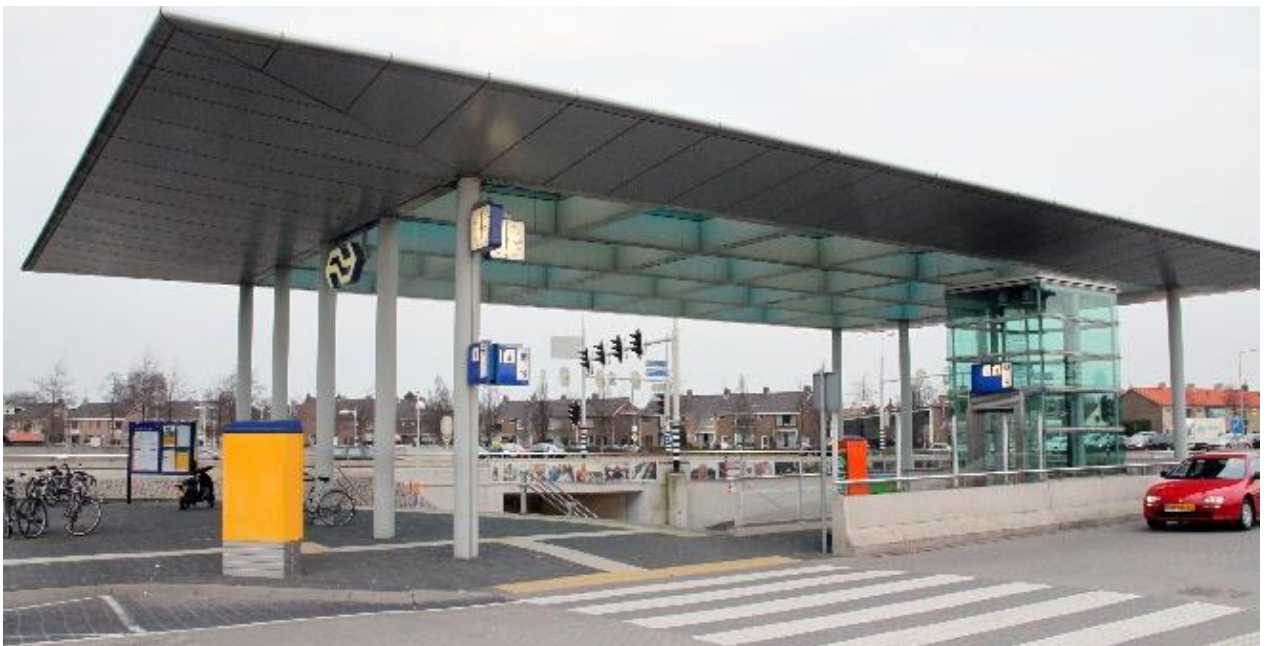
Figuur 4-10: Luifel van het huidige station Uitgeest
