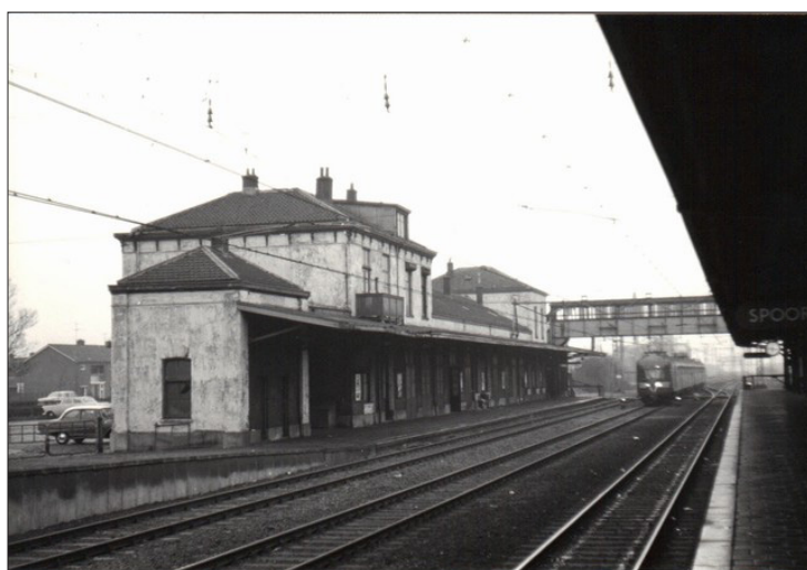
Afbeelding 7: Het oude stationsgebouw van Uitgeest. Duidelijk te zien is de luchtbrug, op de achtergrond. Bron: Peter Collet.
