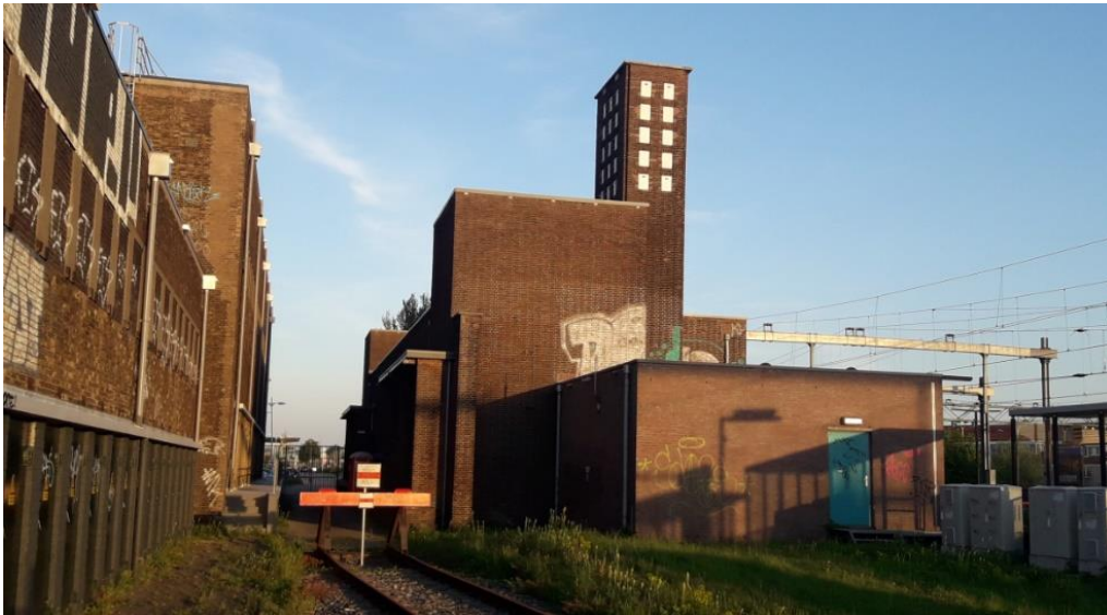
Figuur 4-32 Onderstation (gebouw met toren rechts op de foto) aan het stationsplein bij station Uitgeest dat mogelijk gesloopt gaat worden. Het gebouw links op de foto is een elektriciteitsverdeelstation van Liander dat ook in het onderzoek is meegenomen.
