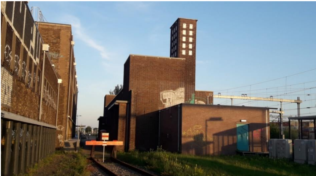
Figuur 3-5 Onderstation (gebouw met toren rechts op de foto) aan het stationsplein bij station Uitgeest dat mogelijk gesloopt gaat worden. Het gebouw links op de foto is een elektriciteitsverdeelstation van Liander dat ook in het onderzoek is meegenomen.
