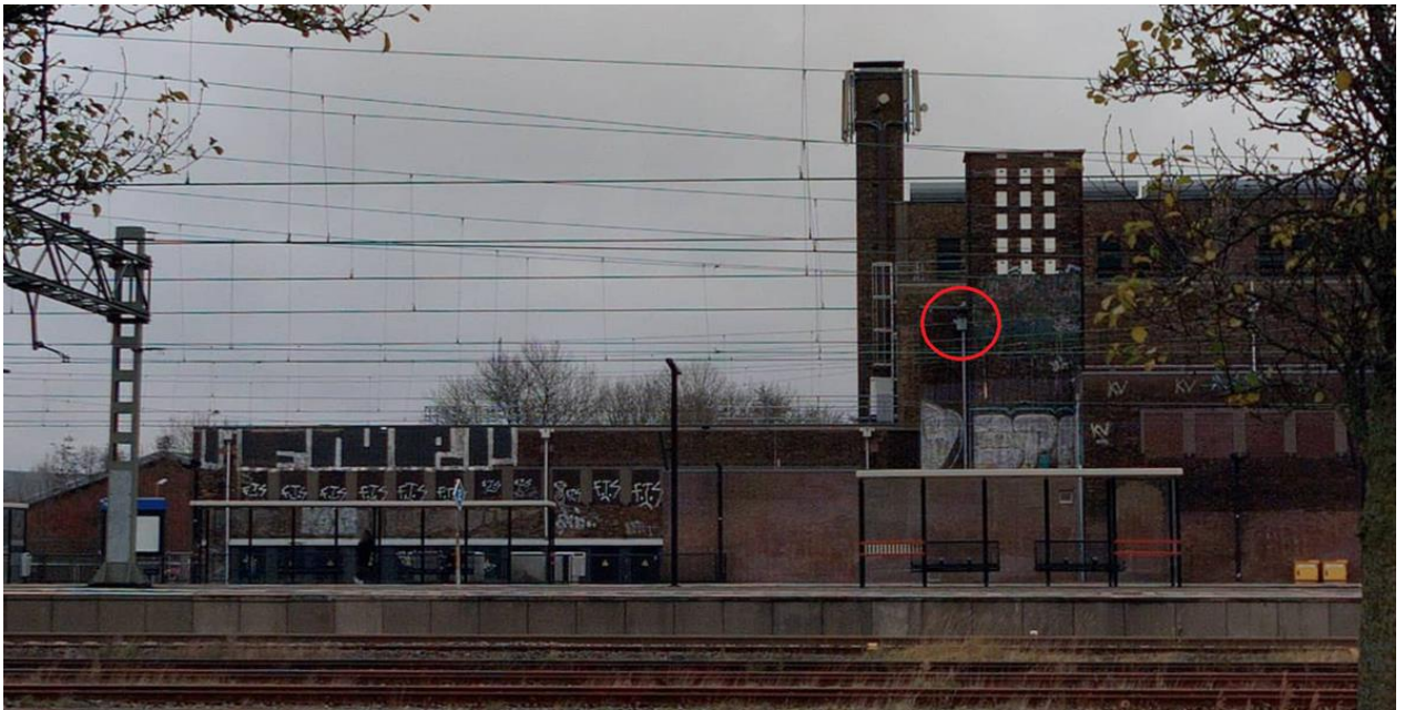
Figuur 4-33 Locatie vastgestelde kraamverblijfplaats laatvlieger achter vergaarbak van een regenpijp in onderstation Uitgeest op 25 juni 2020.
