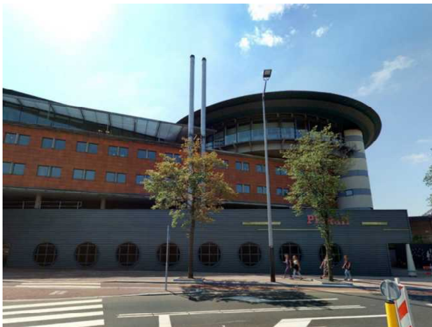
Figuur 297 Gevel De Ruijterkade 4
