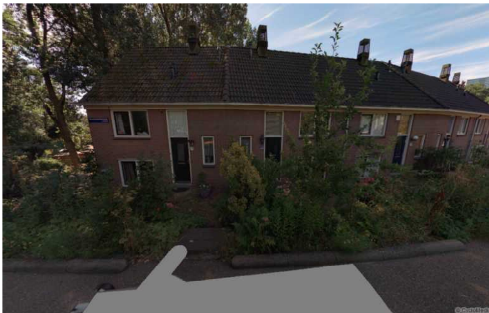
Figuur 342 Gevel Spaarndammerdijk 579
