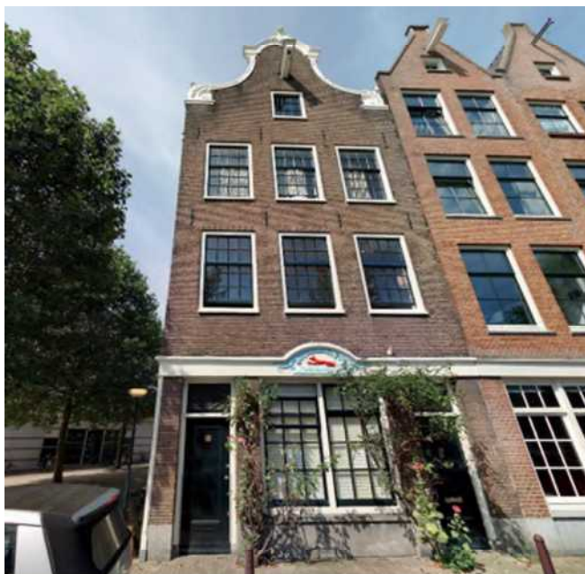
Figuur 302 Gevel Nieuwe Teertuinen 24-3
