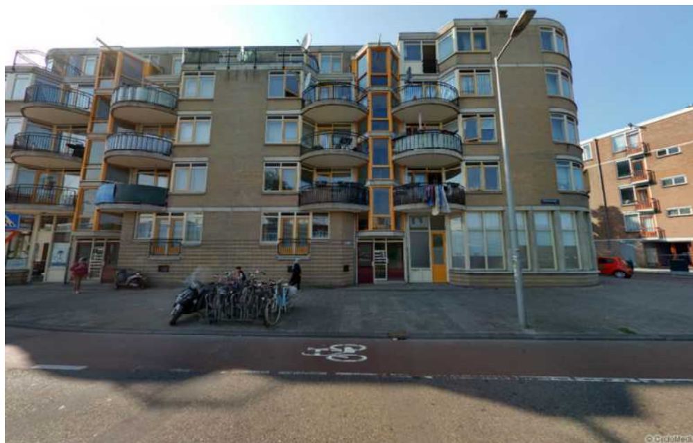
Figuur 172 Gevel Pontanusstraat 258
