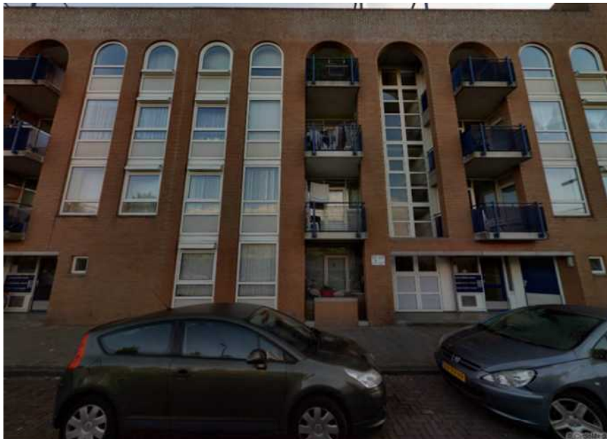
Figuur 202 Gevel Celebesstraat 26E
