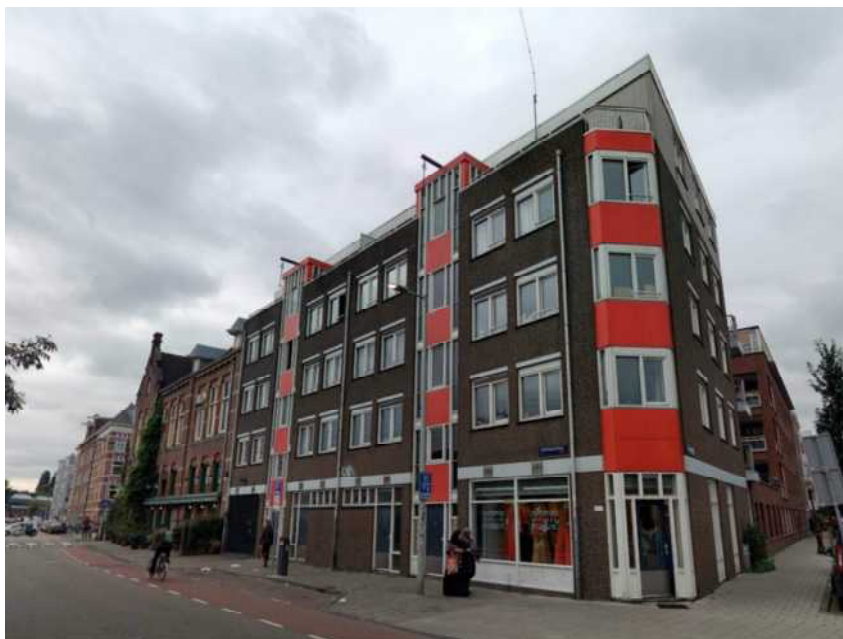
Figuur 192 Gevel Pontanusstraat 188
