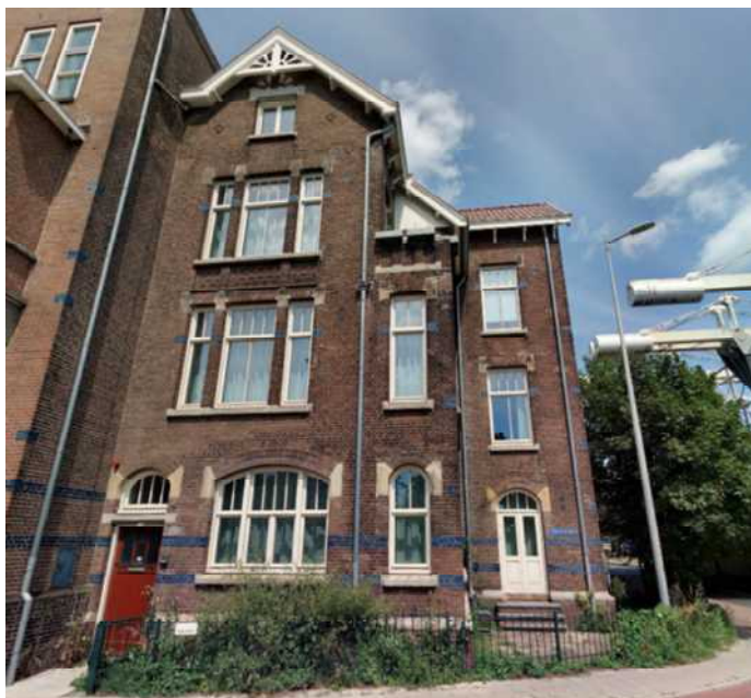
Figuur 322 Gevel Houtmankade 332
