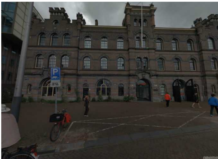
Figuur 267 Gevel De Ruijterkade 149
