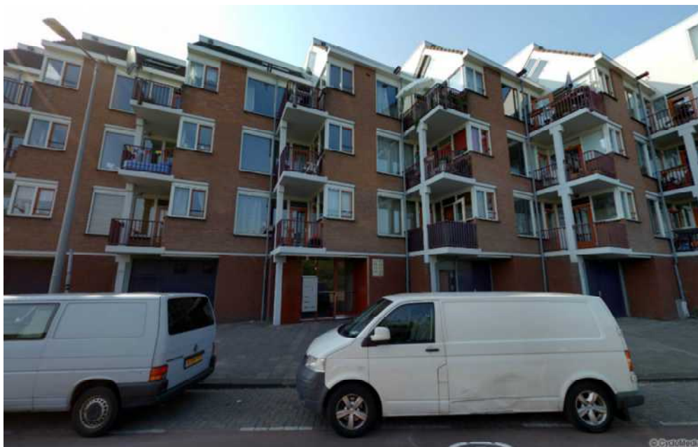
Figuur 177 Gevel Pontanusstraat 247
