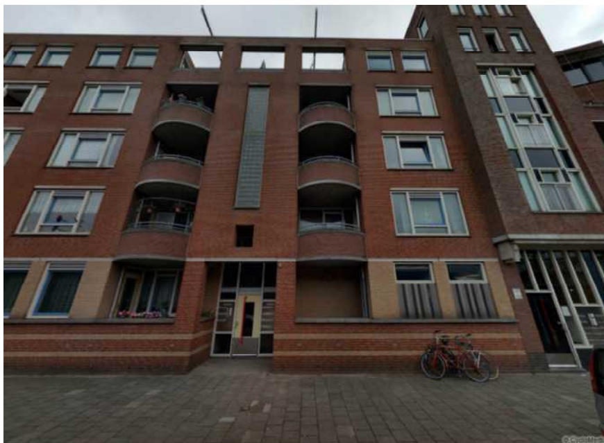
Figuur 137 Gevel Tugelaweg 150
