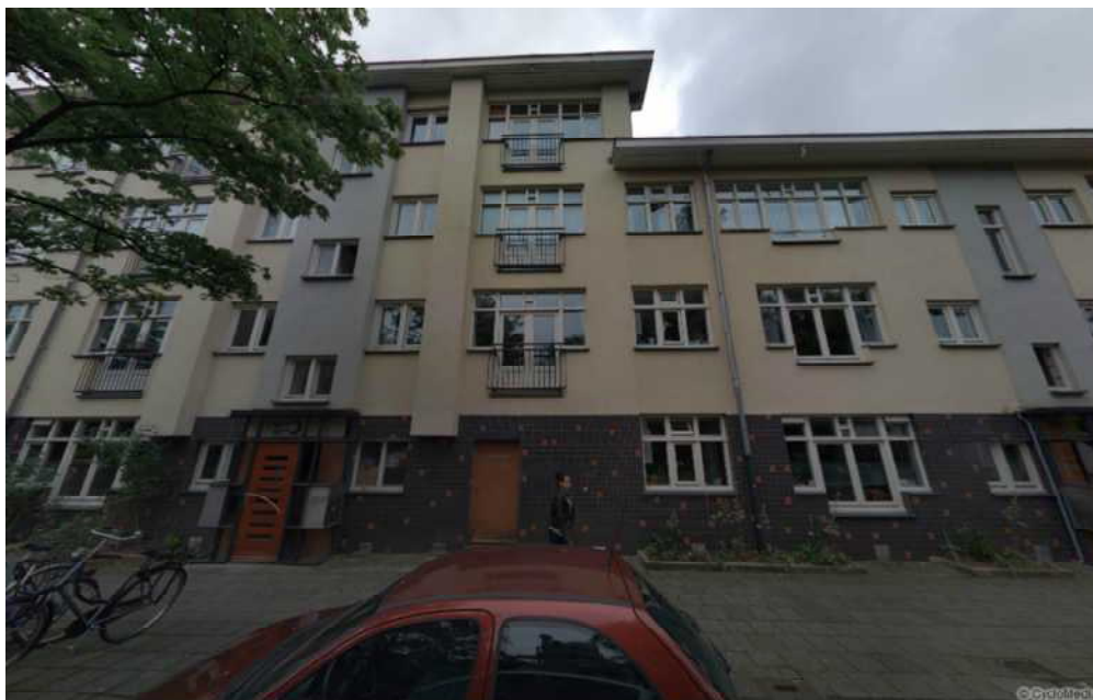
Figuur 147 Gevel Tugelaweg 118C
