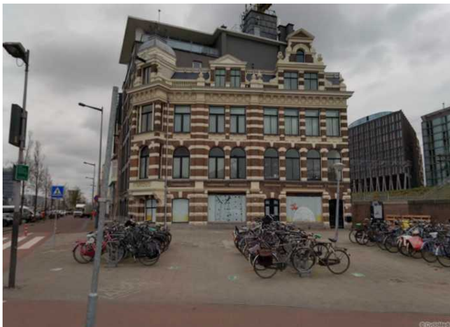
Figuur 277 Gevel De Ruijterkade 105
