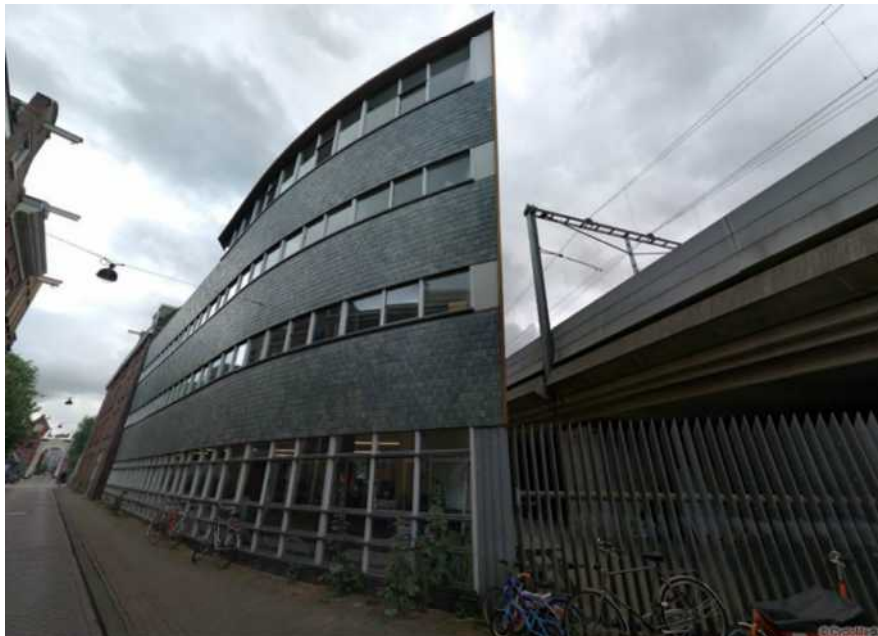
Figuur 307 Gevel Nieuwe Teertuinen 25C
