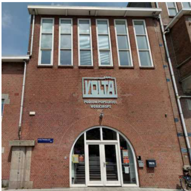
Figuur 327 Gevel Houtmankade 336
