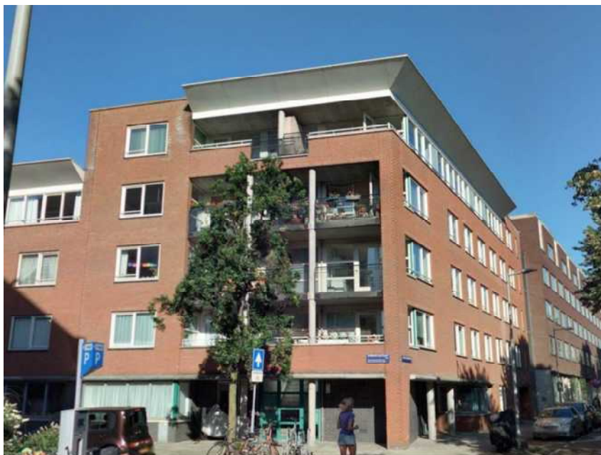
Figuur 127 Gevel Overamstelstraat 103
