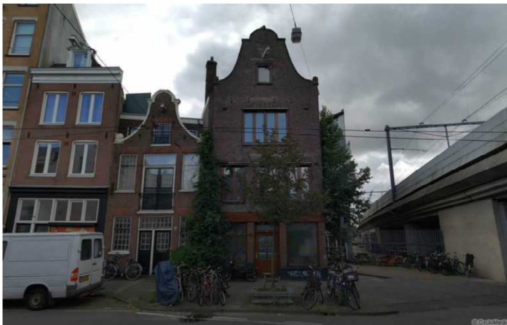
Figuur 312 Gevel Planciusstraat 77
