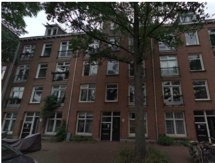
Figuur 332 Gevel Spaarndammerstraat 12D
