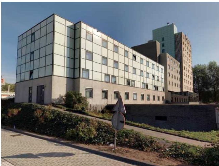
Figuur 112 Gevel Verlengde van Marwijk Kooystraat 30
