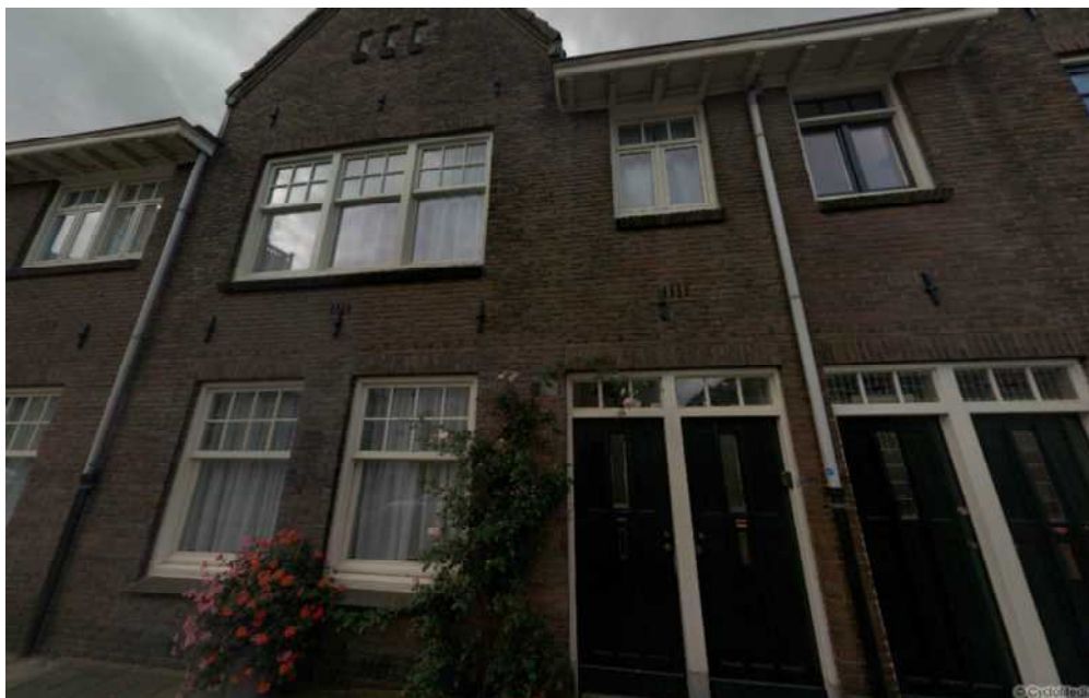
Figuur 317 Gevel Schiemanstraat 1
