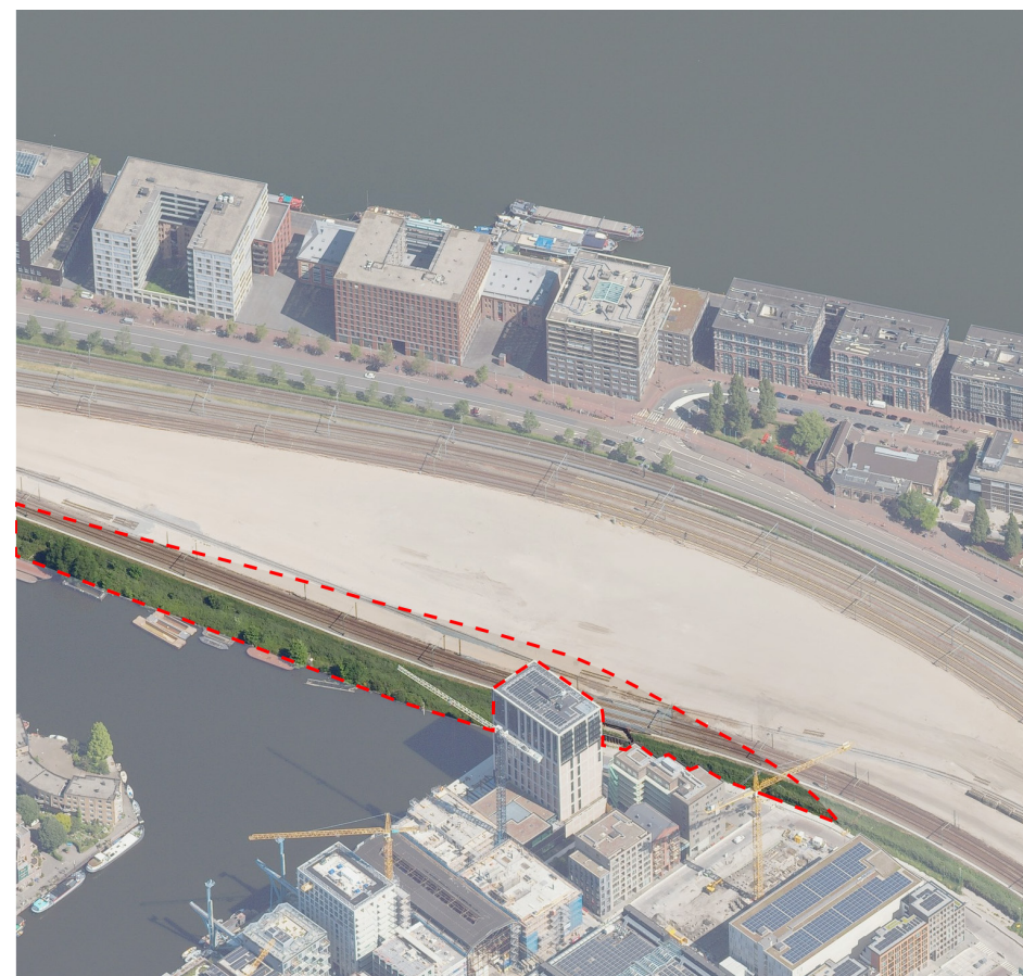
Locatie relaishuis 3, Dijksgracht zone (Bron: Cyclomedia)
