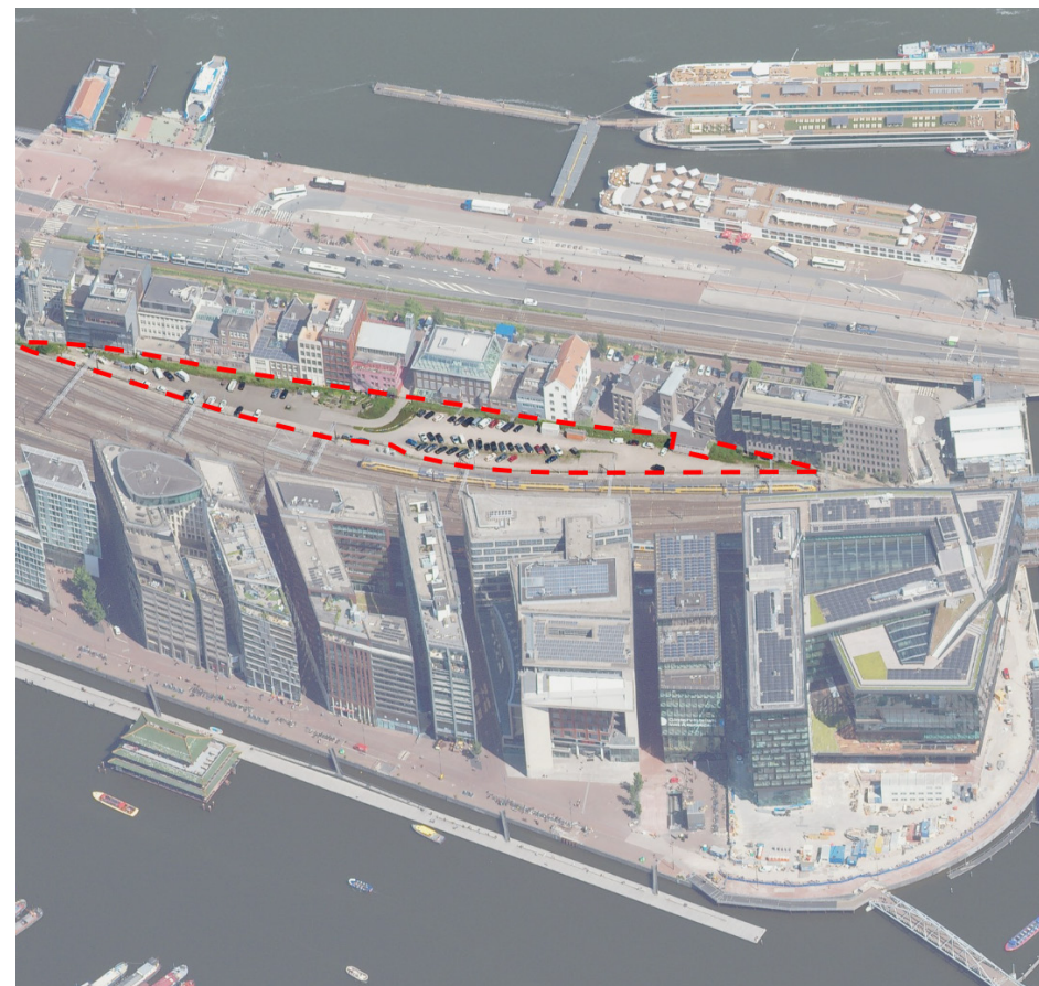
Locatie relaishuis 2, Oostelijk eiland (Bron: Cyclomedia)
