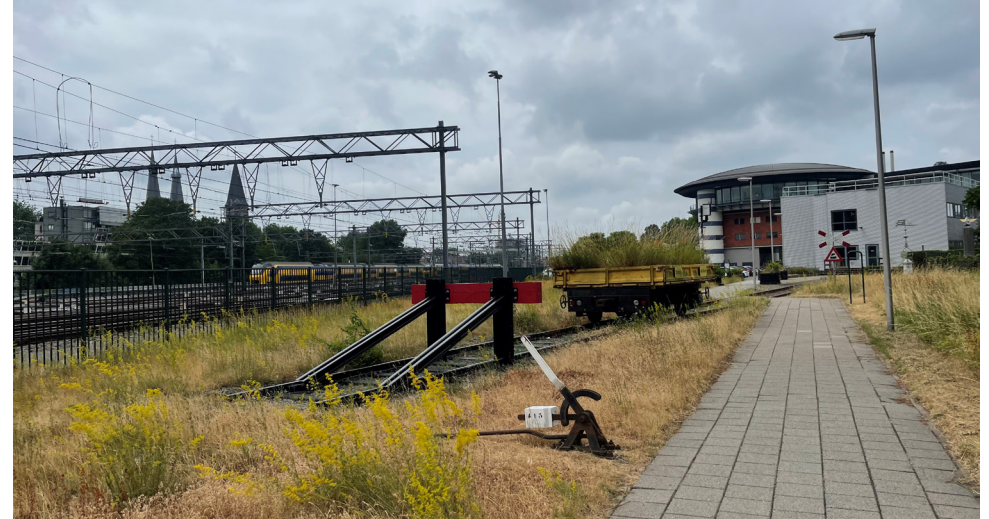
Afbeelding oostelijk punt VLTC terrein
