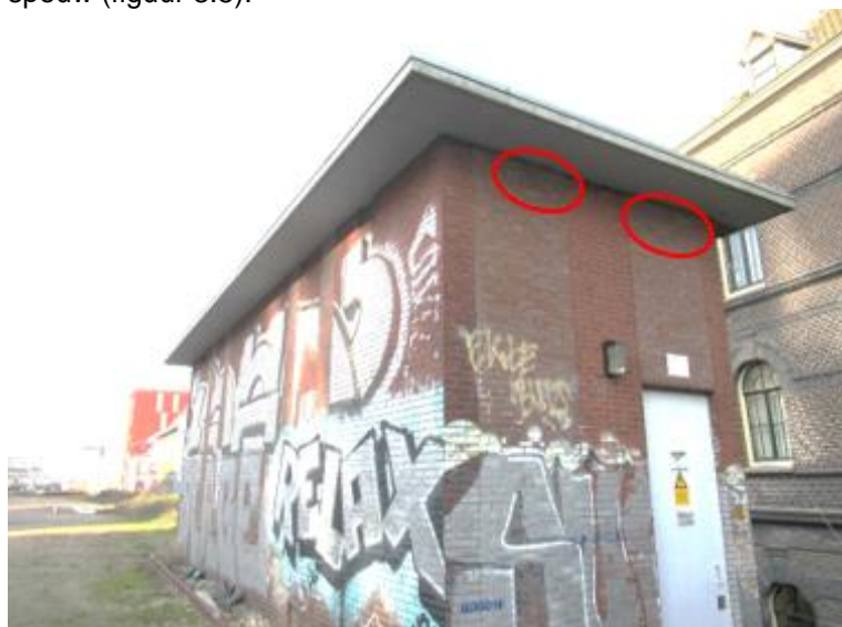
Figuur 3.5: Elektriciteitshuisje naast locatie 2 met onder de dakrand ventilatiegaten (rood omcirkeld).
