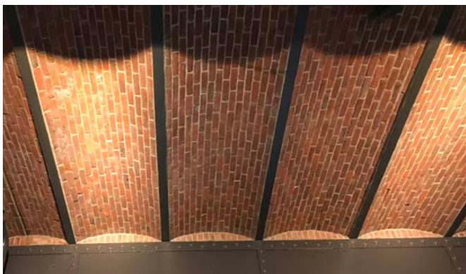
Troggewelven van de erker boven de entree poortvrije passage
