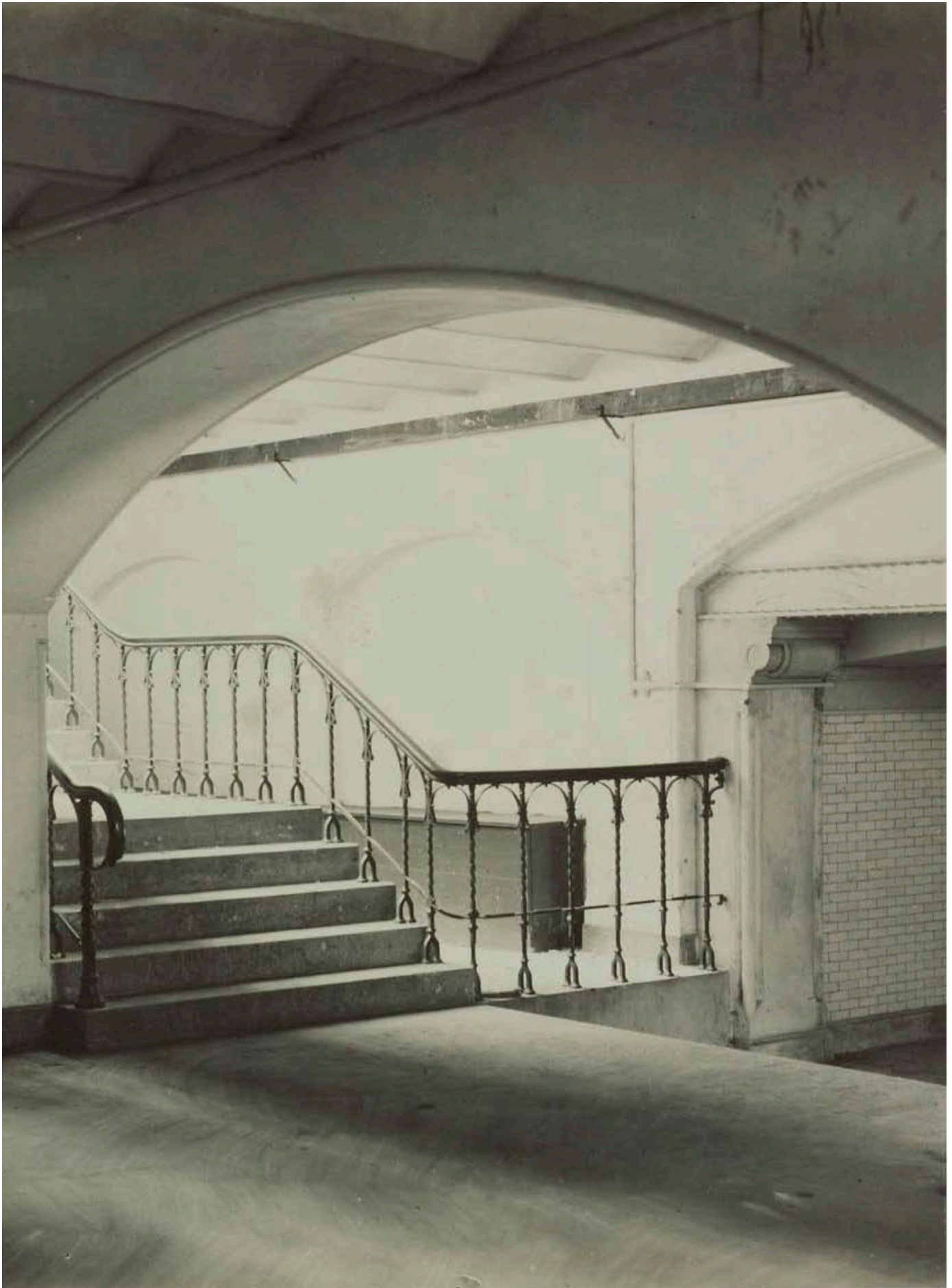
Overgang tussen het Cuypersgebouw en de Middentunnel met de trap naar perron 1, 1889.
