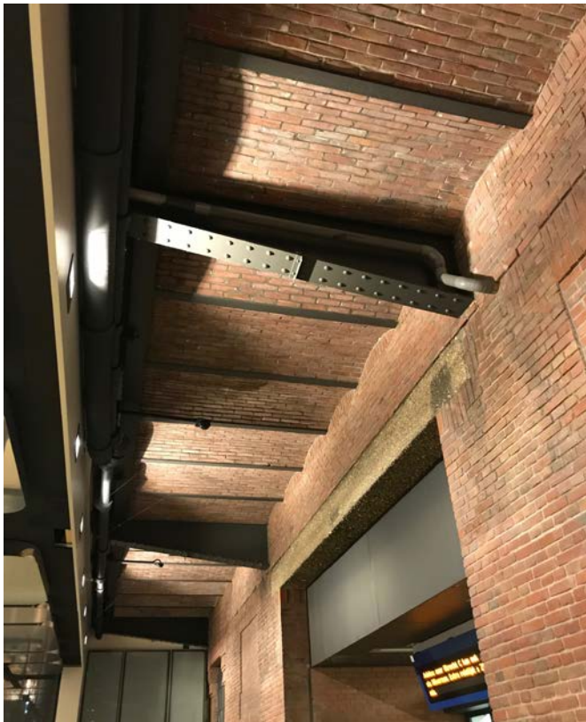
Gemetselde gevel (noordzijde) van de Oosttunnel
