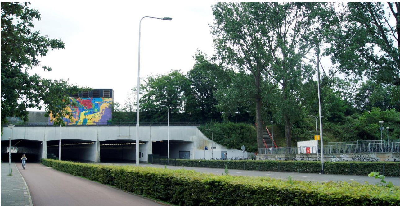
Figuur 4-26: Huidige situatie visueel-ruimtelijk karakter ter hoogte van de nieuwe westentree
