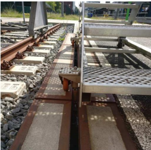
Foto 1: Voorbeeld verholen goot icm verrijdbare trap
