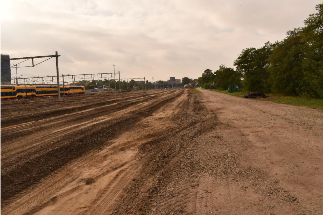
Figuur 4-4. Locatie van het oude spoorwegemplacement waar op het moment van het veldbezoek de rails, bielzen en ballast waren verwijderd. In het kader van een bovenbouwvernieuwingsproject zijn de sporen hier gesaneerd. Het project PHS Nijmegen zal hier nieuwe opstelsporen realiseren. Tot die tijd worden de gronden ingezaaid zodat er geen zandvlakte ontstaat.
