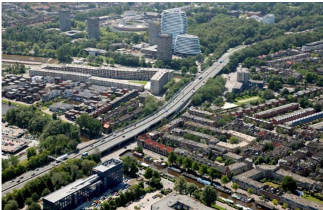
Luchtfoto bestaande situatie A7 bij Oosterpoort: Barrièrewerking van de weg in de stedelijke structuur; bron: Aerophoto Eelde
