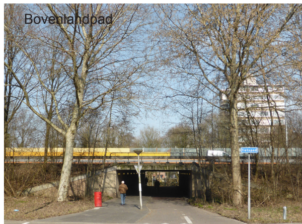
Tussen het Meanderpark en het voormalige KPMGgebouw ligt het Bovenlandpad, een langzaamverkeerverbinding onder de A9 tussen noord en zuid Amstelveen.
