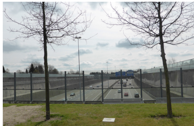
5.19. Doorzichten naar de snelweg vanaf het Bovenlandpad (referentie Prinsenbeek park, Breda)
