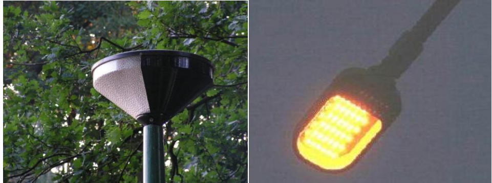
Afbeelding 5.17. Voorbeelden van afscherming van verlichting (links) en amberkleurige LED-verlichting (rechts) om verstoring van vleermuizen door verlichting te voorkomen
