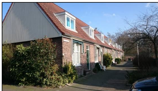
Afbeelding 10: Bebouwing met houtconstructies
