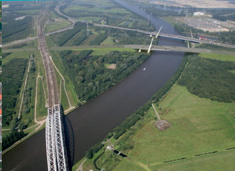
De bypass, een nieuwe brug over het Amsterdam-Rijnkanaal tussen de spoorbrug en de bestaande brug in de A1.
