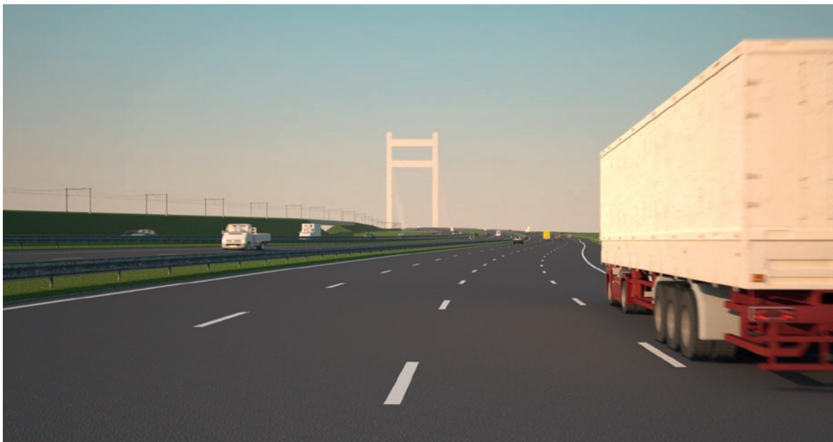
De Tweede Hollandse Brug als belangrijke landmark.
