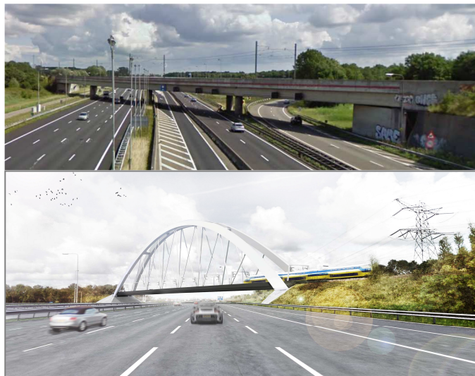
Figuur 1 Zicht op de betonnen spoorbrug vanuit de bestaande A1 (boven) en een impressie van de toekomstige stalen-betonnen spoorbrug over de A1 (onder).
