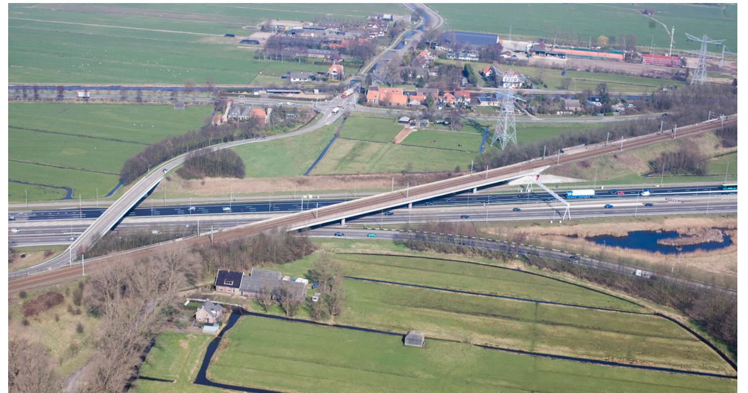
figuur 1.2 luchtfoto bestaande betonnen brug
