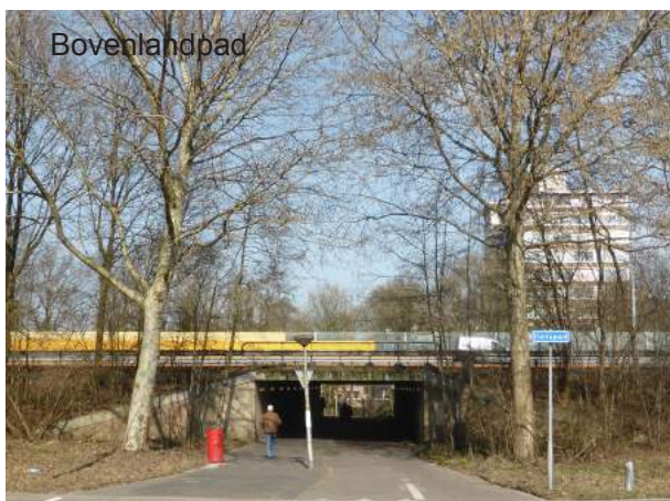
Tussen het Meanderpark en het voormalige KPMGgebouw ligt het Bovenlandpad, een langzaamverkeerverbinding onder de A9 tussen noord en zuid Amstelveen.
