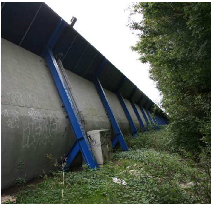
Zicht Jan Bennighweg, inclusief het bestaande geluidsscherm
