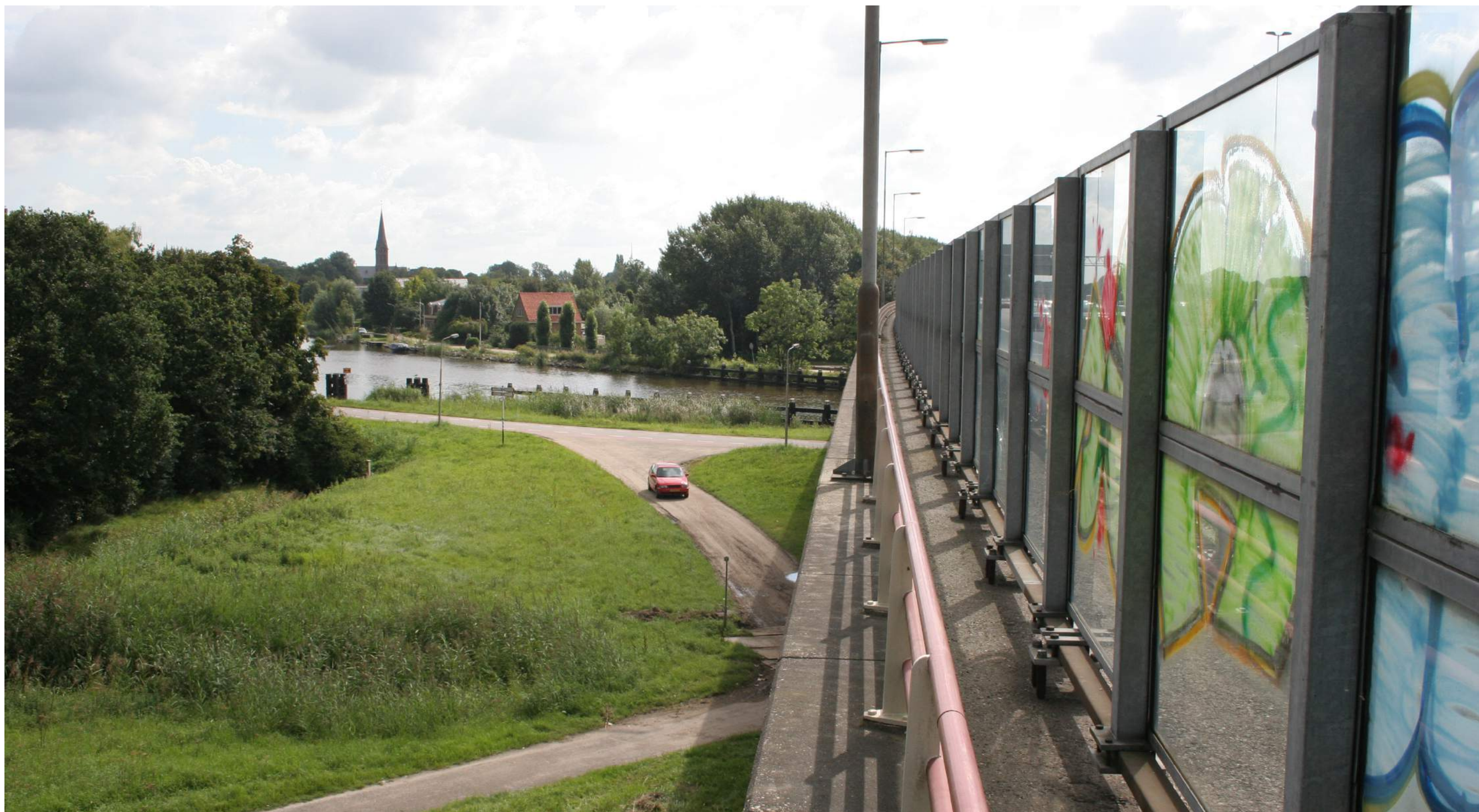
Noordzijde A9; zicht op Ouderkerk a/d Amstel
