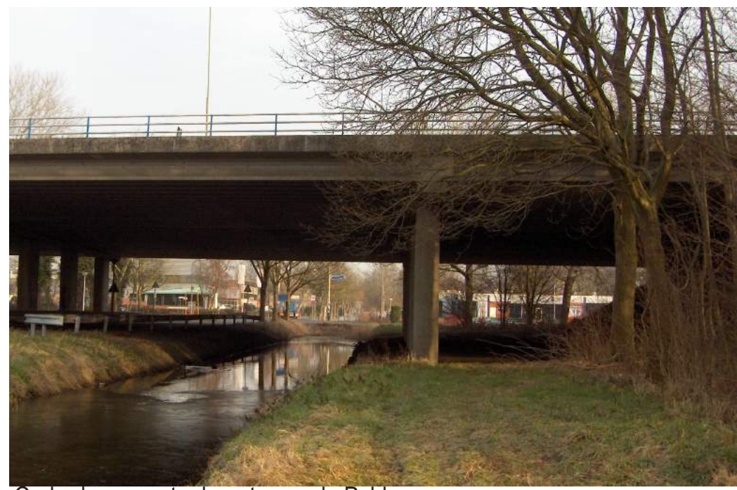
Onderdoorgang ter hoogte van de Polderweg
