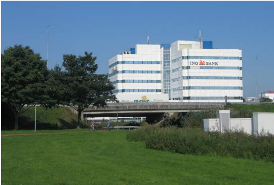
Fietspad Snijdersbergweg - Lemelerbergweg
