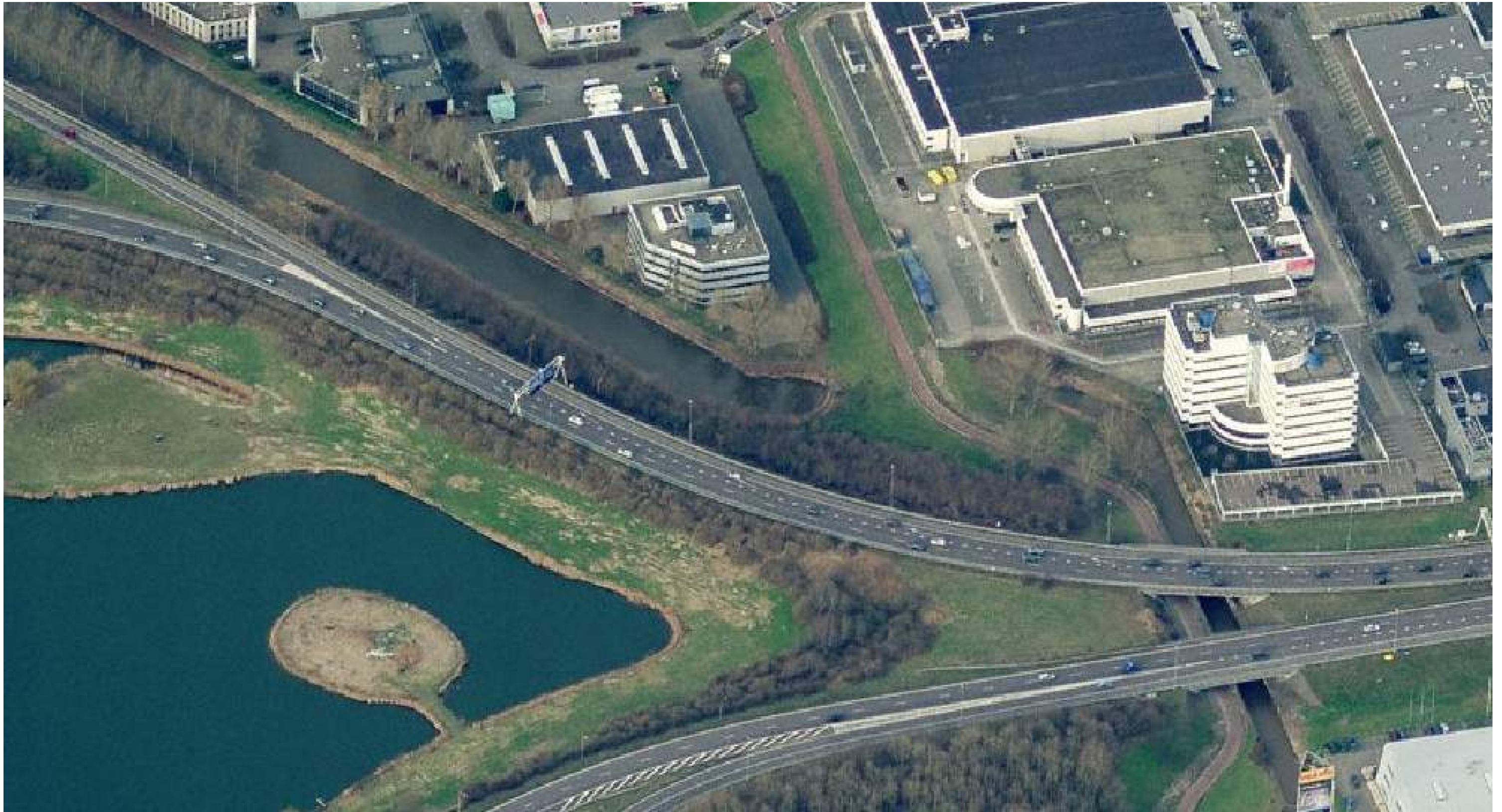
Luchtfoto aansluiting A9 / A2 en viaduct Snijdersbergweg / Lemelerbergweg
