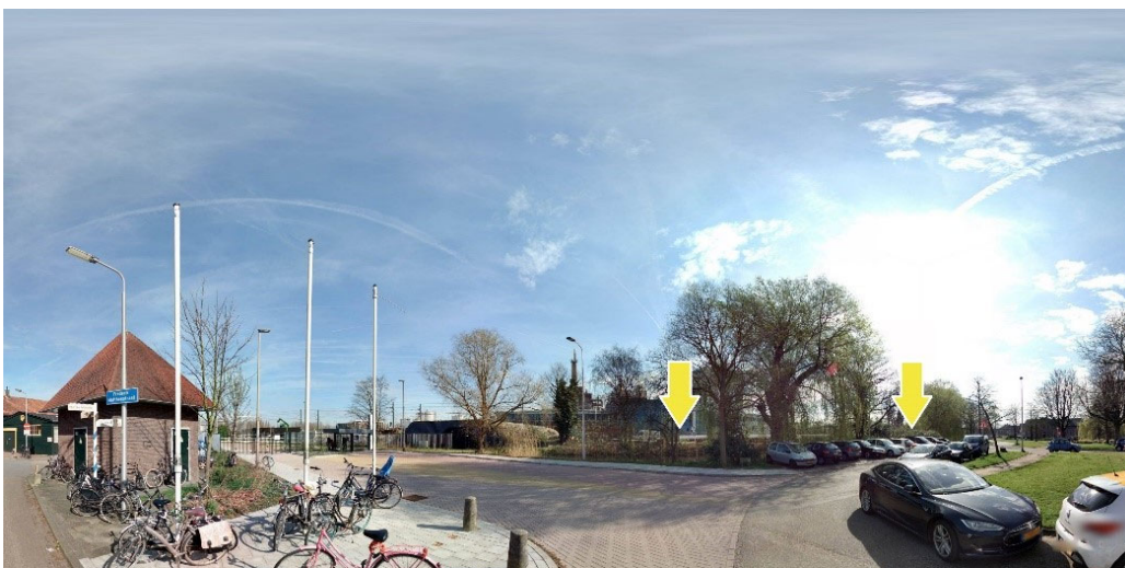
Figuur 8. Montagefoto zonder geluidsscherm, noordwestzijde Spoortunnel Delft
