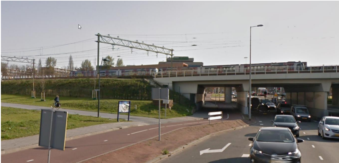
Bijlage I Figuur 3, foto spoordijk t.h.v. KM 79.3 gezien vanuit noordzijde spoor
