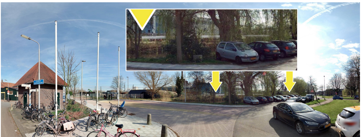
Figuur 9. Montagefoto zonder geluidsscherm, noordwestzijde Spoortunnel Delft (de pijlen in de figuren geven bij benadering het begin en het einde van het scherm aan).
