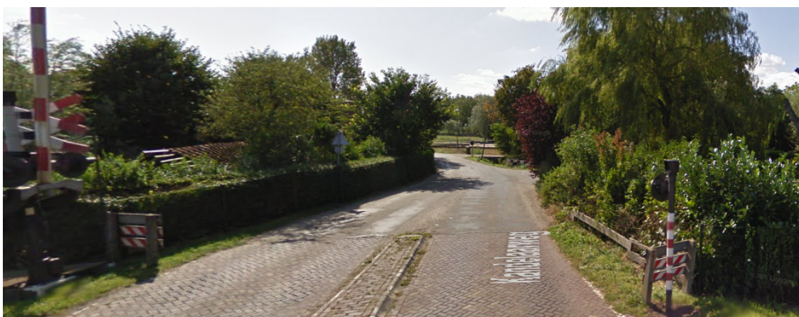
Figuur 7. Aanzicht weg en overweg richting zuiden
