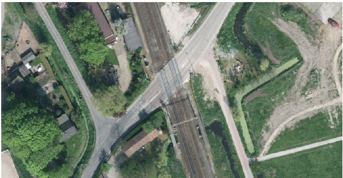
Figuur 5. Bovenaanzicht overweg Kandelaarweg
