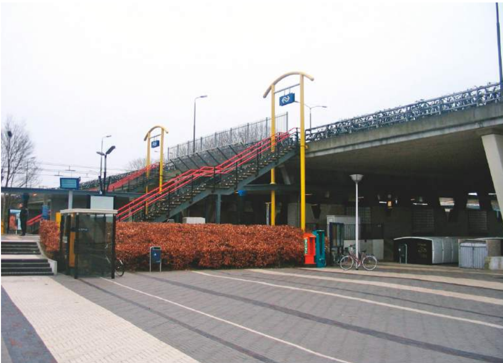
Figuur 7.1 Station Delft Zuid: perrontrappen en Kruihuisweg-viaduct vanaf maaiveld
