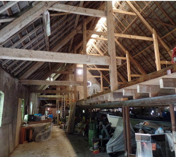
39. De schuur uit 1927 is voorzien van een betonnen vloer en een stalen inbouw met een extra vloerniveau.
