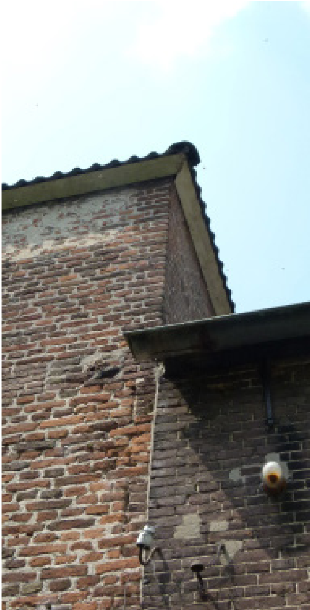
27. De aansluiting van het metselwerk van het oudste gedeelte links, het torendeel, op de 19de-eeuwse tussenvleugel van na 1883.
