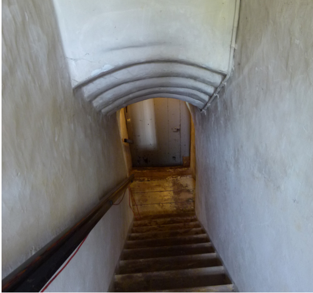
37. De trap naar de verdiepingen in het voormalige torendeel is in de dikte van de muur aangebracht. Het eerste deel is bekleed met hout, het laatste deel naar de zolder in baksteen.
