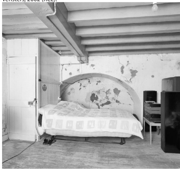
50. Het restant van de poort op de eerste verdieping, 2002 (RCE).
