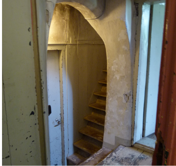
38. De trap sluit niet goed aan op het verschil in vloerniveau met de oude woonvleugel. Rechts de vloer van vijftiende-eeuwse woonvleugel.
