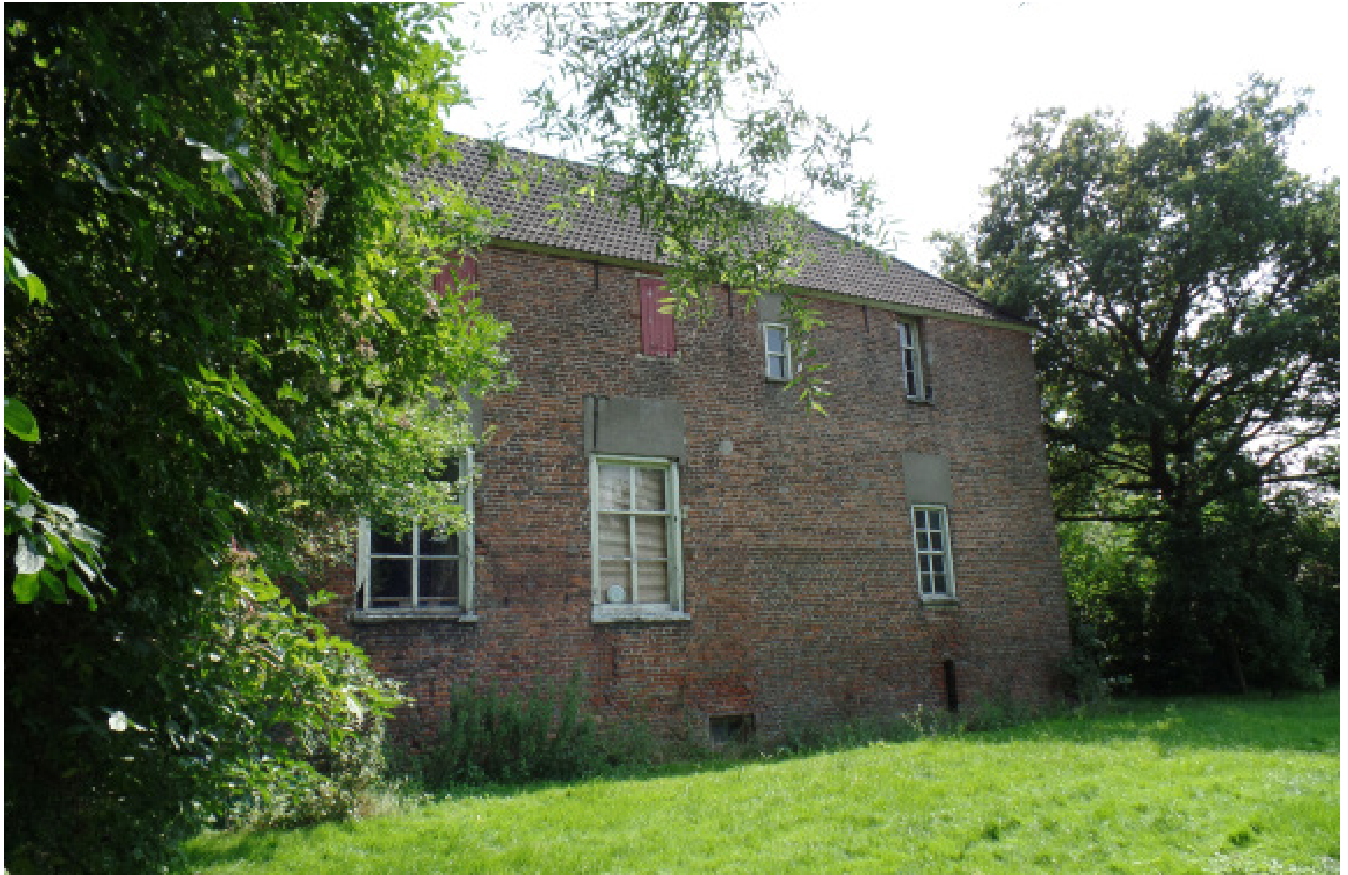
14. De noordwestelijke gevel van huis Rijswijk in juni 2014.
