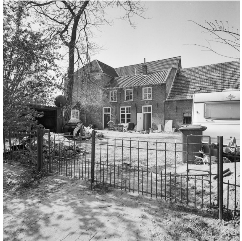
13. Huis Rijswijk gezien vanuit het zuiden in 2002 (RCE).
