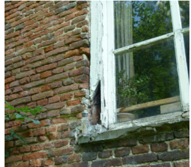
26. De aangeheelde stukken van de kozijnen in de noordgevel zijn al weer weggerot.
