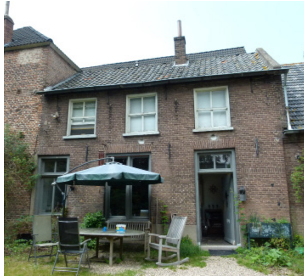
25. De tussenvleugel van na 1885 is voorzien van nieuwe kozijnen op de begane grond.
