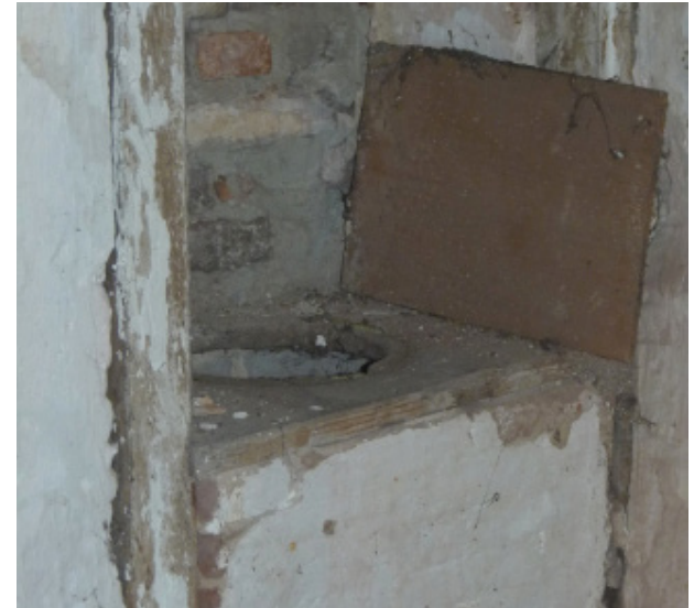
32. Het voormalige privaat in dezelfde ruimte met de dichtgezette vensters, de eerste verdieping van de vijftiende-eeuwse vleugel.
