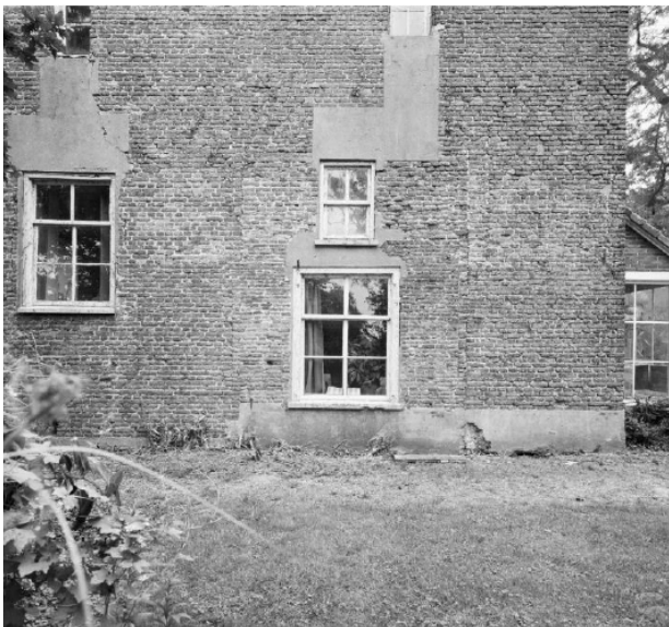
49. Zijgevel met de locatie van de poort, 2002 (RCE).
