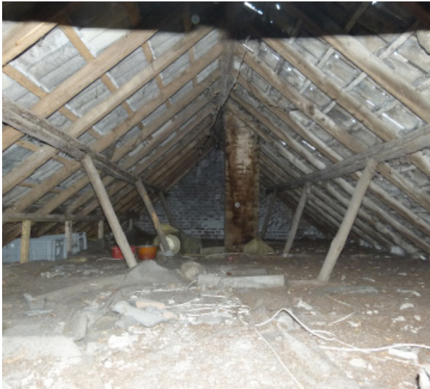
30. Zicht op de kap van het laatnegentiende-eeuwse bouwdeel vanuit het voormalige poortgebouw, door het restant van het venster op afbeelding 41.
