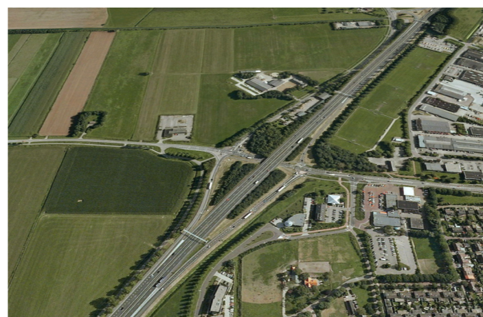
Luchtfoto van de aansluiting Griethse poort bij Zevenaar die zal vervallen.
