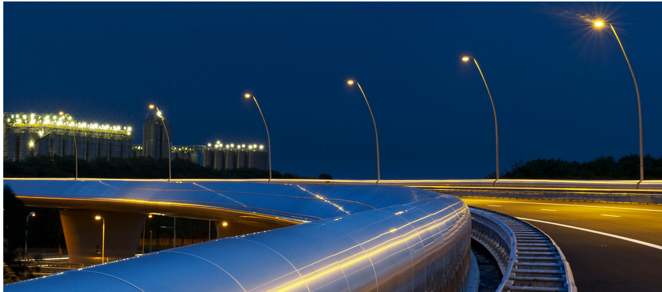
Voorbeeld van een sierlijk gebogen viaduct - mooie vloeiende lijn - met bijpassende/meeontworpen rand, verlichting en enkelvoudige steunpunten die de vormgeving versterken/ondersteunen. Tevens voorbeeld van een scenic route met mooi uitzicht op de omgeving. Voorbeeld: knooppunt Kerensheide. Het is belangrijk dat vanaf de boog van knooppunt Oudbroeken het omringende landschap ervaren kan worden.
