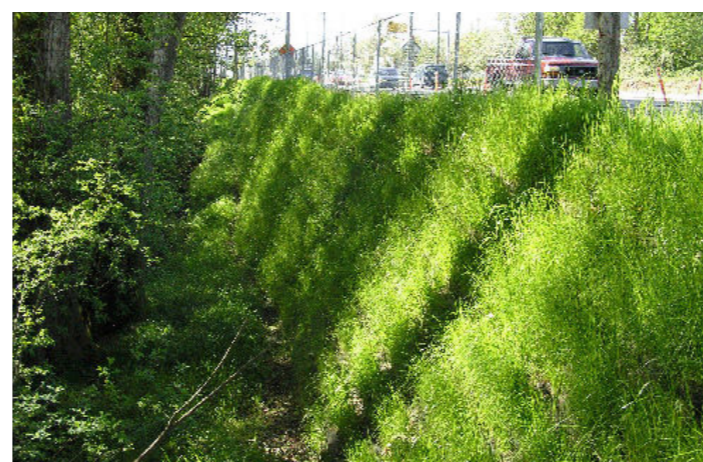
Groene grondkering als steile graswand, voorzien aan de zuidkant van de A12.
