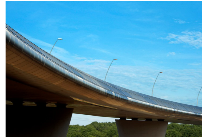
Voorbeeld van een sierlijk gebogen viaduct met vloeiende belijning en bijpassende/meeontworpen rand, verlichting en steunpunten (knooppunt Kerensheide).
